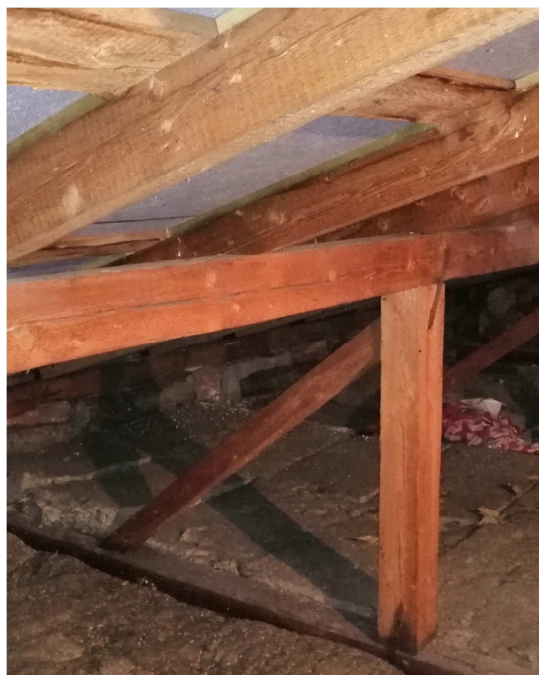
Fot.2 Widok strefy podporowej więźby dachowej
