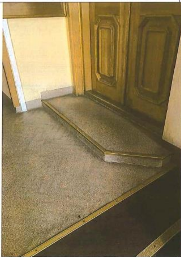
Zdjęcie nr 7 – Stopień zawężający spocznik do 38 cm na piętrze I klatki schodowej 1
