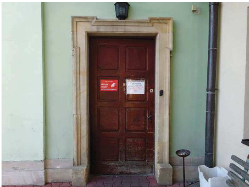
Fot. 5 Wyeksplloatowane, uszkodzone drzwi zewnętrzne DZ1 na elewacji wschodniej
