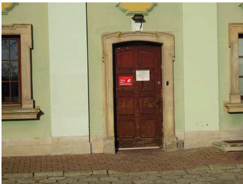
Fot. 7 Wyeksploatowane, uszkodzone drzwi zewnętrzne DZ3 na elewacji południowej
