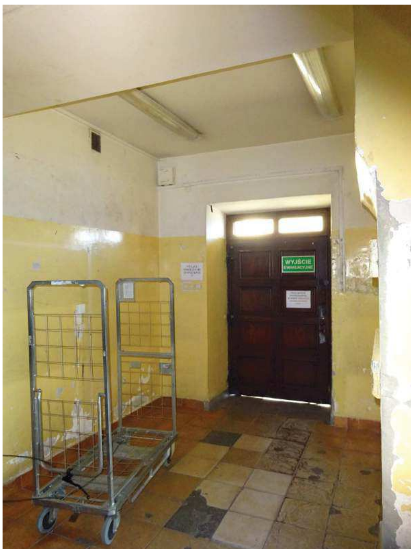
Fot. 8 Zniszczona posadzka z płytek gresowych
