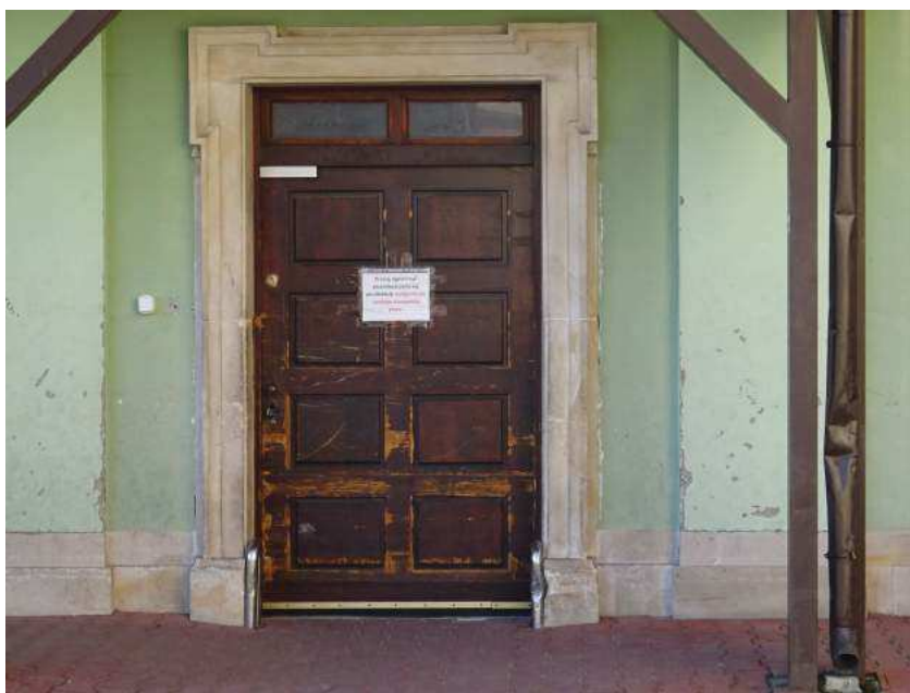
Fot. 6 Wyeksplloatowane, uszkodzone drzwi zewnętrzne DZ2 na elewacji wschodniej
