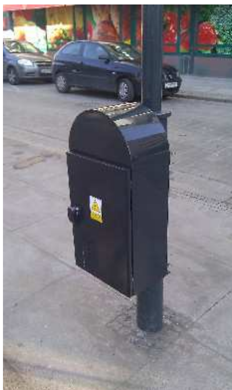
Zdj.3: Przykład instalacji szafki słupowej „stylizowanej”
