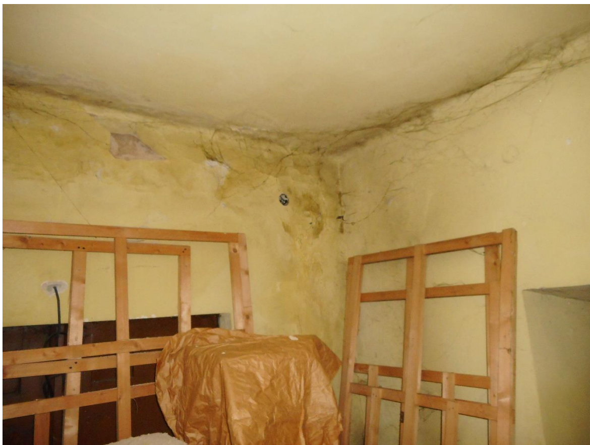
Zawilgocone tynki wewnątrz kościoła.
