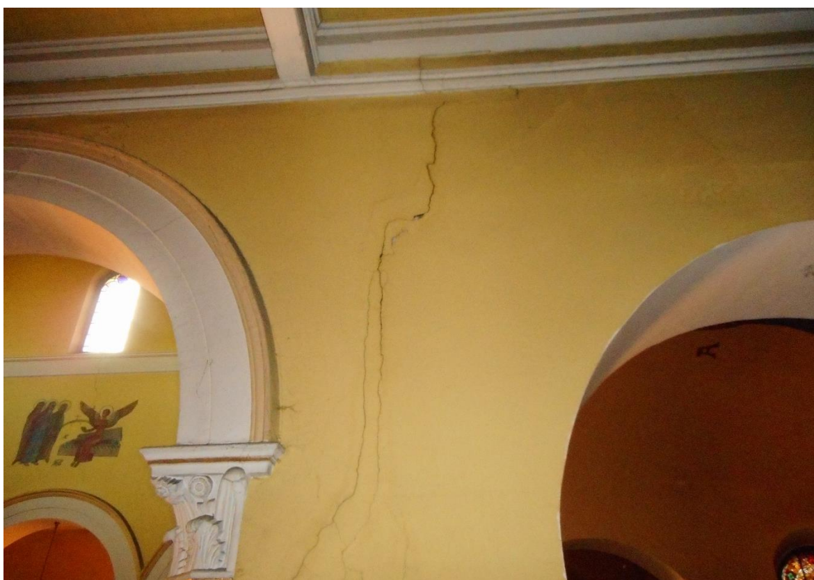
Pęknięcie ściany wewnątrz kościoła.
