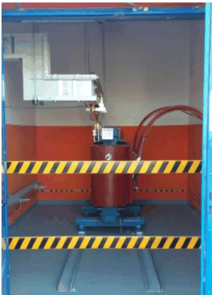
Zdjęcie nr 11. Przykład rozmieszczenia barier ochronnych w komorze transformatorowej
