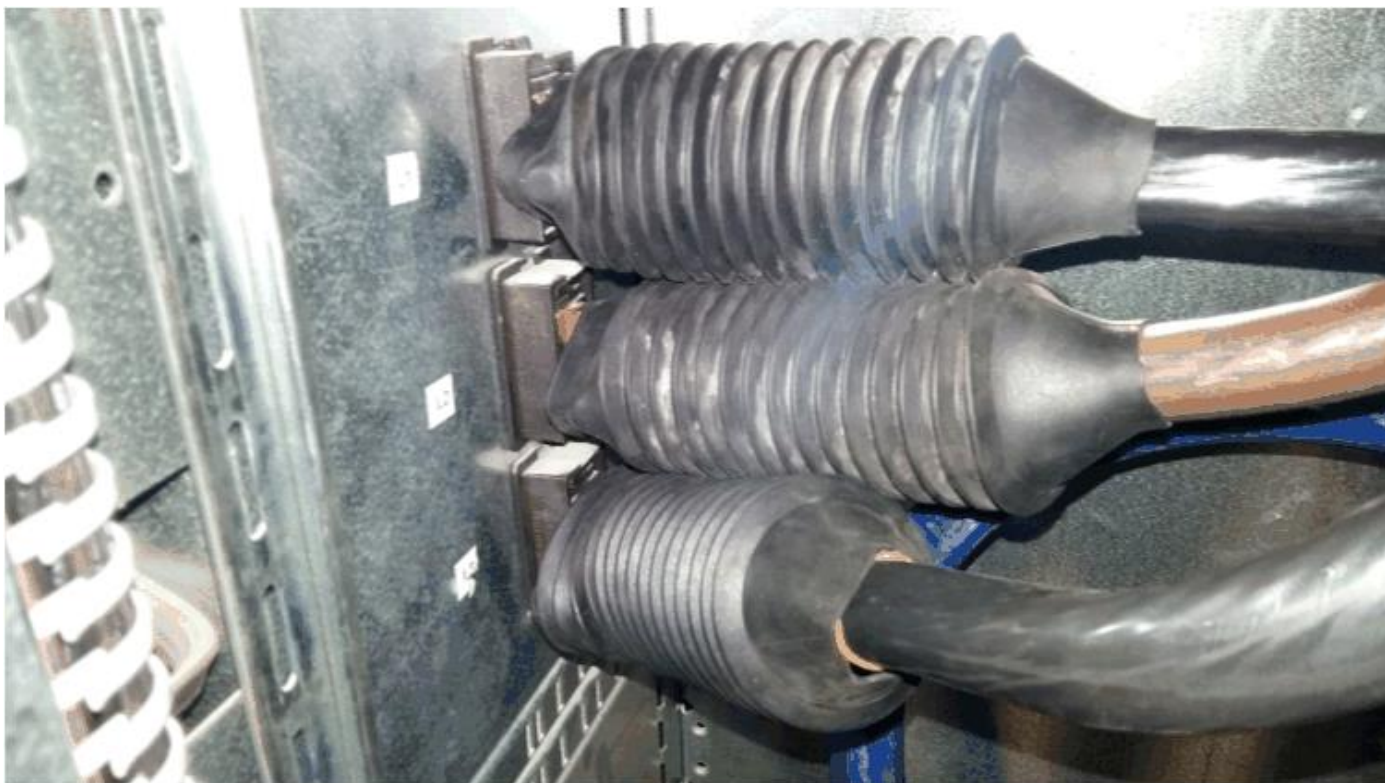
Zdjęcie nr 2. Sposób montażu mieszka izolacyjnego
