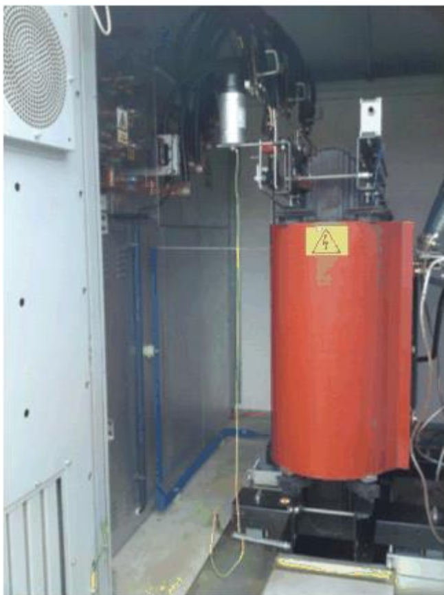
Zdjęcie nr 8. Mocowanie kondensatora do kompensacji biegu jałowego
