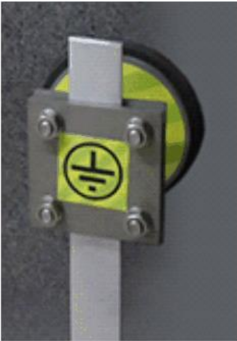
Zdjęcie nr 13. Szczelny przepust śrubowy do wyprowadzenia płaskownika uziemiającego
