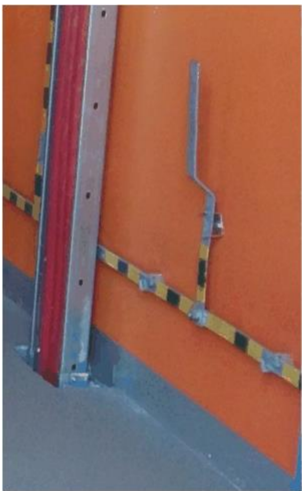
Zdjęcie nr 12. Sposób wyprowadzenia płaskownika do mocowania zacisku uziomowego uziemiaczy przenośnych
