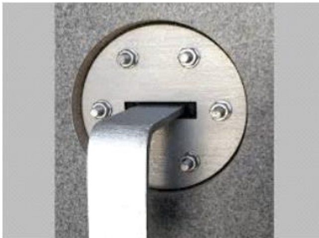
Zdjęcie nr 9. Przepust do wyprowadzania płaskownika poprzez ścianę stacji
