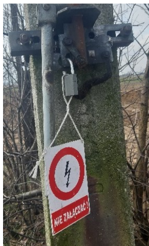
Rysunek 14 Przykład oznakowania i zabezpieczenia
