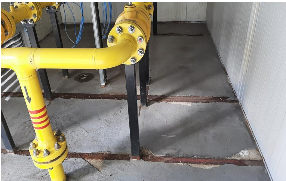
Zdj. 8, 9 Widok uszkodzeń posadzki iskrobezpiecznej.
