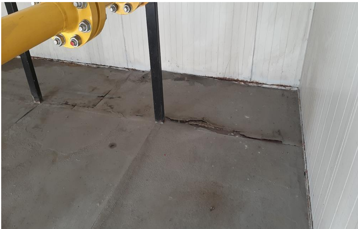
Zdj. 6, 7 Jedno z miejsc występowania korozji na konstrukcji i obudowach kontenerów.
