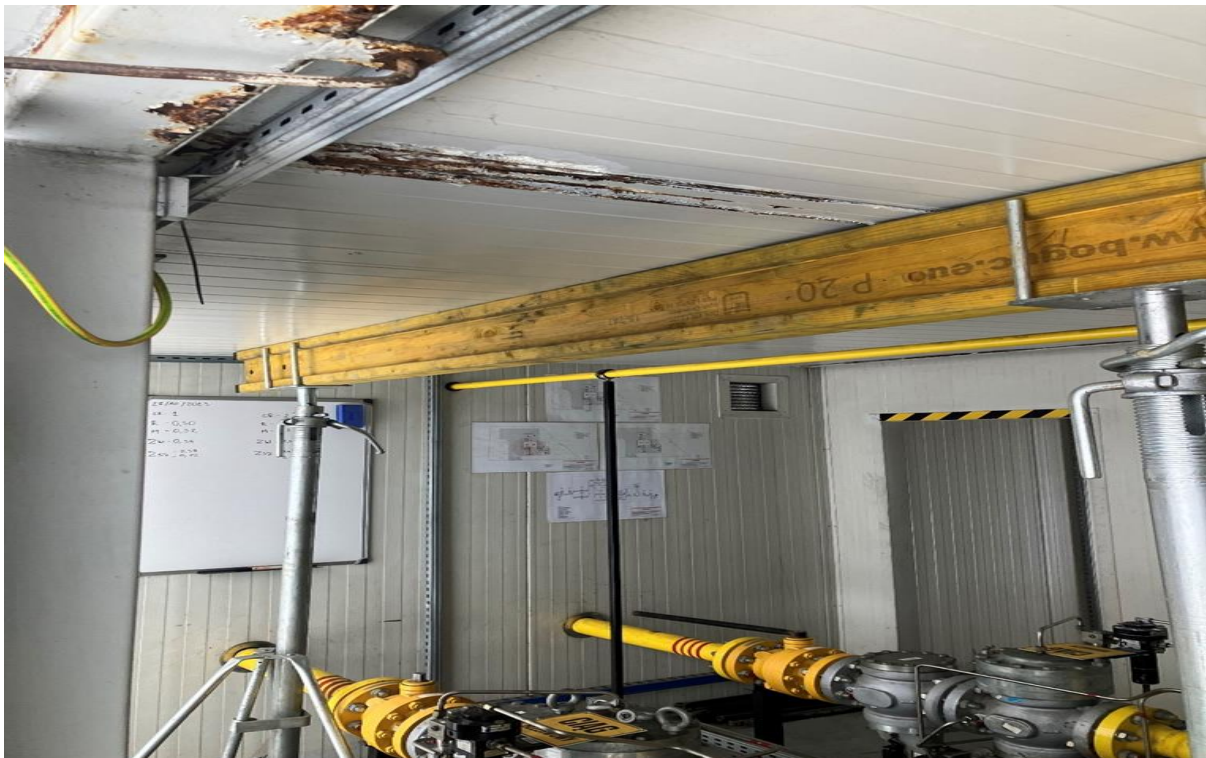
Zdj. 4,5 Kontener układu pomiarowego. Dach od wewnątrz kontenera zabezpieczony podporami przed dalszym uginaniem się.
