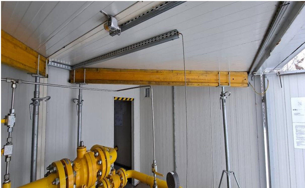
Zdj. 4,5 Kontener układu pomiarowego. Dach od wewnątrz kontenera zabezpieczony podporami przed dalszym uginaniem się.
