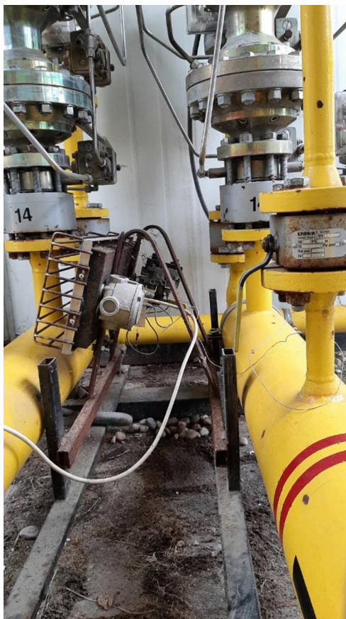
Zdj. 11,12 Promiennik podczerwieni INFRACAT Seria Ex z zaworem Maxitrol
