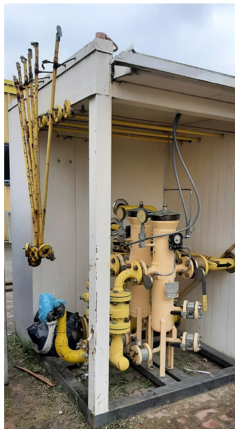
Zdj.6 Układ filtrów oraz demontowalne rury upustowe.
