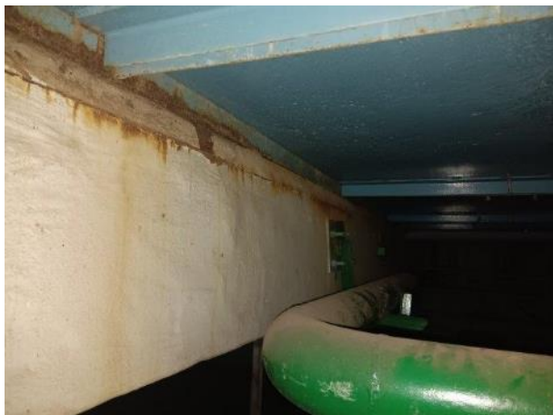
Zdjęcia nr 14-17. Widok podciągów żelbetonowych podlegających pracom naprawczym
