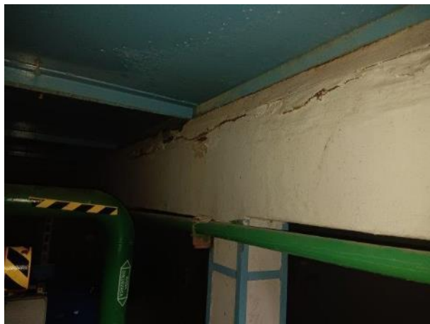
Zdjęcia nr 14-17. Widok podciągów żelbetonowych podlegających pracom naprawczym
