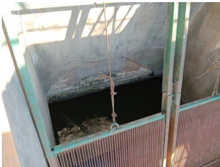
Zdjęcia nr 23-24. Uszkodzenia w powierzchniach żelbetowych
