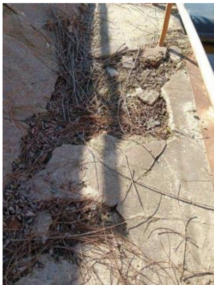
Zdjęcia nr 23-24. Uszkodzenia w powierzchniach żelbetowych
