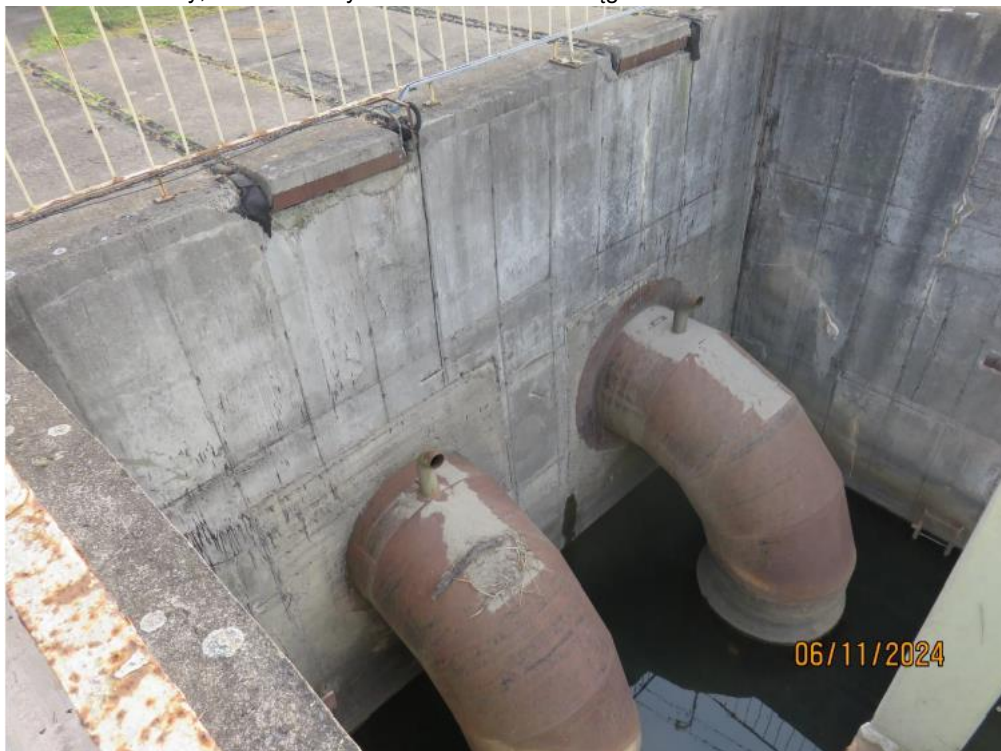
Zdjęcie nr 5. Zrzut wody chłodzącej do Odry przy budynku T9
