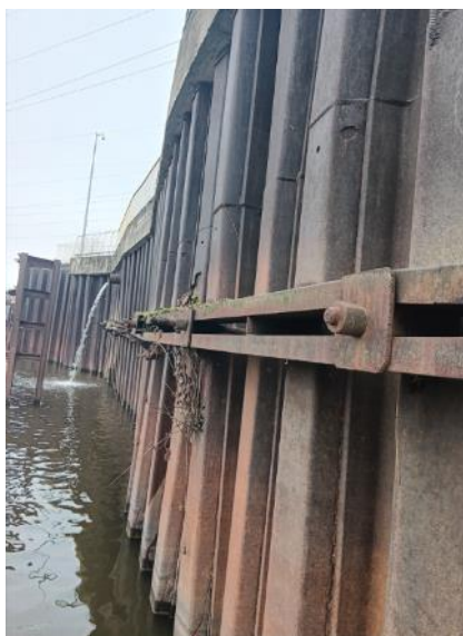
Rys. nr 40. Szczegół zakotwienia odciagu w ścianie szczelnej typu Larssen
