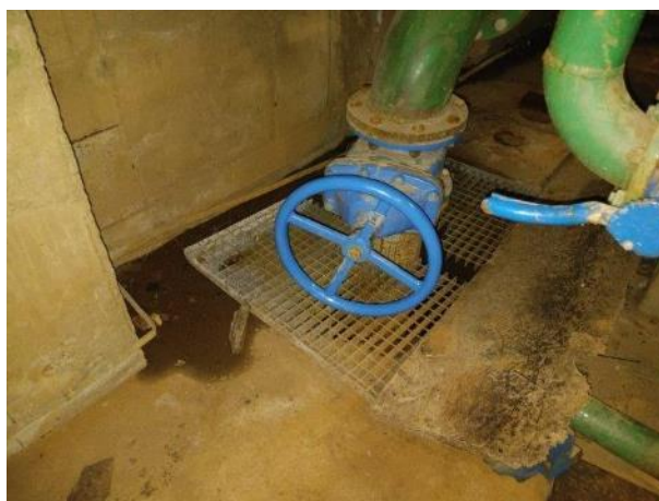
Zdjęcie nr 22. Uszkodzona ażurowa krata przy pompie na poziomie -1
