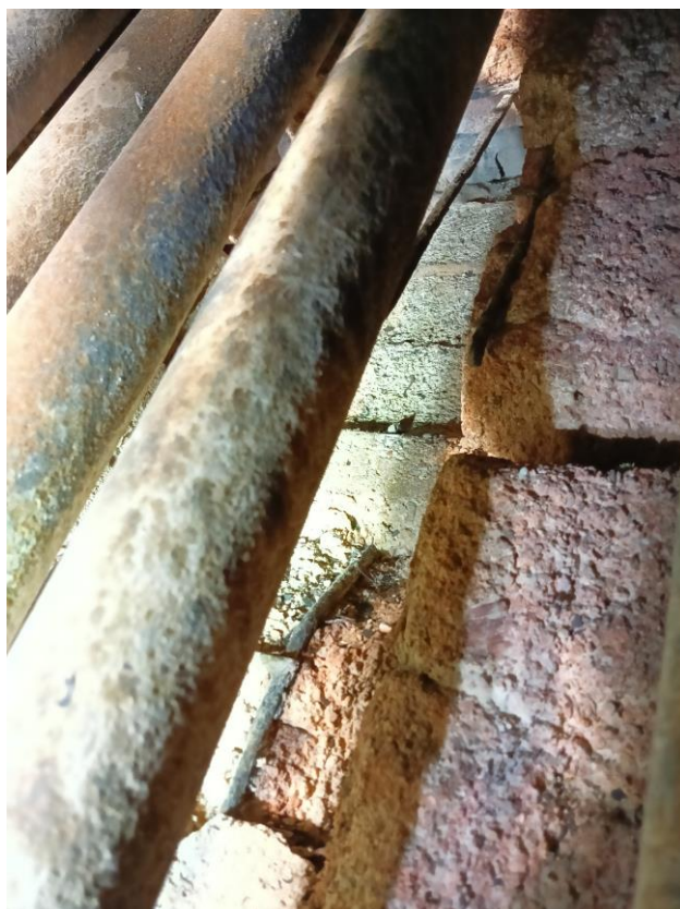
Fot. nr 1 Przykładowy stan obmurza na przewale kotła.
