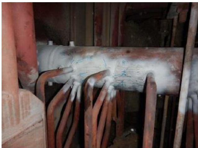
Rys. 6. Sześć wskazań na króćcach na części prawej komory po prawej stronie kotła, dwa pierwsze rzędy króćców od strony prawej. Widok od tyłu kotła.
