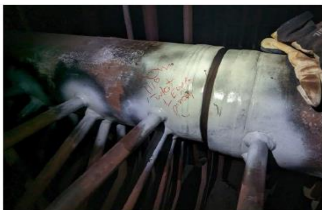
Rys. 4. Dwa wskazania na części lewej komory w miejscu podziału komory. Widok od przodu kotła.
