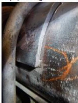
Rys. 9 Wskazanie na spoinach łączących podkładkę pod obejmą z rurociągiem. Schładzacz SP2 tył strona lewa.
