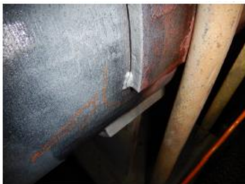
Rys. 5 Wskazanie na spoinach łączących podkładkę pod obejmą z rurociągiem. Schładzacz SP2 przód strona prawa
