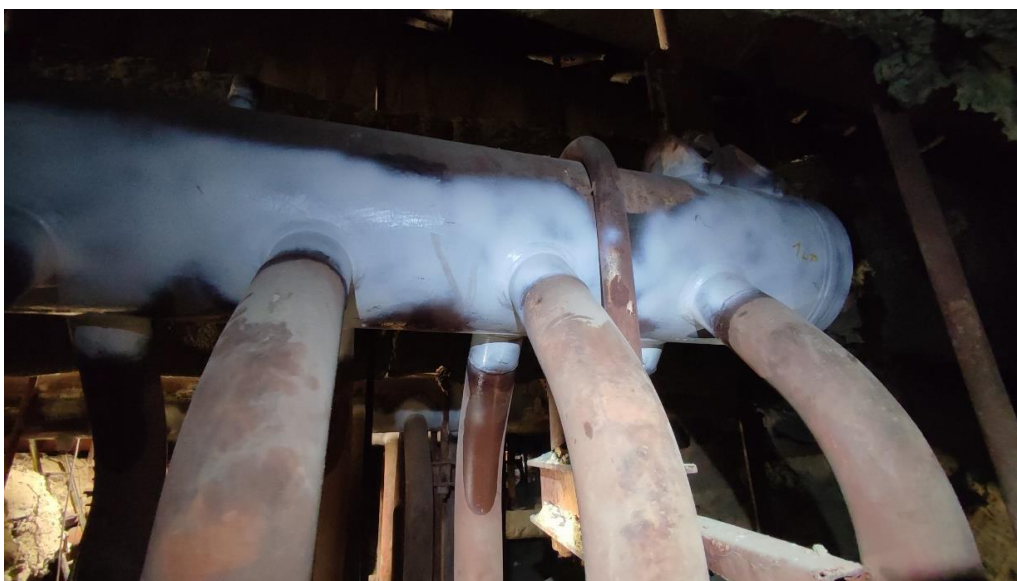
Rysunek 15 Schładzacz pary I st.
