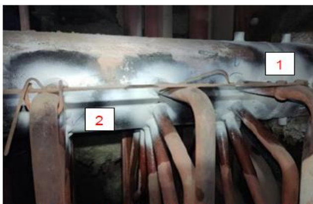
Rys. 2. Dwa wskazania na króćcach na części lewej komory patrząc od tyłu kotła.
