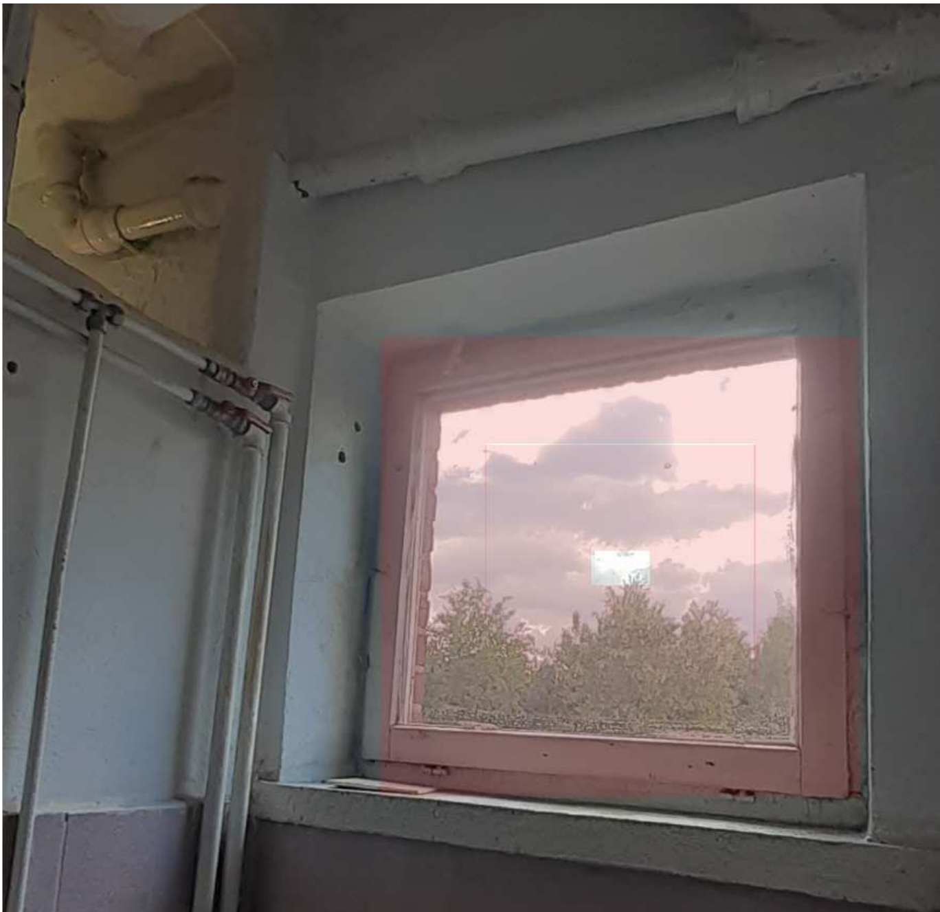
Rysunek 5. Drewniane okno uchylne fasady południowej w pom. gospodarczym (zaplecza sanitarnego)
