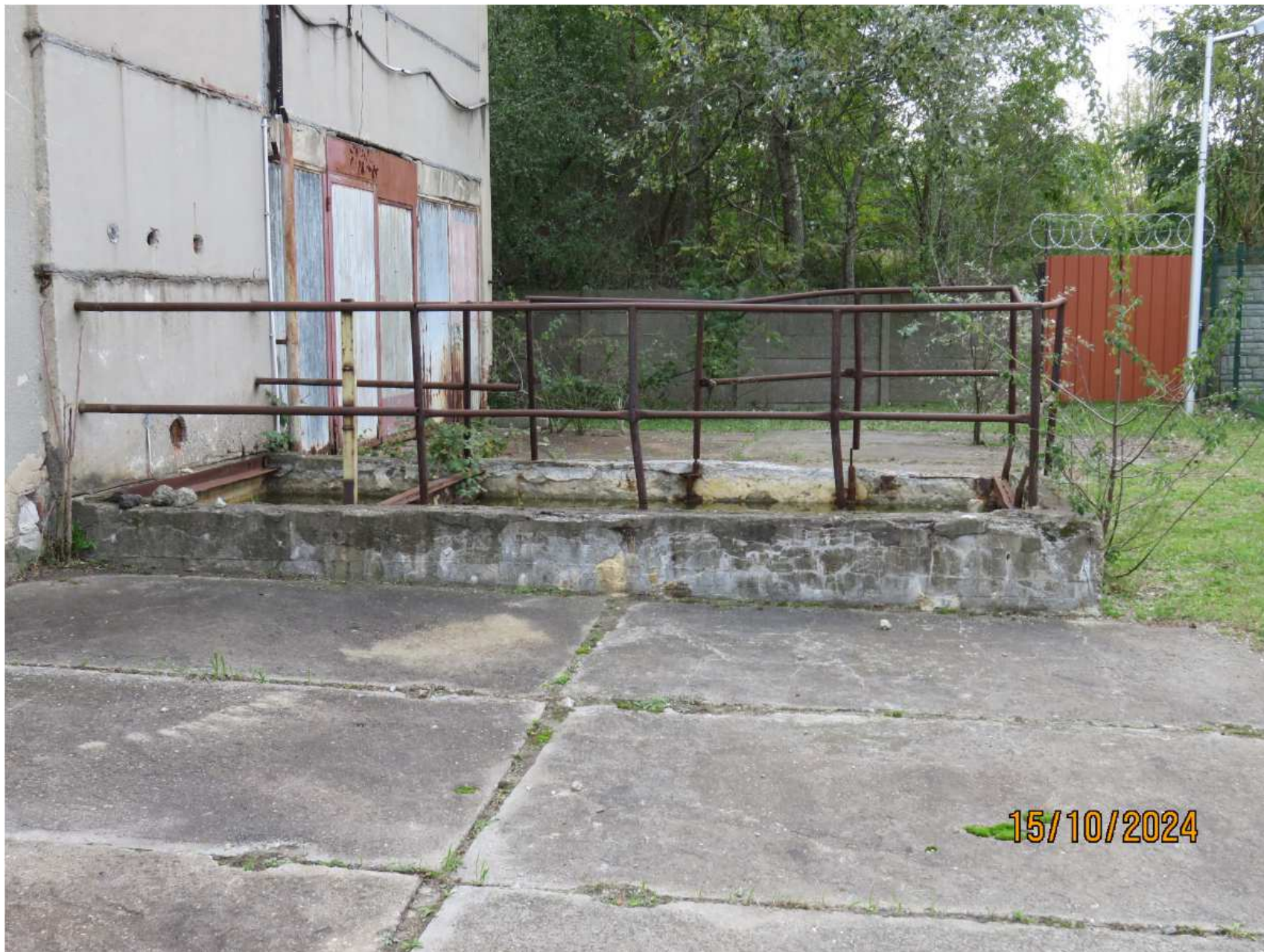
Rysunek 13. Zewnętrzny otwarty żelbetowy zbiornik solanki (do rozbiórki)
