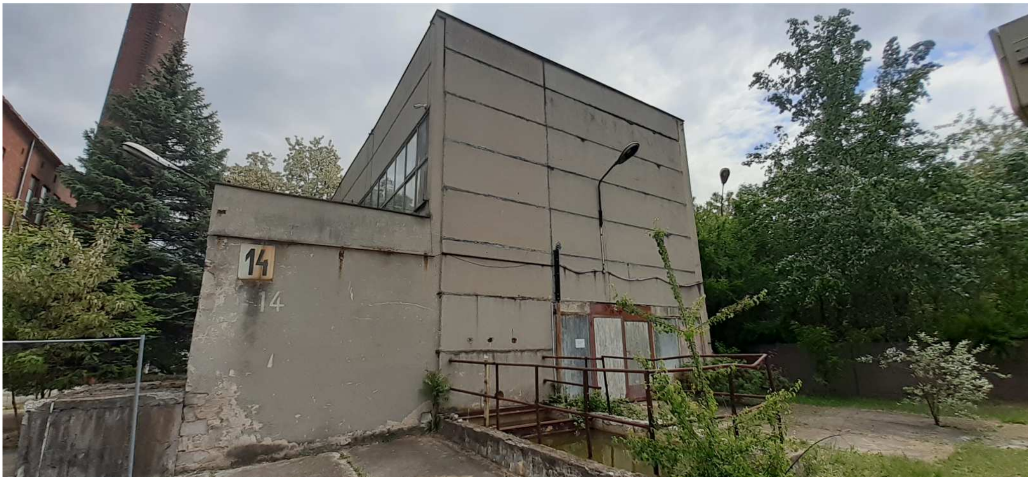
Rysunek 6. Część niższa budynku (konstrukcja murowana) wraz z rampą żelbetową wzdłuż fasady północnej SUW (przeznaczona do rozbiórki).
