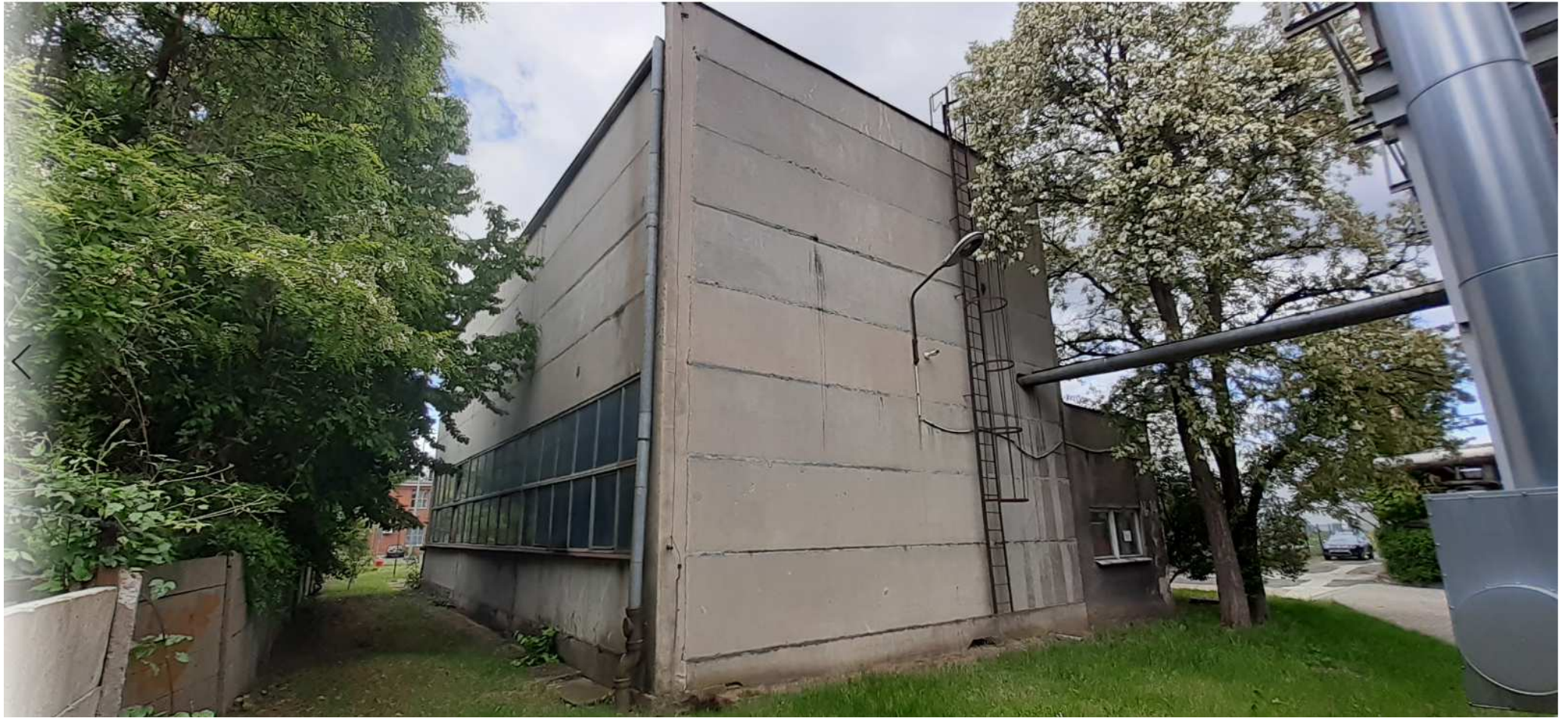
Rysunek 2 Widok na bud. SUW od strony południowo wschodniej. Technologiczny rurociąg napowietrzny na wysokości 4m należy zdemontować. Drzewo do zabezpieczenia na czas rozbiórki.
