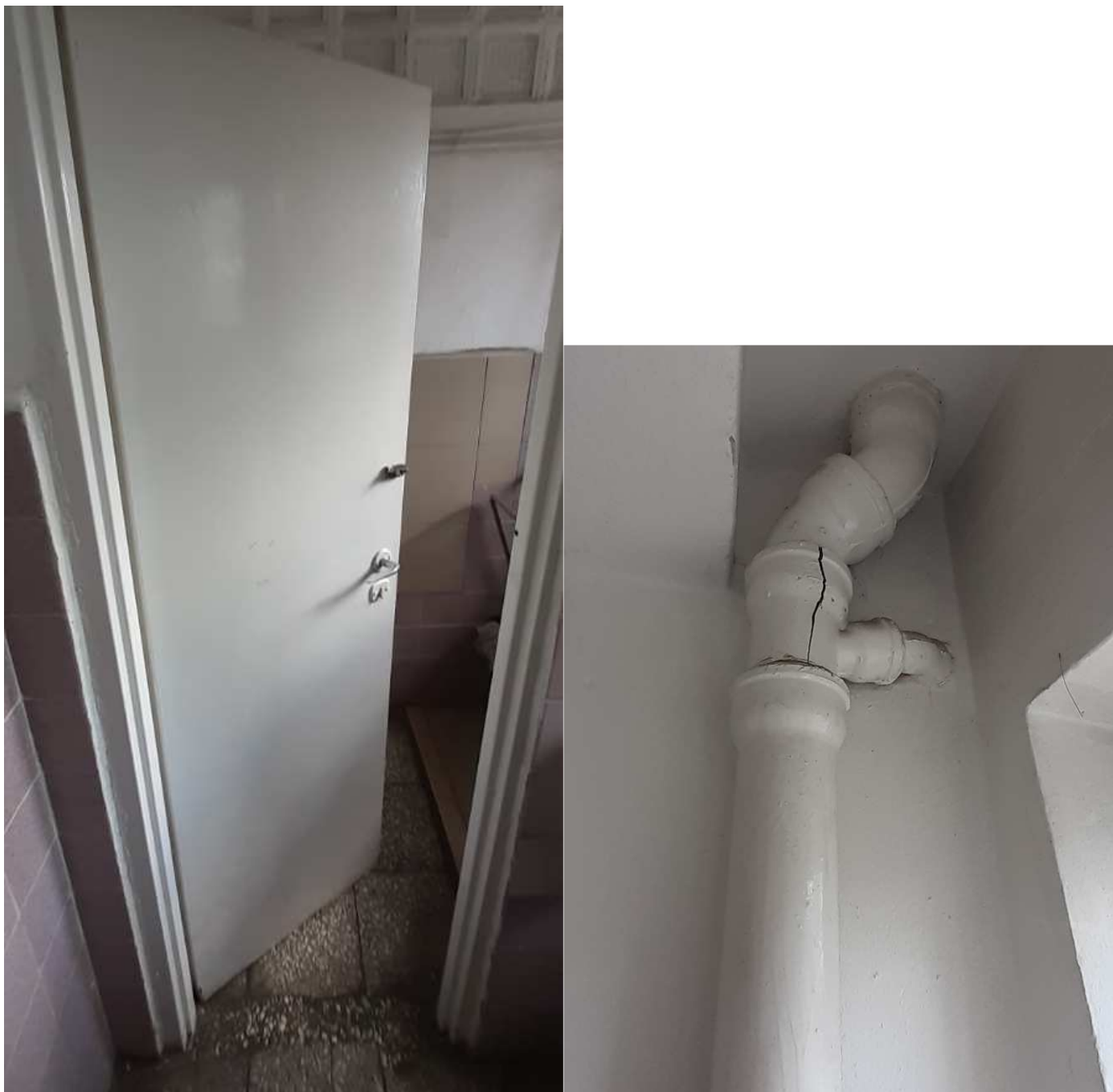
Rysunek 7. Drzwi do WC – do wymiany. Uszkodzony trójnik żeliwny – do wymiany lub uszczelnienia.
