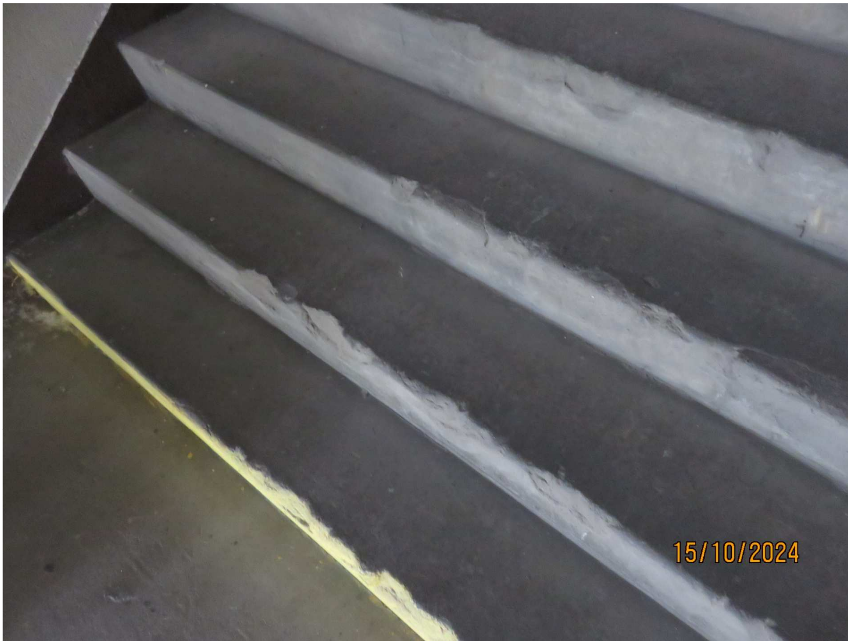
Rysunek 10. Uszkodzenia i ubytki schodów wejścia głównego do budynku.
