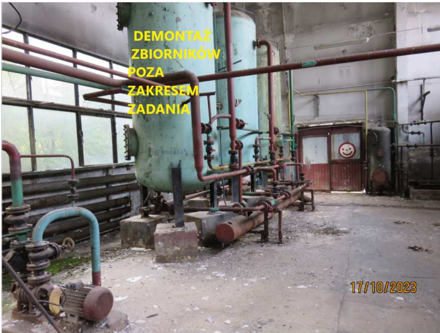
Rysunek 11. Wnętrze hali produkcyjnej Stacji Uzdatniania Wody. Poniżej pompy (lewy dolny róg fotografii) zlokalizowany podziemny żelbetowy zbiornik wody zdekarbonizowanej ca 40m 3
