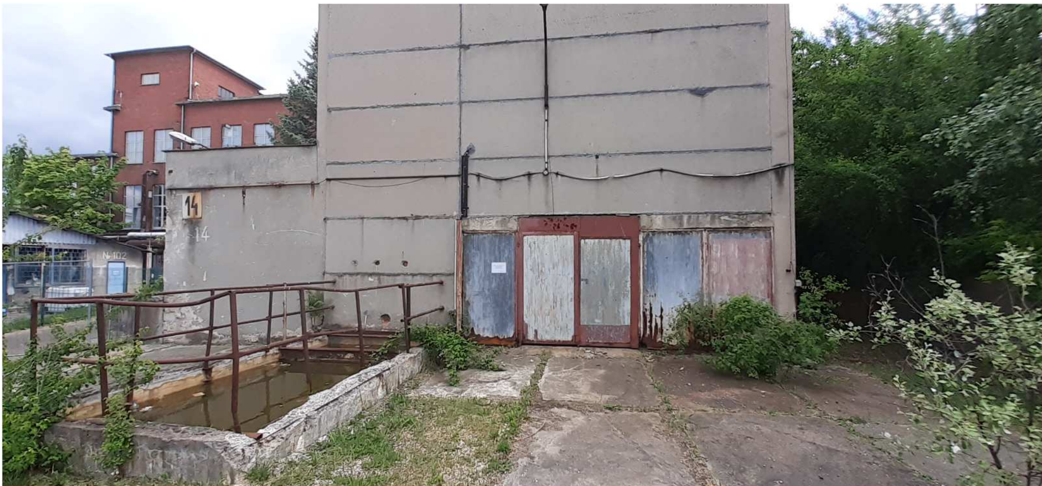
Rysunek 5. Żelbetowy zbiornik solanki przy zachodniej fasadzie budynku – przeznaczony do rozbiórki.
