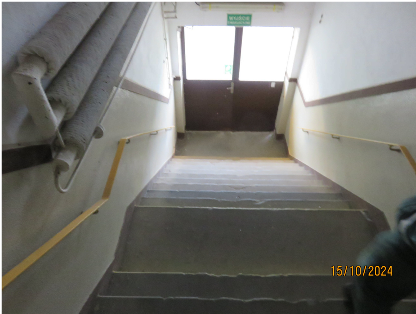
Rysunek 9. Schody wejścia głównego na poz. +4,5m. Ubytki stopni.
