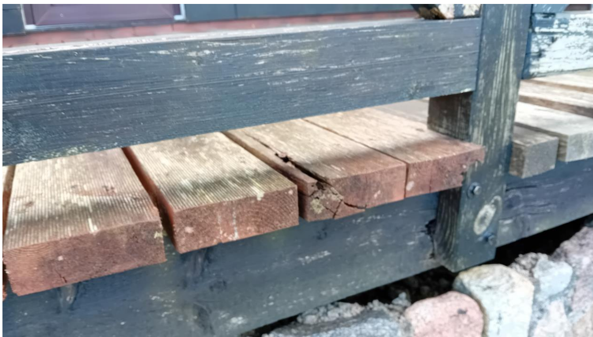
Fot. 7. Taras drewniany przy „bosmance” – wybrane elementy drewniane do wymiany
