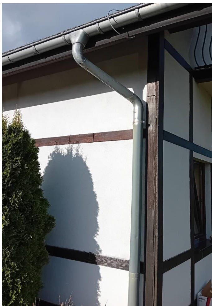
Fot. 9, 10. Rury spustowe do wymiany
