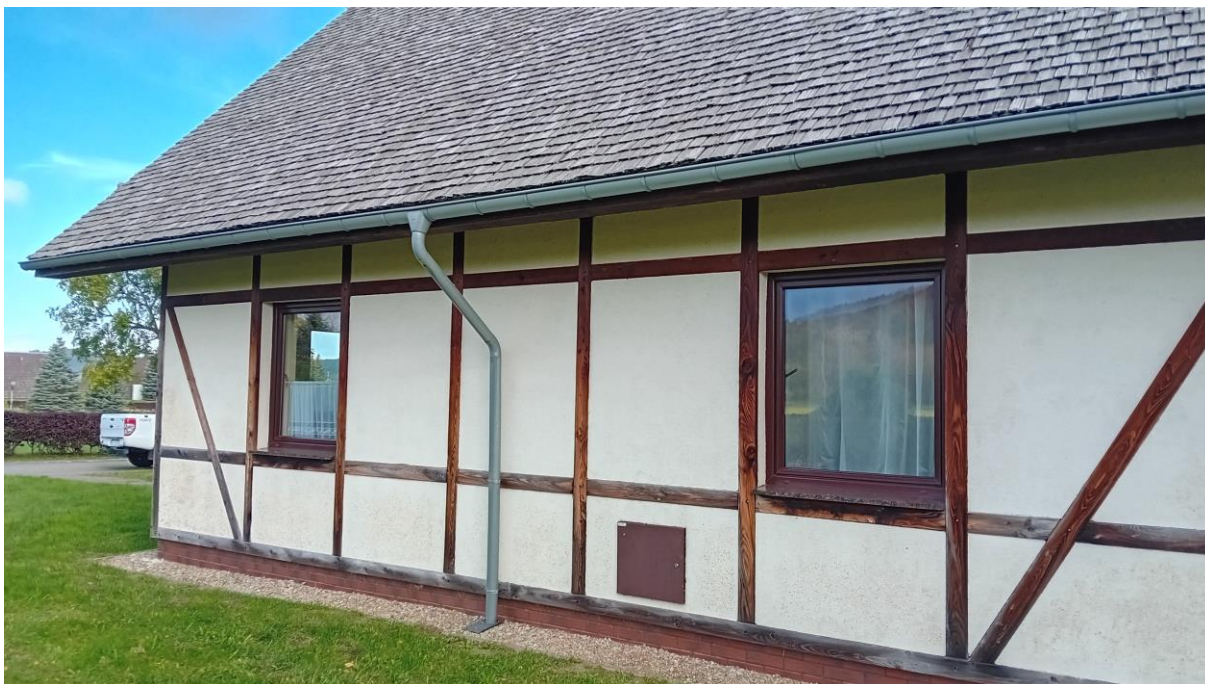
Fot. 19. Rury spustowe do wymiany
