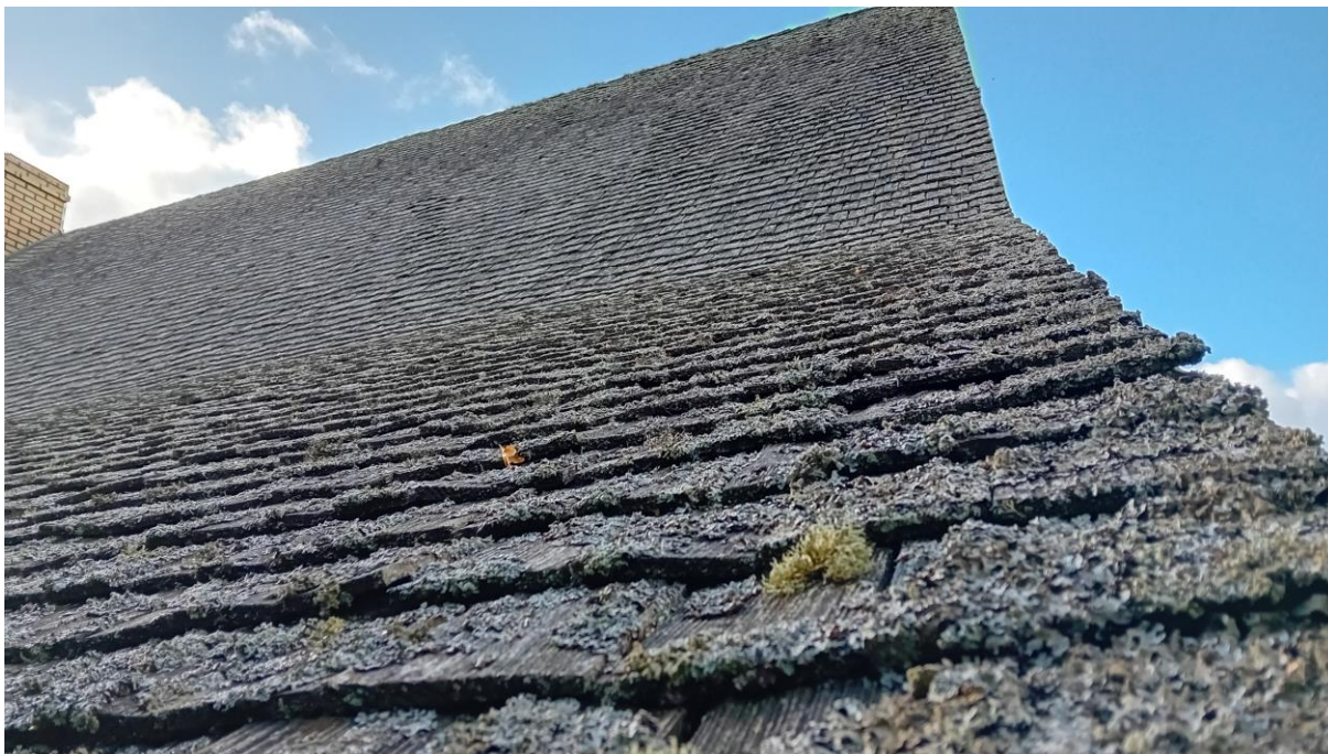
Fot. 18. Połacie dachowa z gontu /do czyszczenia oraz impregnacji/
