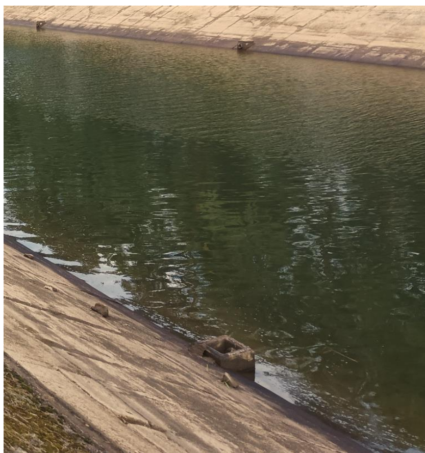
Fot. 4 – Uszkodzona skrzynka betonowa, bez płyty przykrywającej .
