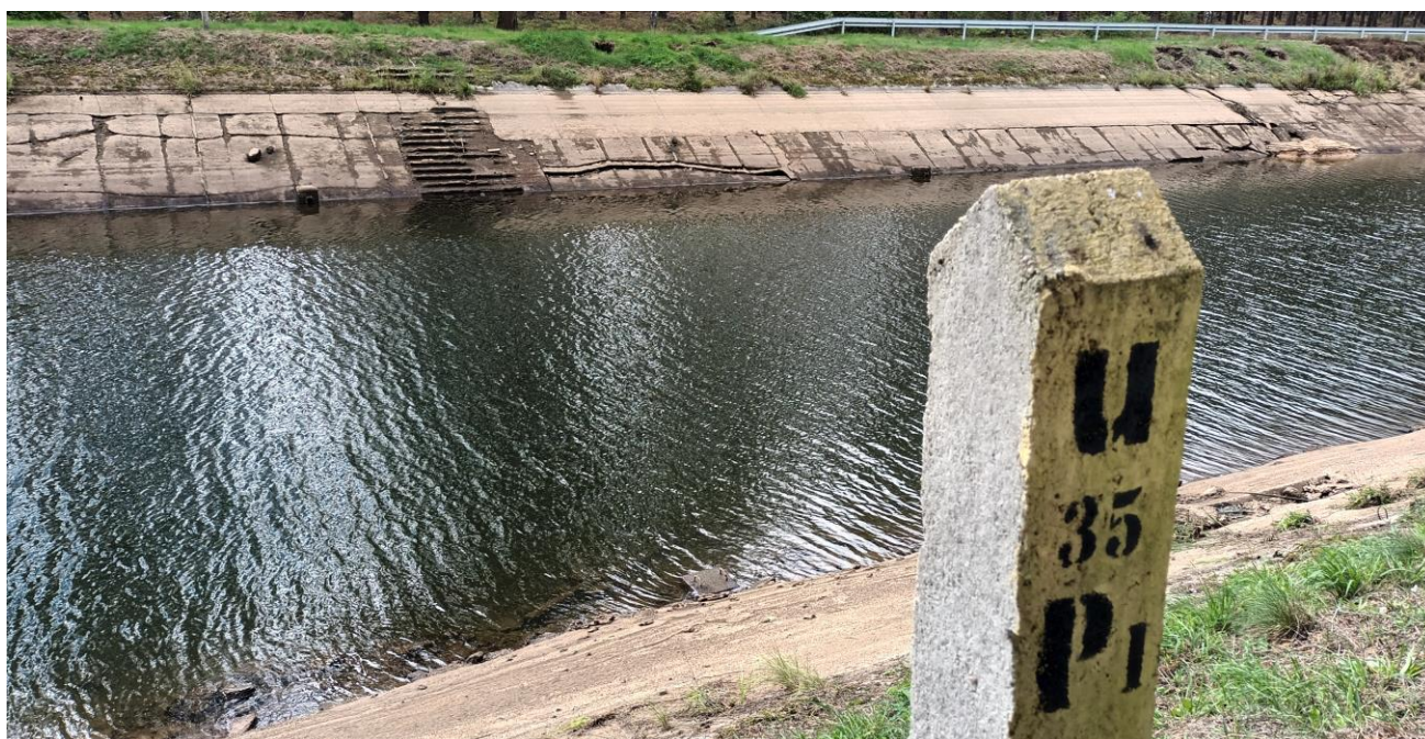
Fot. 2 – Uszkodzenia umocnień betonowych na lewej skarpie kanału derywacyjnego w rejonie km 6+970
