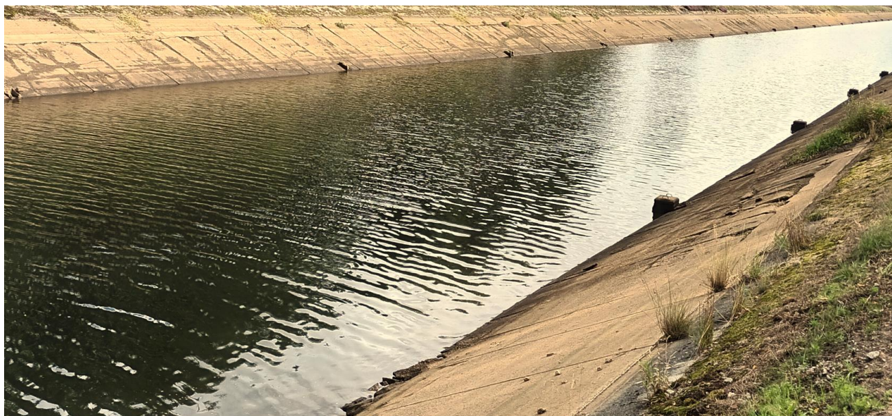
Fot. 3 – Wyloty drenarskie na skarpach kanału w rozstawie co 12 m. Skrzynki betonowe, zabezpieczające klapy zwrotne zainstalowane na wylotach drenarskich – widok po obniżeniu lustra wody do rzędnej ok. 71,00 m n.p.m.
