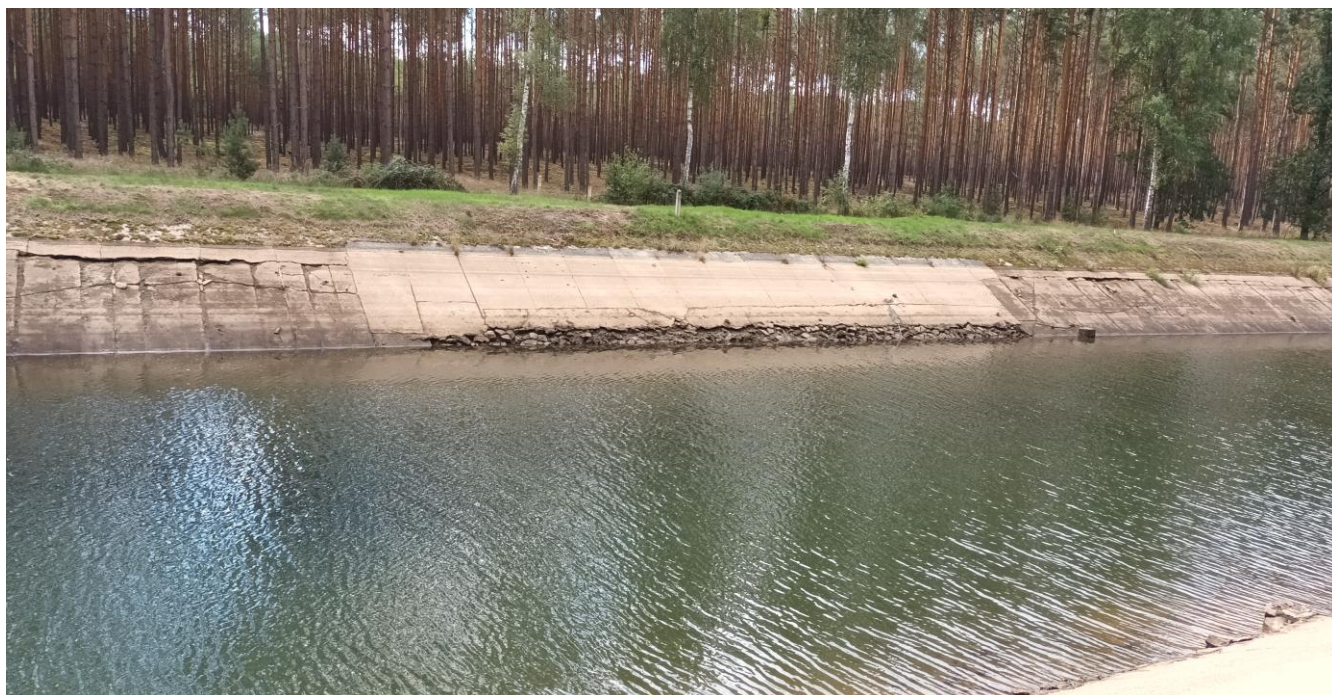
Fot. 1 – Uszkodzenia umocnień betonowych na prawej skarpie kanału derywacyjnego w rejonie km 6+870
