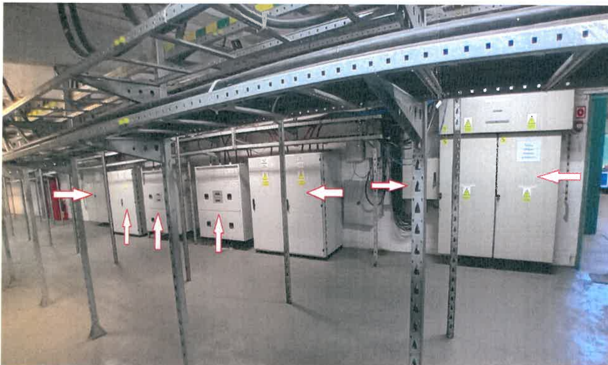
Zdjęcie 9. Kablownia – widok szaf przekładnikowych, szaf zabezpieczeń i transformatorów wzbudzenia – przewidzianych do przeniesienia
