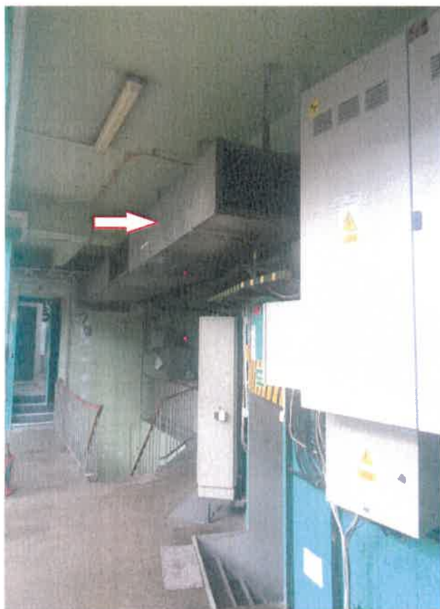
Zdjęcie 7. Szynoprzewód generatora G1
