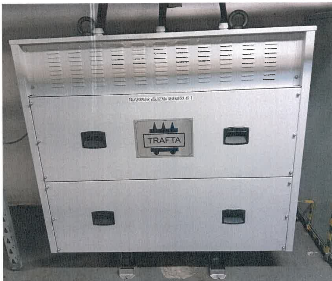
Zdjęcie 12. Transformator wzbudzenia generatora G1.
