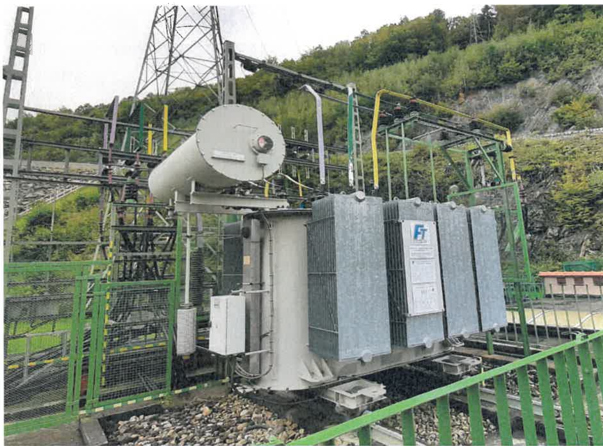
Zdjęcie 2. Widok transformatora blokowego nr 2.
