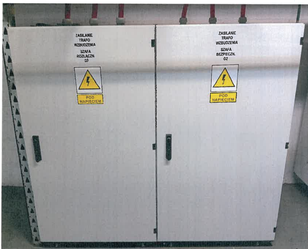
Zdjęcie 15. Szafa zabezpieczeń i rozłącznika transformatora wzbudzenia generatora G1.
