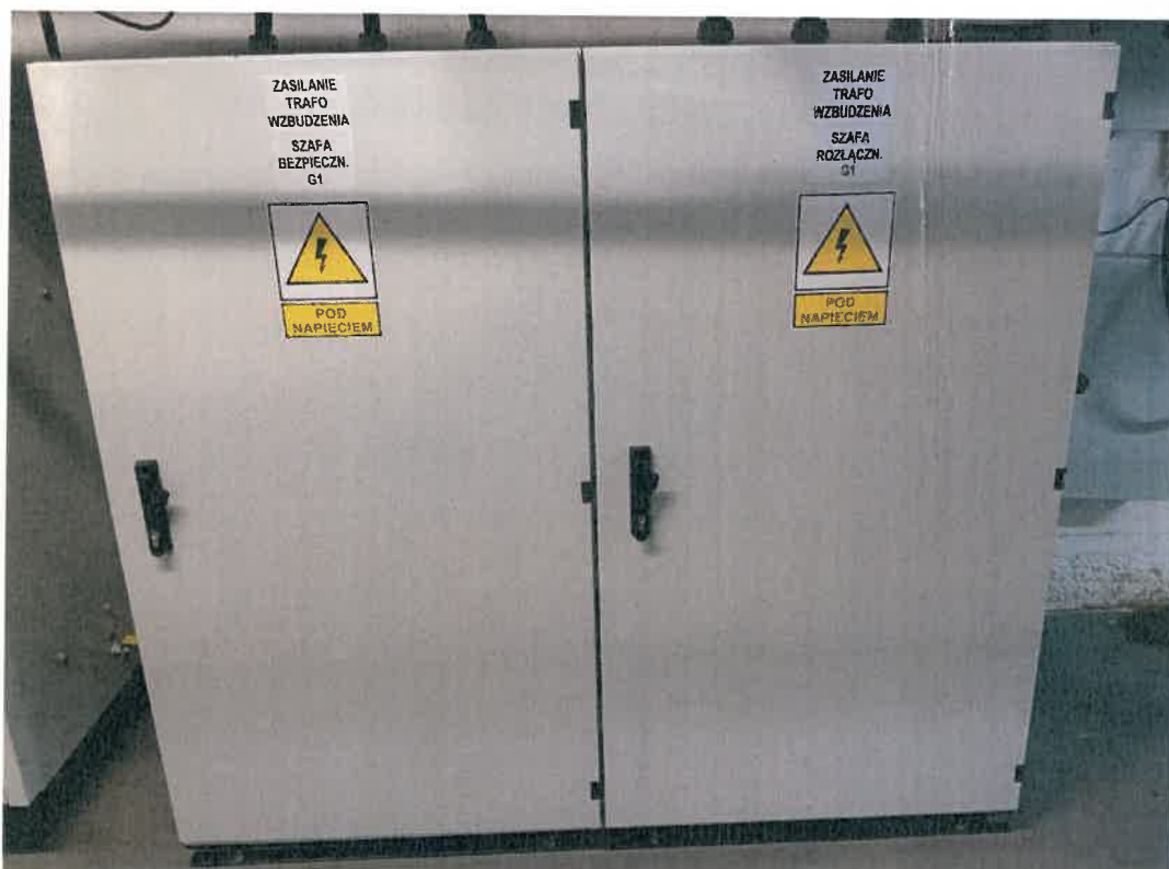
Zdjęcie 14. Szafa zabezpieczeń i rozłącznika transformatora wzbudzenia generatora G1.
