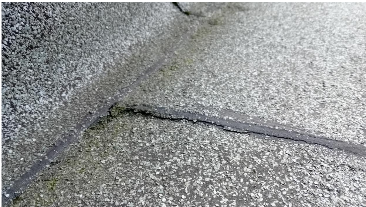
Fot. 5. Luźne fragmenty – do wycięcia i ponownego pokrycia papą
