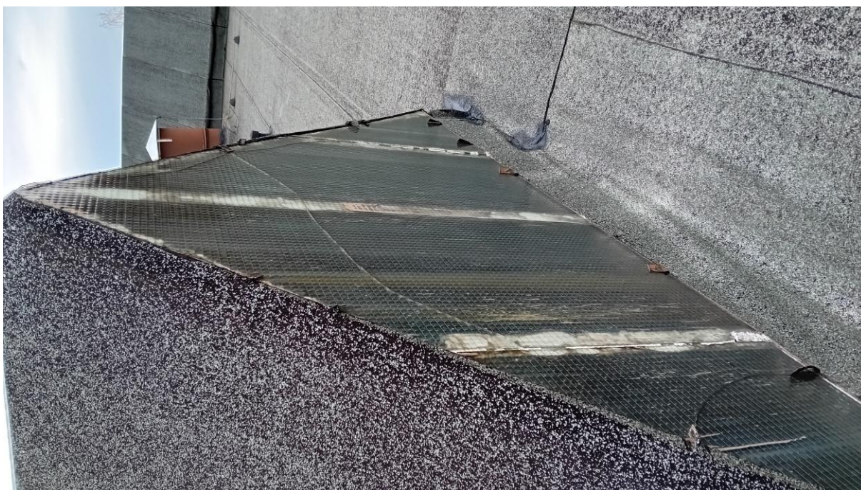
Fot. 10. Świetliki - szkło zbrojone do usunięcia (następnie montaż blachy i pokrycie membraną)
