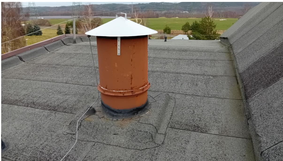
Fot. 3. Wywietrzak /łącznie 8 szt/
