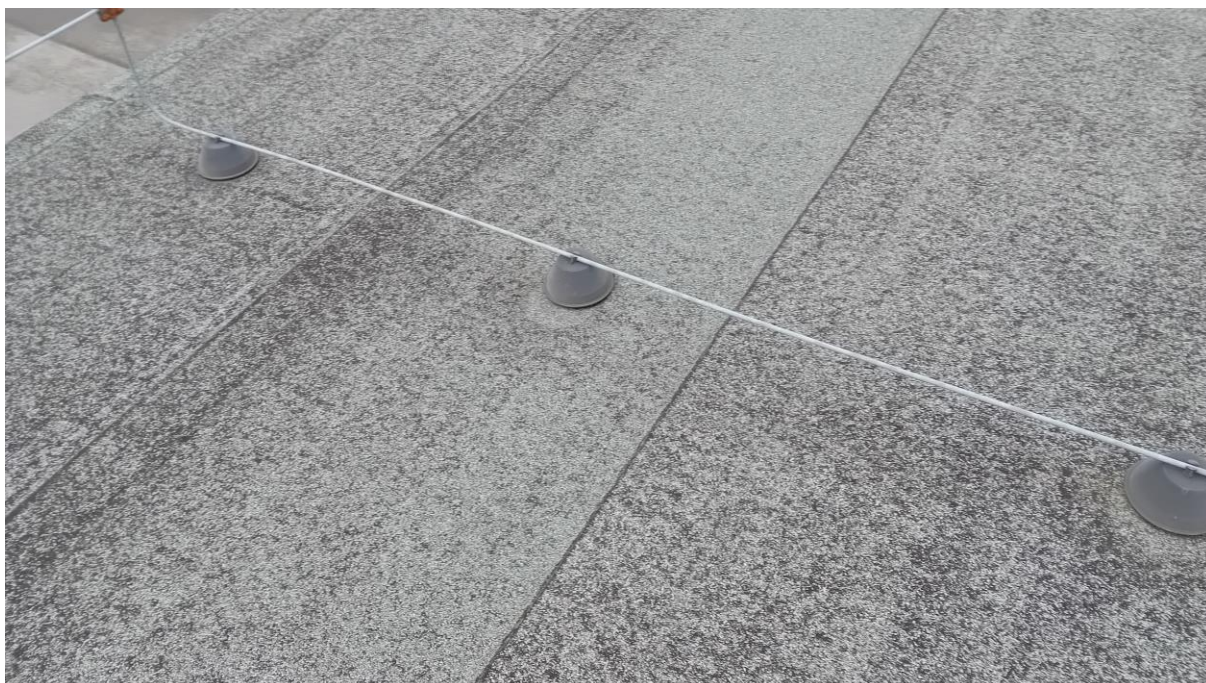
Fot.6. Instalacja odgromowa
