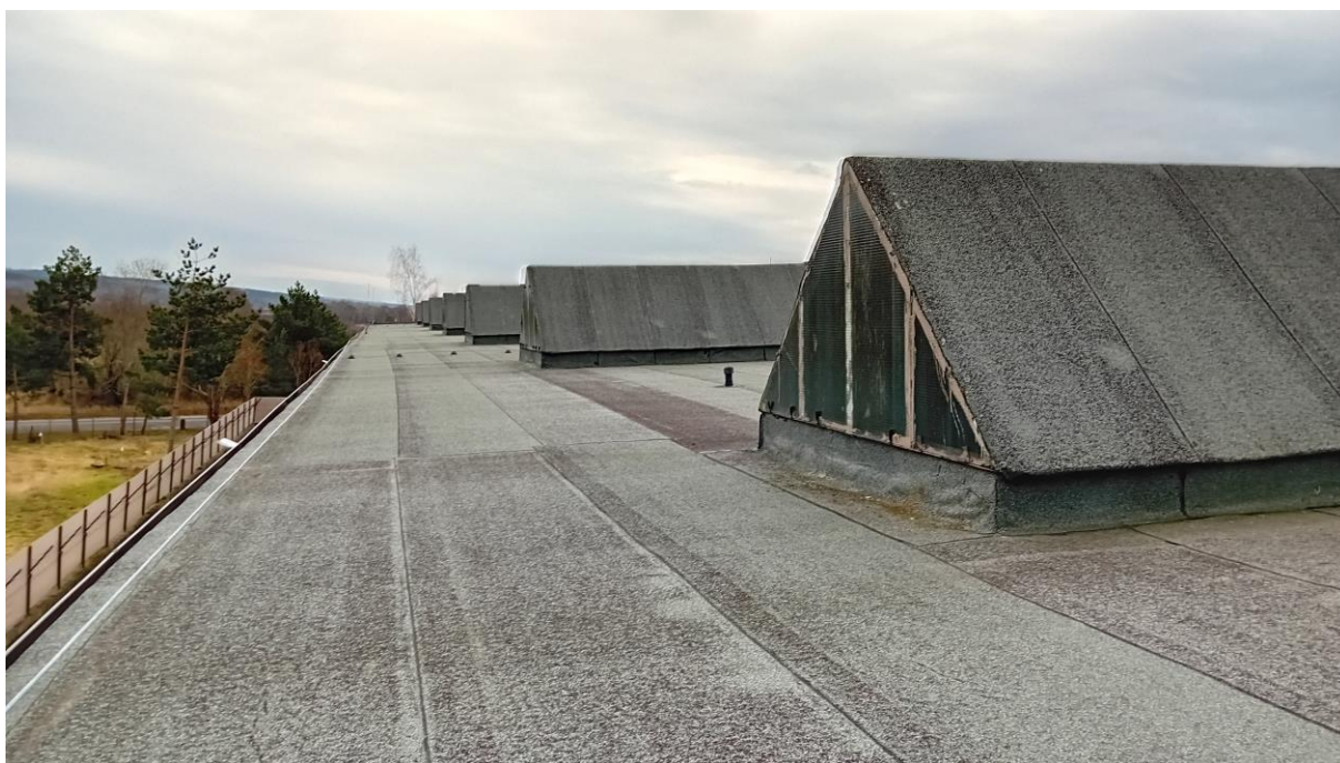
Fot. 2. Widok ogólny na połąć dachową ze świetlikami. Krawędzie dolne świetlików – luźna papa do wycięcia i wklejenia nowej papy pod docelową membranę
