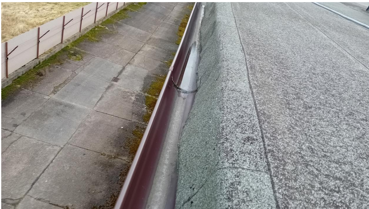
Fot. 8. Pas nadrynnowy do obróbki
