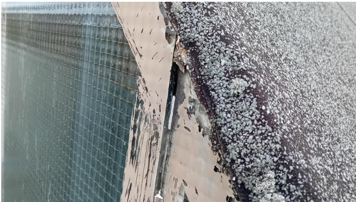
Fot. 9. Świetliki - szkło zbrojone do usunięcia (następnie montaż blachy i pokrycie membraną)
