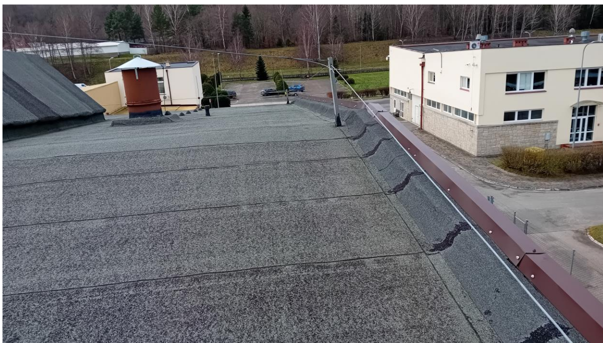
Fot. 4. Attyka z instalacją odgromową i opierzeniem blaszanym
