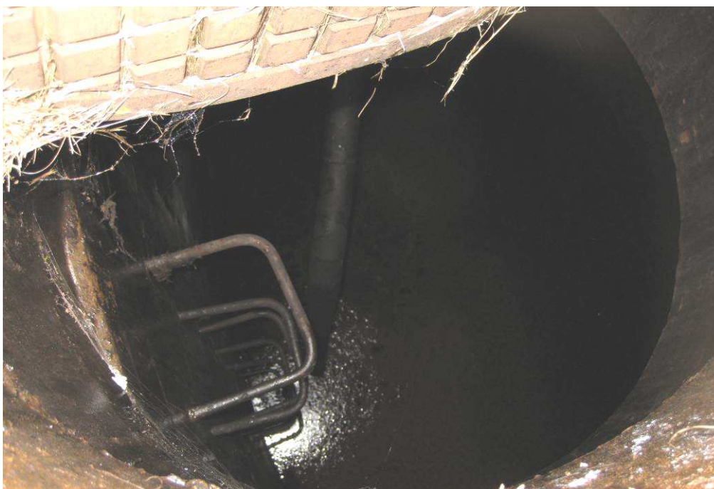
Zbiornik olejowy – widok przez właz rewizyjny; w tle kłamry wyłazowe;
