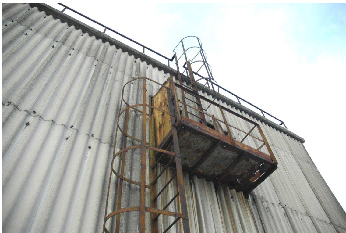
Chłodnia kominowa – drabiny i podest zewnętrzny;
