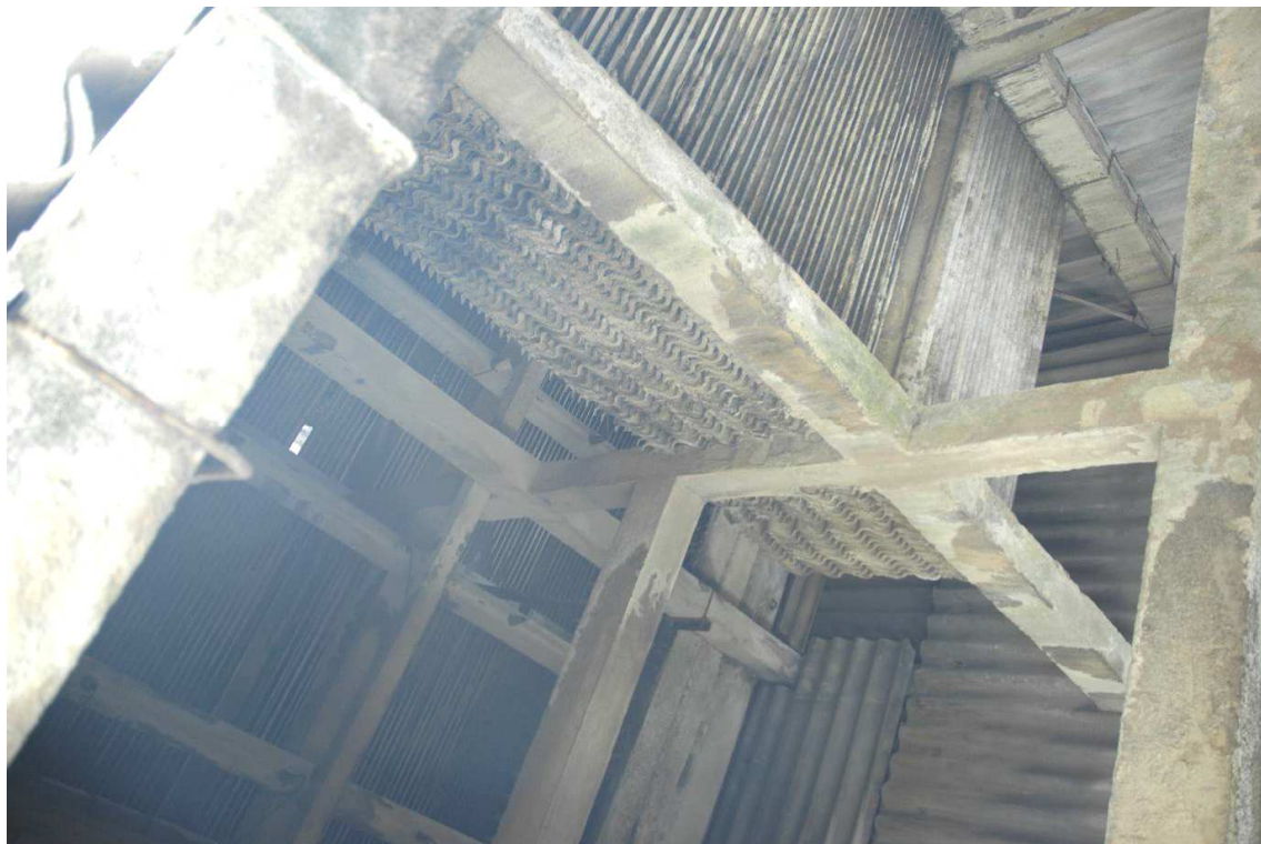
Chłodnia kominowa – widok na żelbetową konstrukcję nośną; widoczne wypełnienie - płyty azbestowe;
