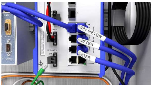
Rysunek 13: Miejsce podłączenia kabla komunikacyjnego z Megapack w sterowniku miejscowym Tesla.
