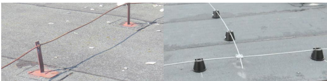
Istniejące podstawy instalacji odgromowej do likwidacji betonowe
