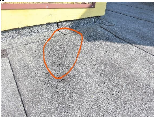
Widoczny pęcherz na podłożu z papy
