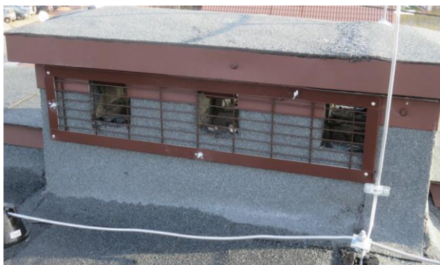
Widok komina wykończonego na ścianach z zastosowaniem papy
