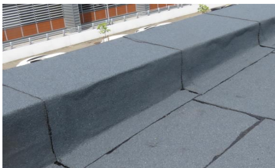
Widok prawidłowo wykonanej obróbki papowej na ścianie
