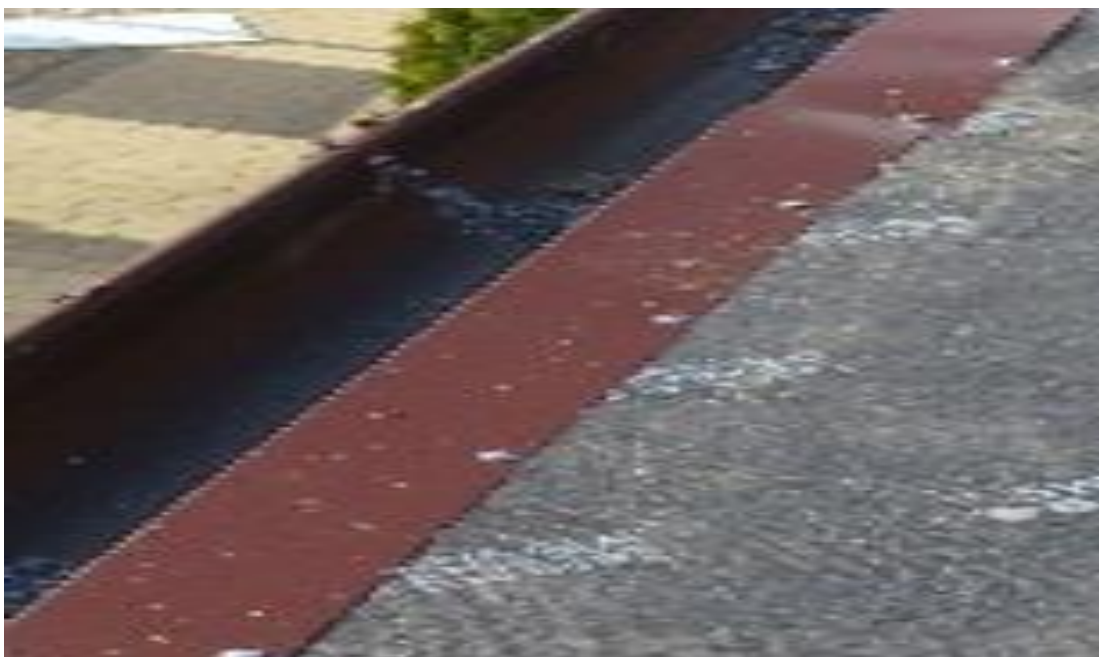
Widok zamontowanej obróbki pasa nadrynnowego
