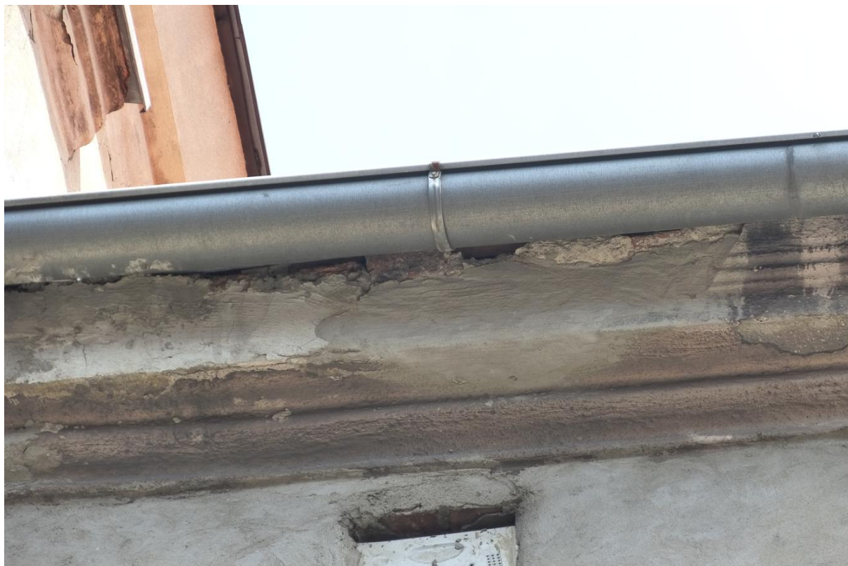
Fot. 4. Otwory w uszkodzonej podmurówce dachu, siedlisko jerzyków.
