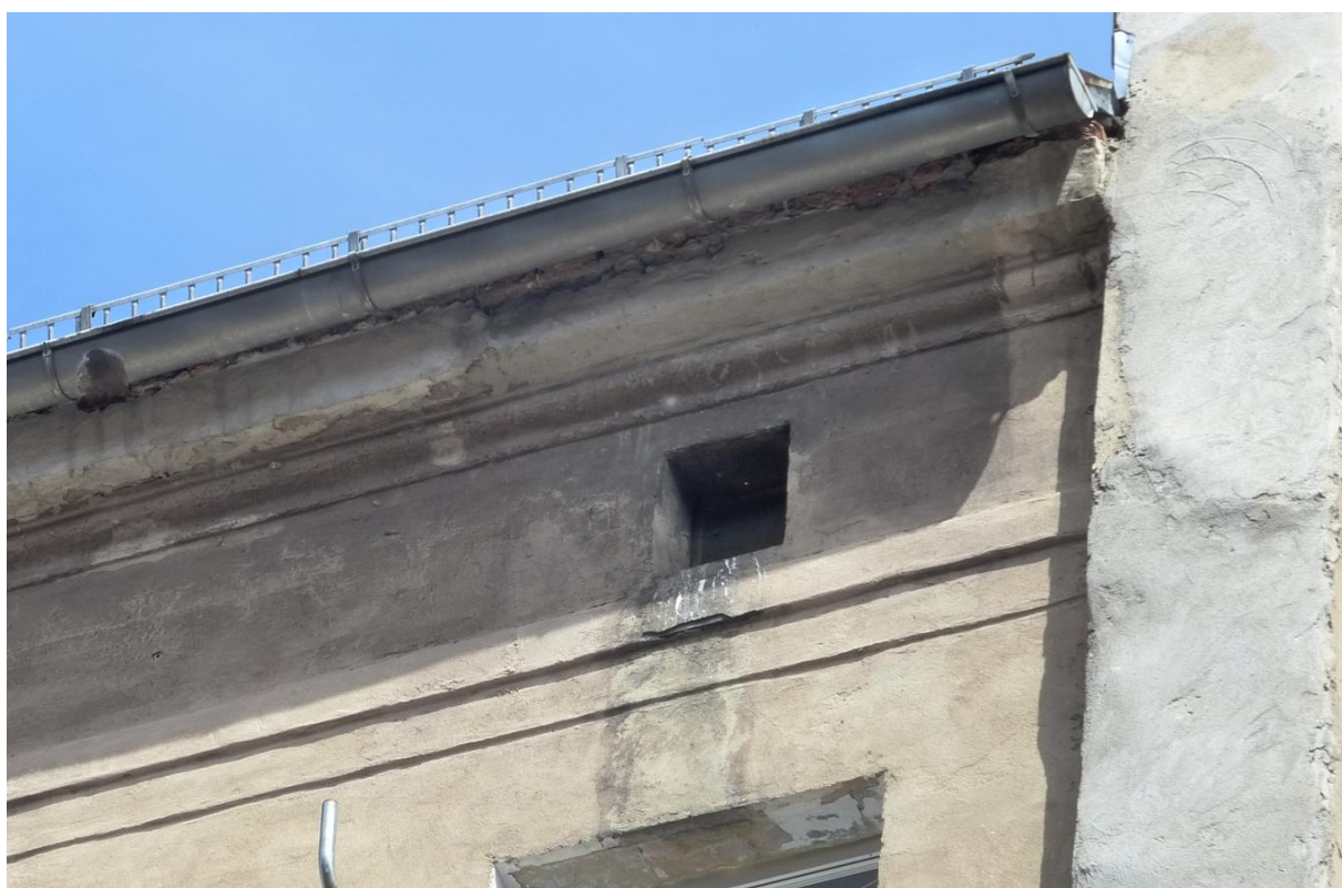
Fot. 5. Otwory w uszkodzonej podmurówce dachu, siedlisko nietoperzy.
