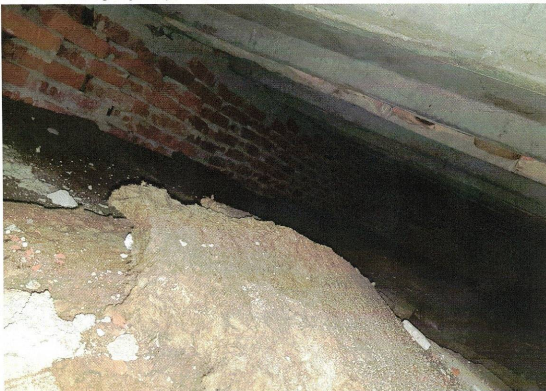
Fot. 7 Widok ścianek ażurowych posadowionych bezpośrednio na płytach WPS.
