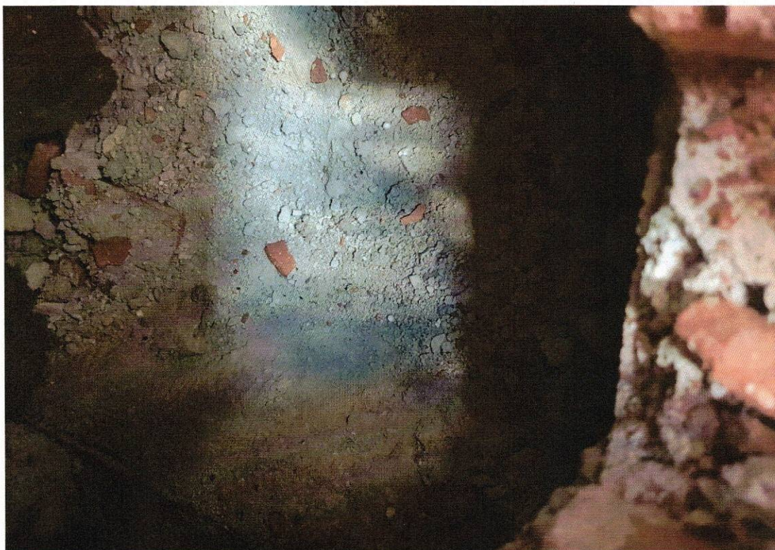
Fot. 4 Widok podsypki cementowej na stropie w części stropodachu.
