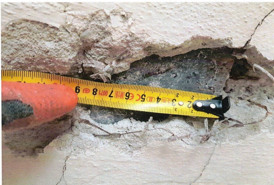
Fot. 2 Odkucie i ocena stopki belki stalowej.
