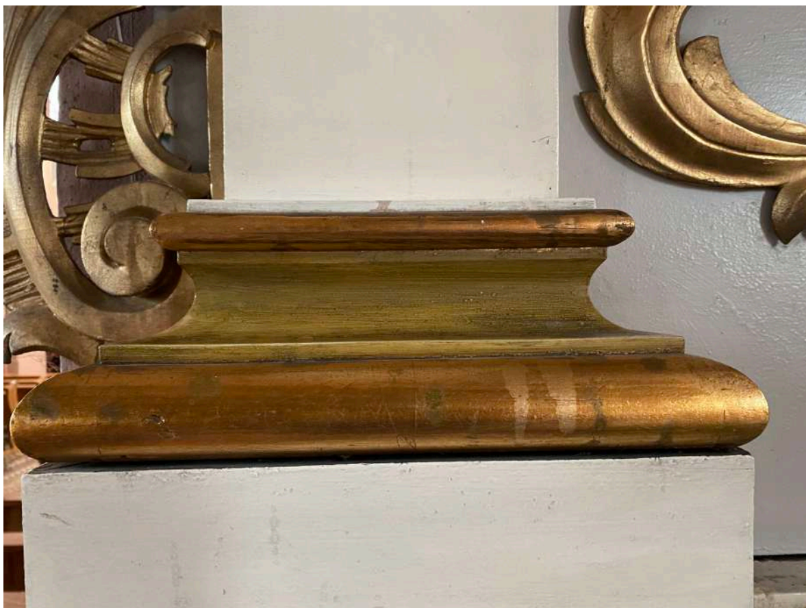
Fot. 3. Ołtarz św. Trójcy - wtórne lakiery na elementach złożonych ołtarza.
