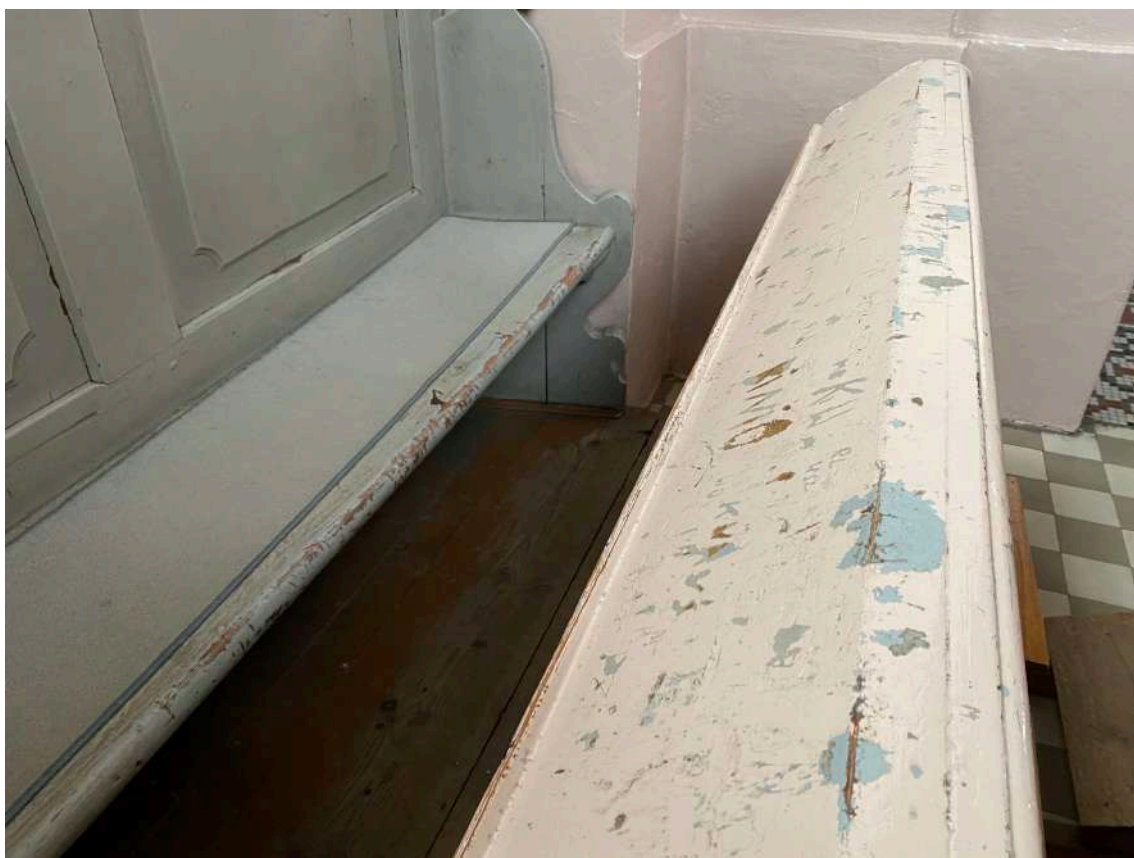
Fot. 21. Przetarcia i wykruszenia balustrady i siedzisk stali.
