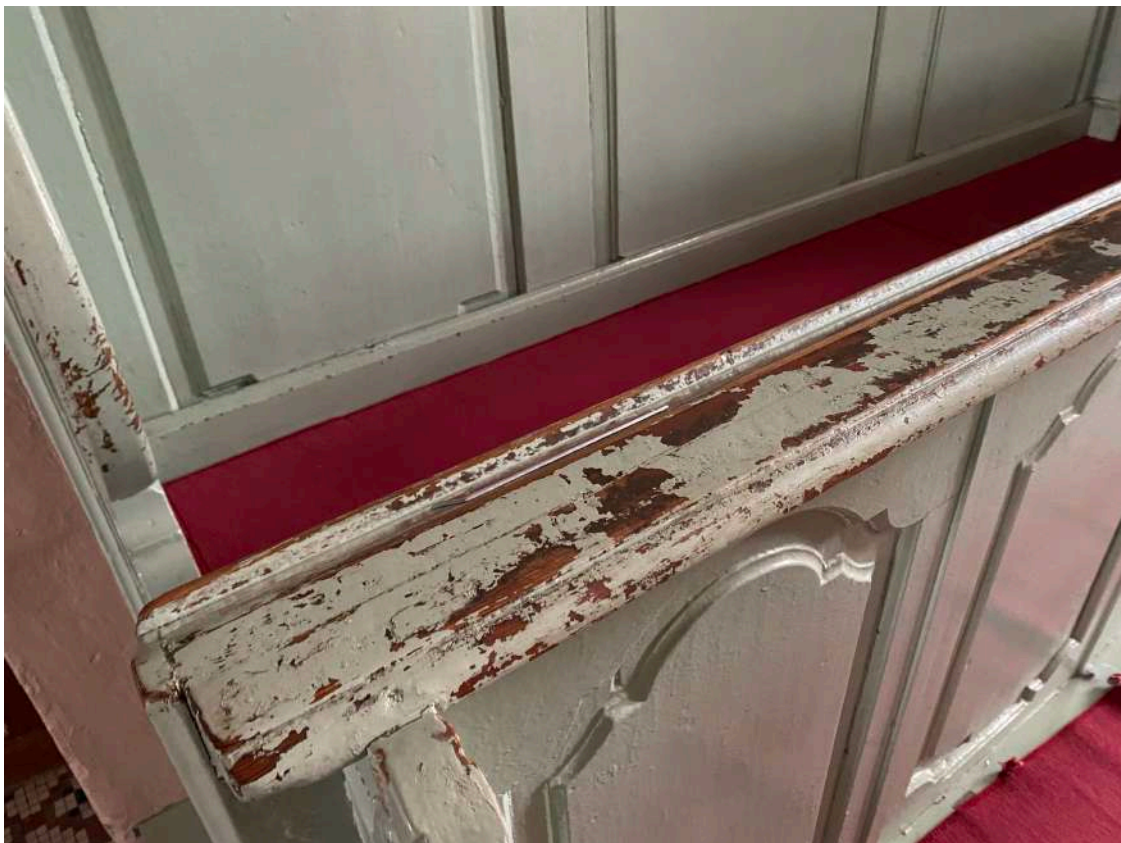
Fot. 24. Stalle pod chórem - przetarcia warstw malarskich na balustradzie.
