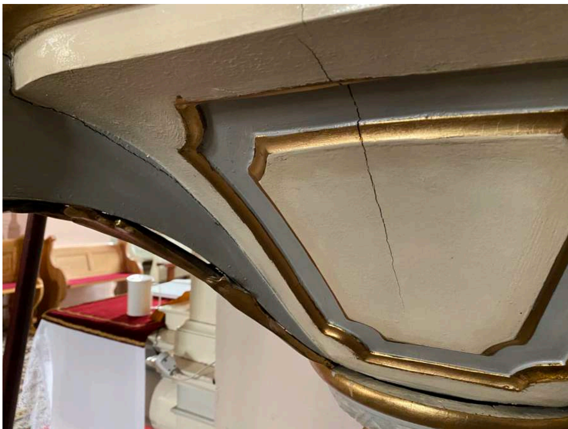
Fot. 15. Ambona - widoczne spękania konstrukcji ambony, przemalowania powierzchni grubą warstwą farby olejnej.
