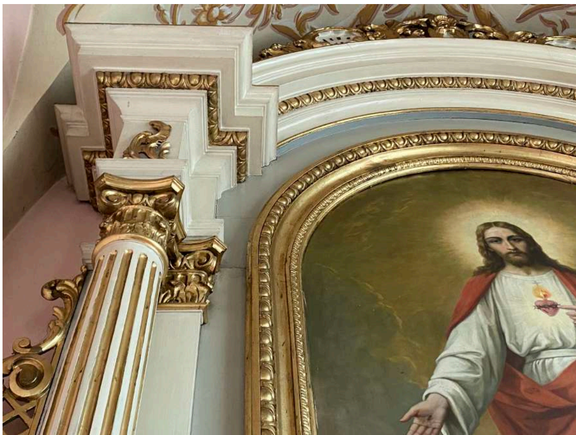
Fot. 5. Ołtarz Najświętszego Serca Jezusowego - widoczne przemalowania olejne ołtarza.
