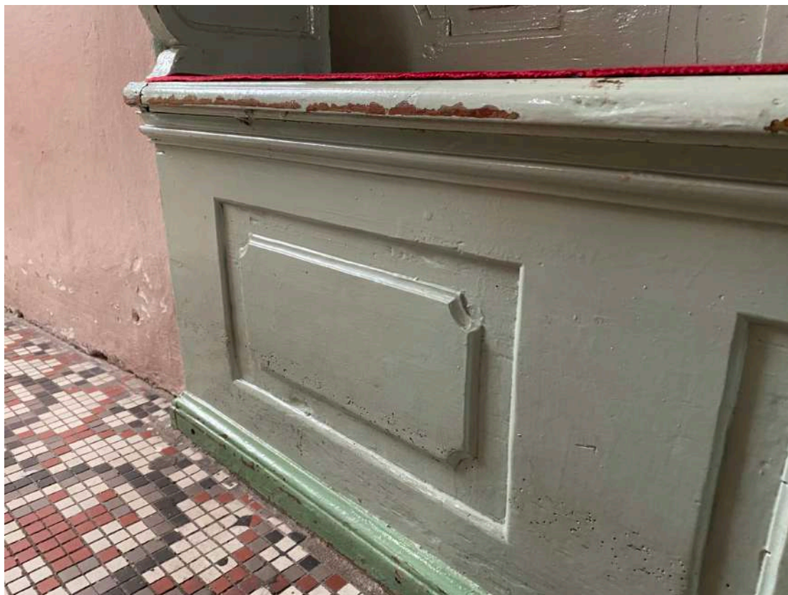
Fot. 23. Stalle pod chórem - ubytki warstw malarskich.
