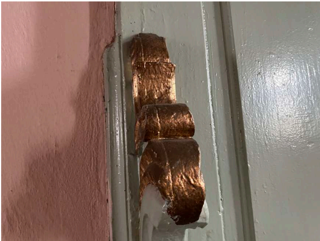
Fot. 25. Przemalowania złoconych detali farbą złotą.
