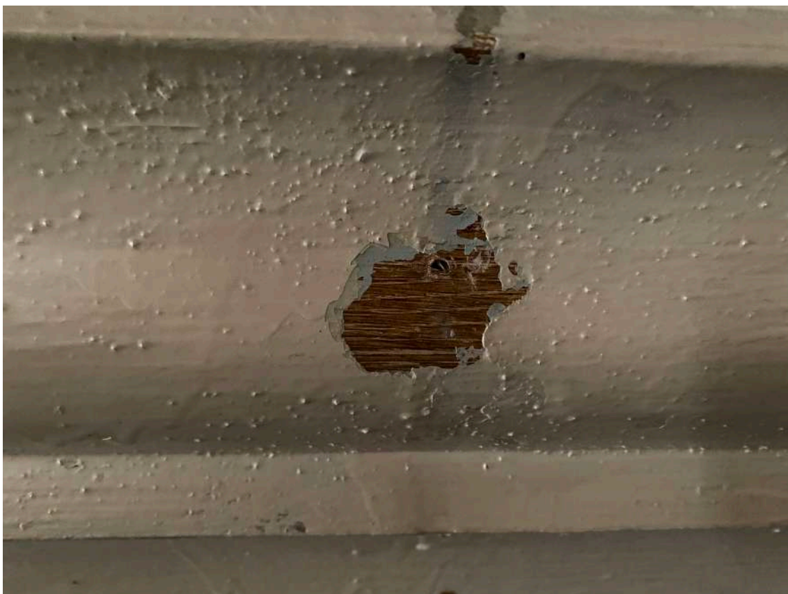
Fot. 28. Szafa organowa - widoczne pierwotne mazerunki pod warstwą przemalowań.
