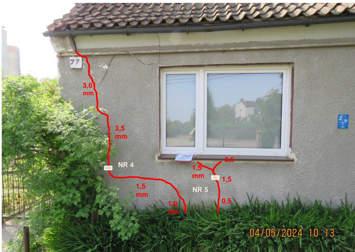
Pionowe i poziome pęknięcia na elewacji północnej (bud.nr 77). Szerokość rozwarcia od 0,5mm do 3,5mm. Pokazano miejsca założenia płytek szklanych.
