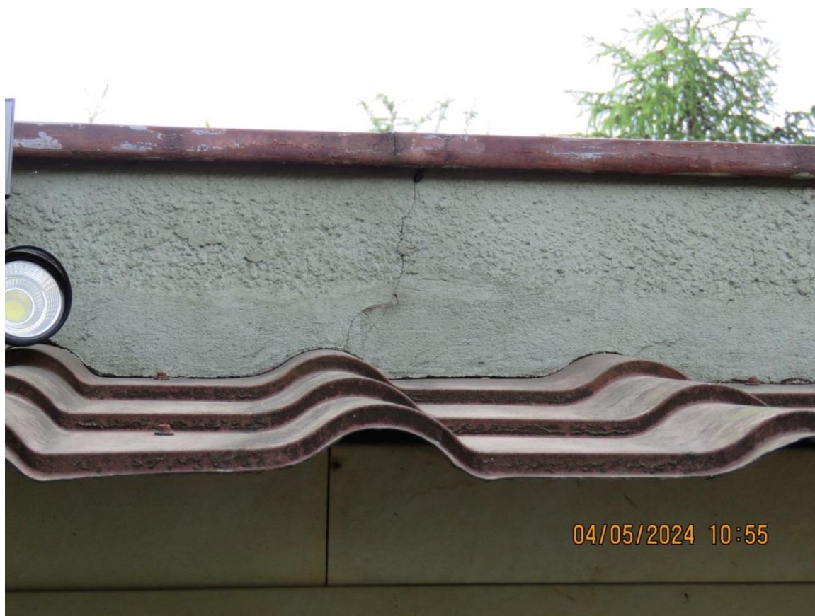
Pojawiło się pęknięcie ścianki attykowej powyżej nadproża drzwi garażu.
