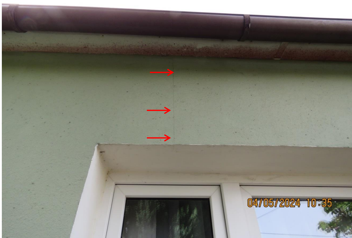
Pojawiło się pęknięcie ścianki attykowej powyżej nadproża drzwi garażu.
