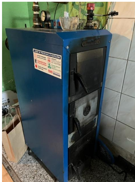
Rys. 5 Źródło ciepła – kocioł na paliwo stałe typu węgiel kamienny
