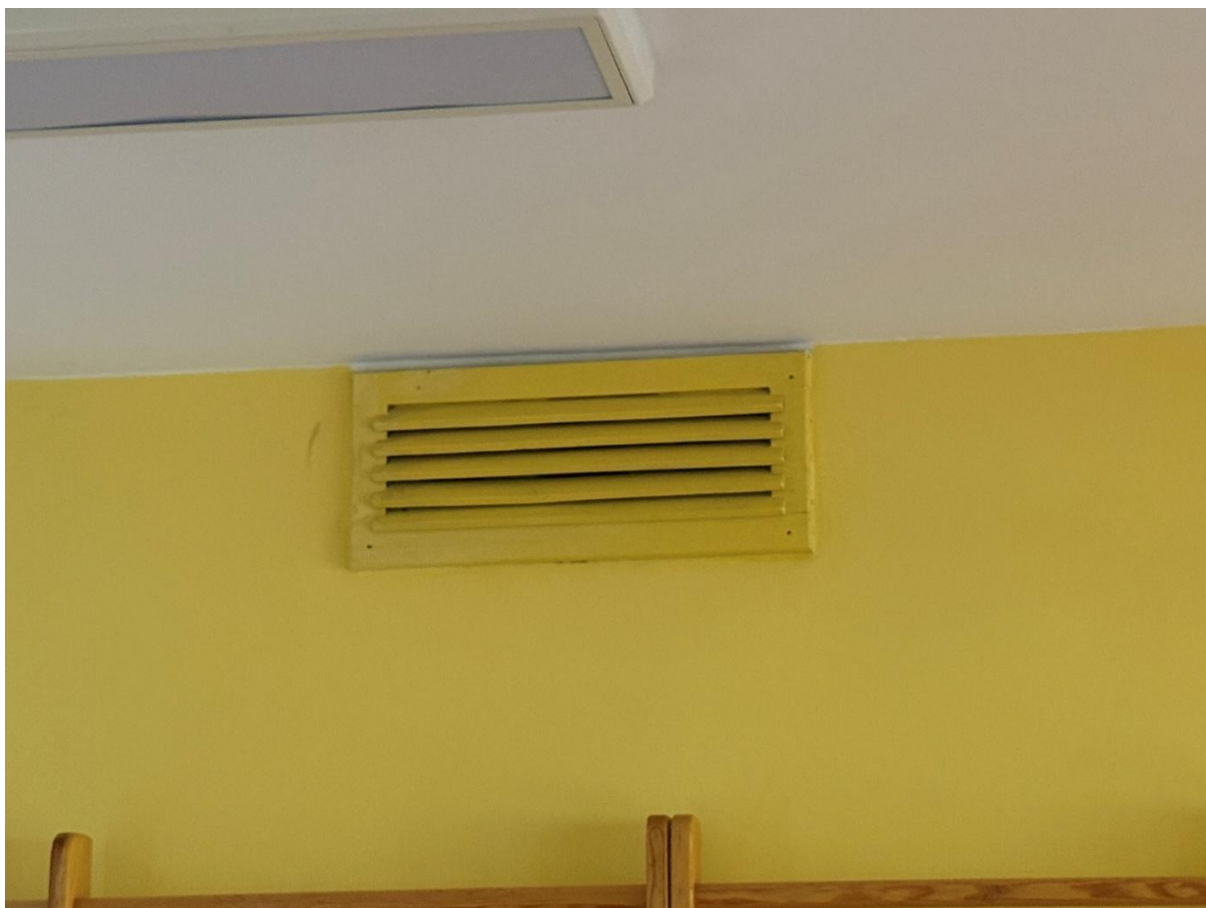
Rysunek 15. Kratka wentylacyjna do wymiany- wewnątrz sali
