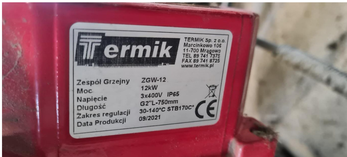
Rys. 2.2 Tabliczka znamionowa grzałki elektrycznej
