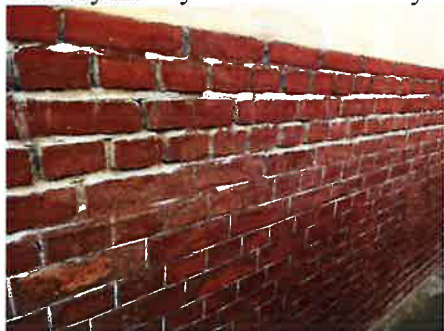
zdegradowany cokół budynku z cegły pełnej
