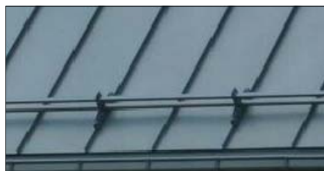
PROPONOWANE POKRYCIE DACHU Z BLACHY NA RĄBEK STOJĄCY (W NAWIĄZANIU DO PIERWOTNEGO POKRYCIA)
