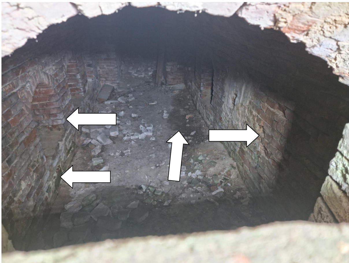
Fot. 5. Ściany krypty, widoczne plamy zielenic, wysolenia, ubytki zaprawy wapiennej i cegieł.
