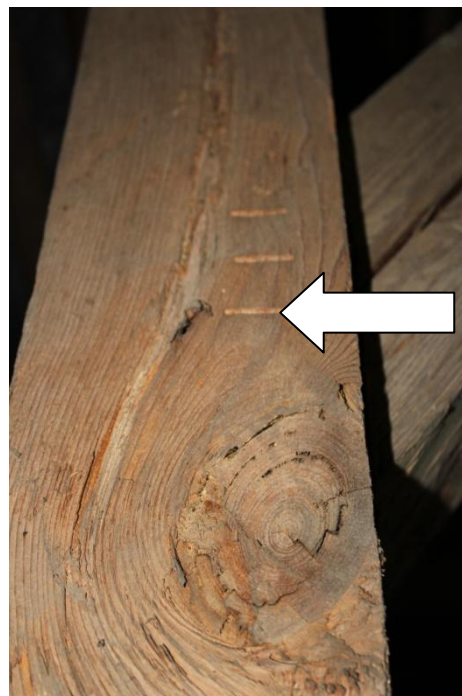
Fot. 7. Ciesielskie znaki montażowe na słupach wsporczych więźby dachowej.
