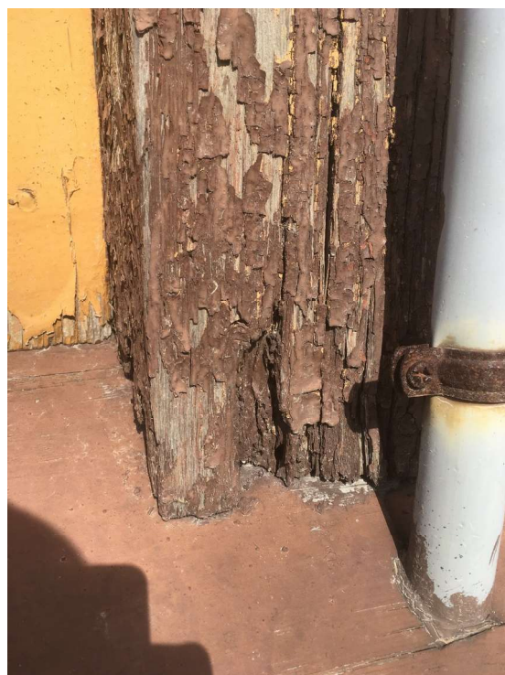
Fot. 20 i 21. Opaska i podstawa lisicy, widoczna degradacja powierzchni, spękania, korozja biologiczna.
