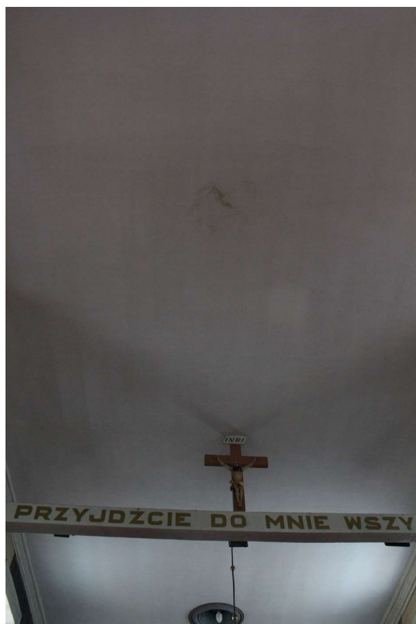
Fot. 68. Sufit nad belką tęczową, widoczny zaciek.
