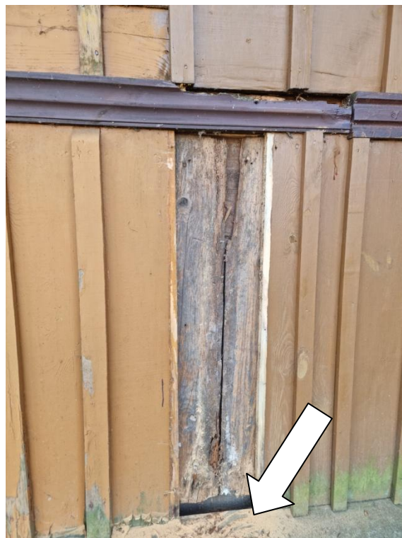
Fot. 7. Szalunek zewnętrzny po demontażu, widoczna osypująca się mączka po żerowiskach.
