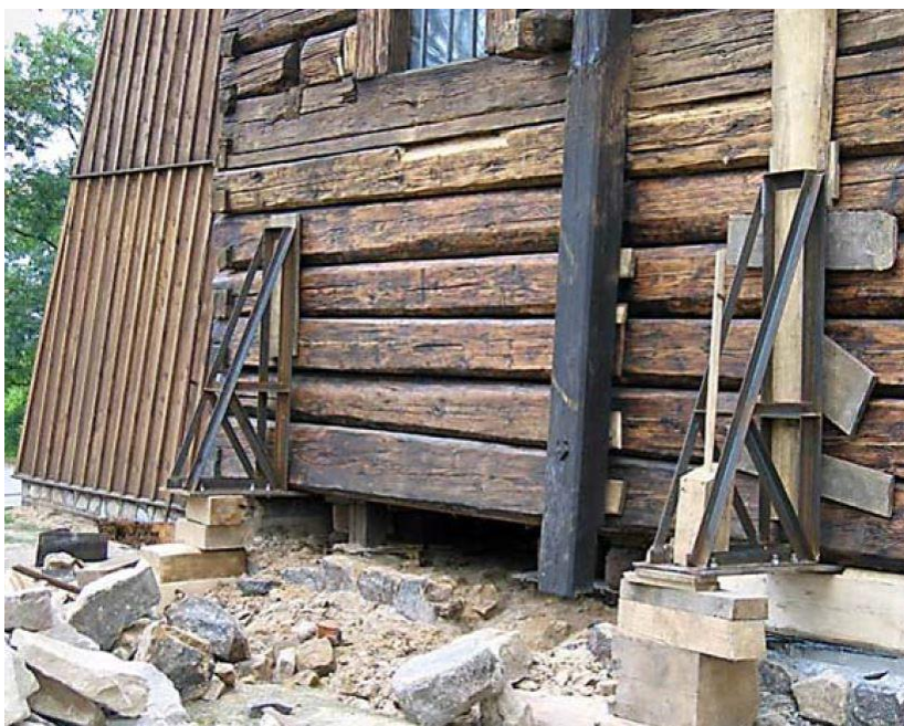
Fot. 8. Kościół w Żernicy, wsparcie ścian kościoła na czas remontu fundamentu i podwaliny.
