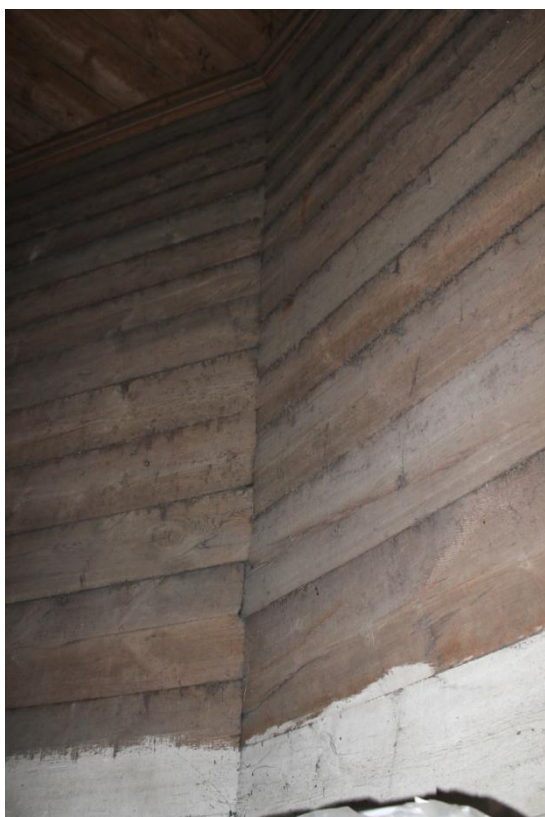
Fot.28. Kościół w Zofiborze, wnętrze, widok na bierwiona za ścianą zakrystii.
