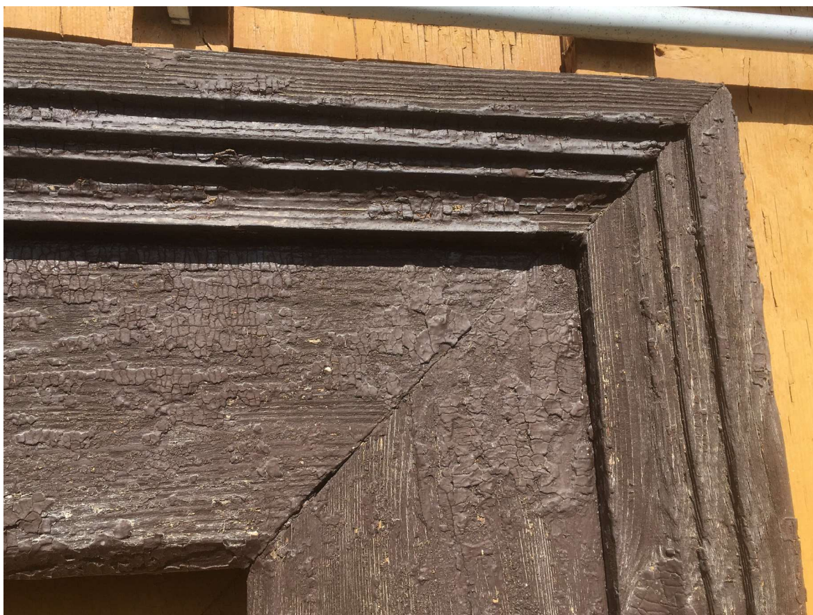
Fot. 26. Opaska okienna, widoczna degradacja powierzchni drewna pokrytej wtórnymi warstwami farby.
