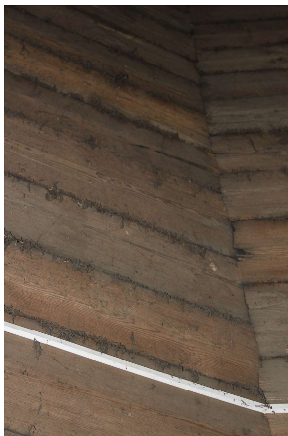
Fot. 75 i 76. Pomieszczenie za ołtarzem- skarbczyk. Bierwiona malowane tylko w dolnej części, uszczelnienie za pomocą mszenia.
