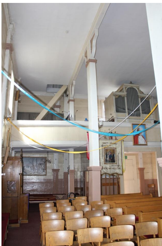
Fot.21. Kościół w Zofiborze, wnętrze, widok na słupy wewnętrzne oraz podciąg podłużny. W tle widoczne organy oraz schody na poddasze.
