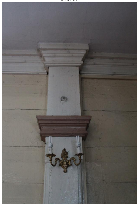
Fot.24. Kościół w Zofiborze, wnętrze, widok na lisice wewnętrzne i bierwiona. Widoczny górny gzyms pod sufitem, a na liscach gzyms pośredni i wieńczący. Całość malowana farbą olejną.
