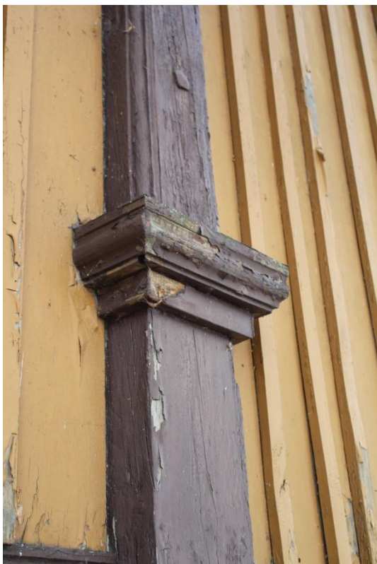
Fot.8. Kościół w Zofiborze, lisice zewnętrzne z detalem drewnianym w formie gzymsu. Degradacja elementów drewnianych oraz łuszcząca się, wtórna powłoka malarska.
