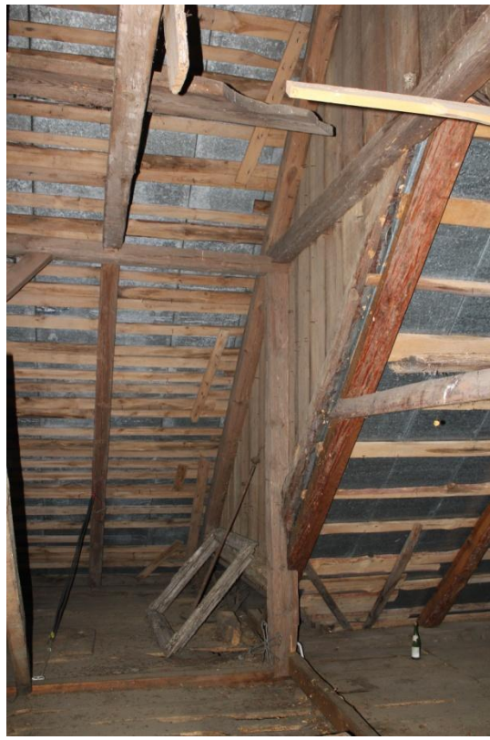
Fot.37. Kościół w Zofiborze, widok ogólny na więźbę dachową. Widoczne ubytki w deskowaniu.
