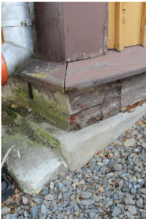
Fot.12. Kościół w Zofiborze, cokół z obrzutką cementową, na nim drewniana podwalina. Widoczne zazielenienia na cokole oraz podwalinie. Drewno zawilgocone.
