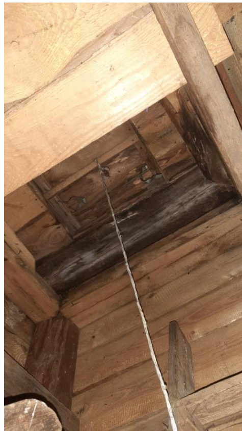
Fot.45. Kościół w Zofiborze, widok na konstrukcję latarni. Widoczne zacieki i białe plamy na elementach drewnianych.
