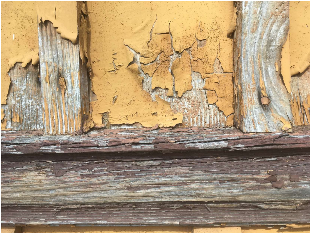
Fot. 22. Szalunek powyżej listwy obiegającej, widoczna degradacja drewna, spękania.
