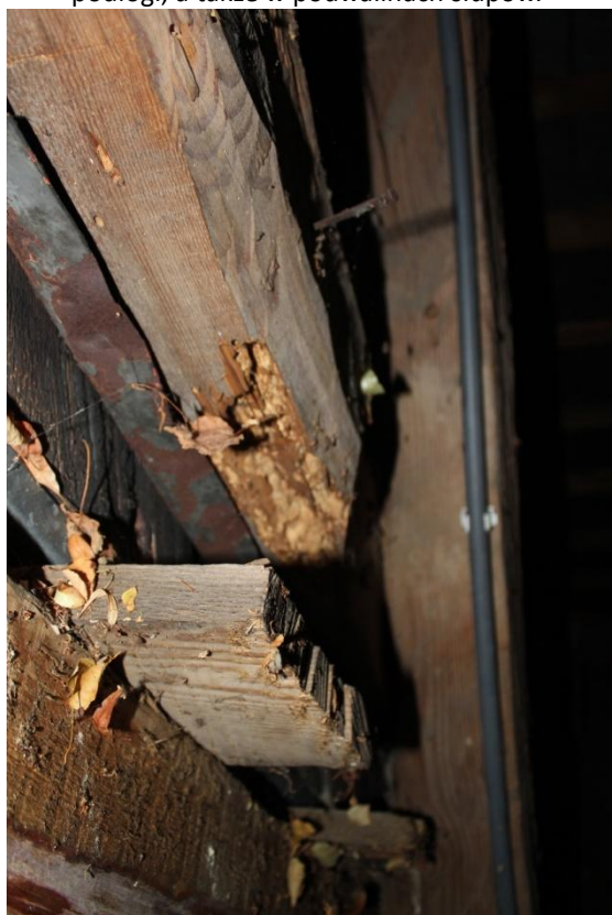
Fot.41. Kościół w Zofiborze, ubytki w drewnie elementów drewnianych.
