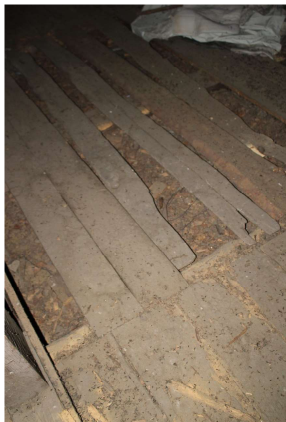
Fot. 49. Nawierzchnia stropodachu, w znacznym stopniu utraciła swoją funkcję techniczną.
