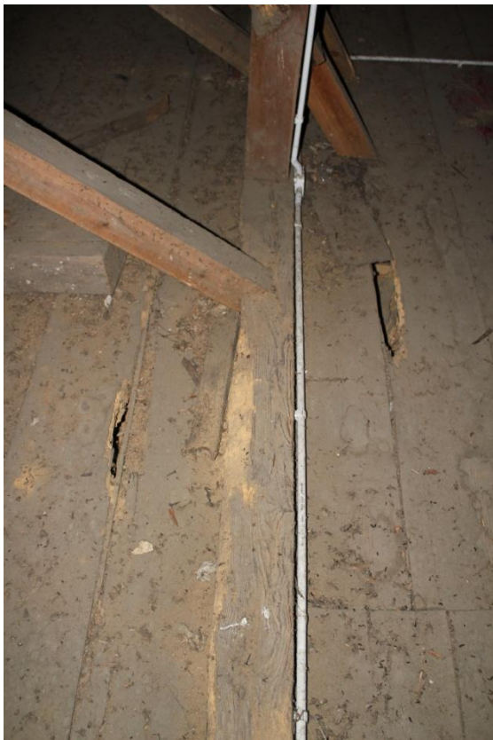
Fot.39. Kościół w Zofiborze, widok na deskowanie podłogi poddasza. Widoczne ubytki w deskowaniu podłogi, a także w podwalinach słupów.
