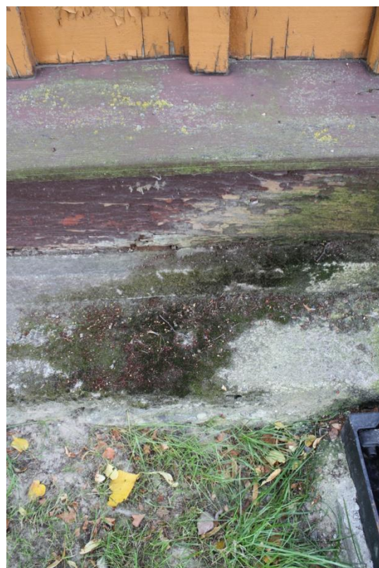
Fot.11. Kościół w Zofiborze, cokół z obrzutką cementową, na nim drewniana podwalina. Widoczne zazielenienia na cokole oraz podwalinie. Drewno zawilgocone.
