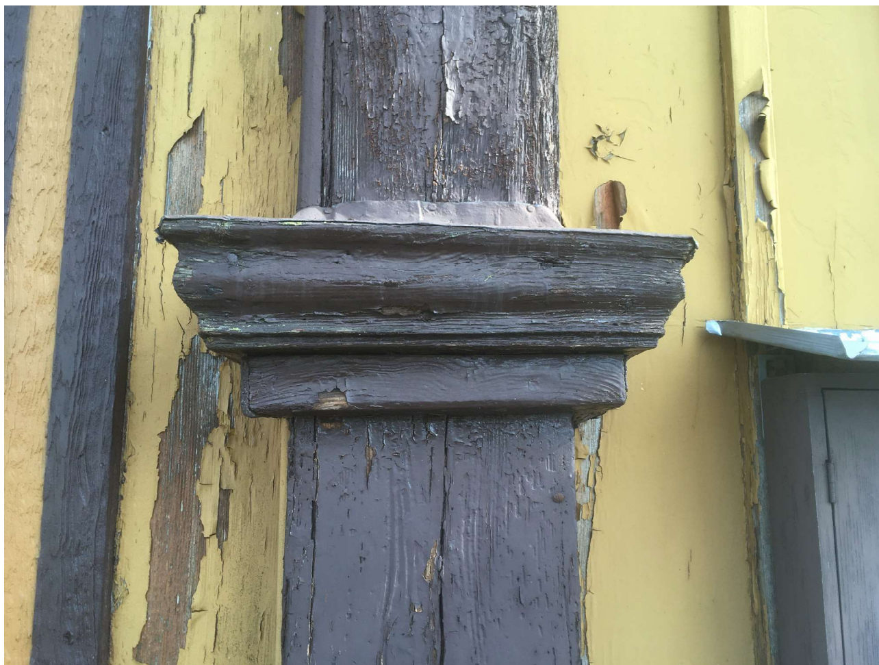
Fot. 19. Opaska lisicy, widoczny stan zachowania oraz obróbka blacharska opaski.
