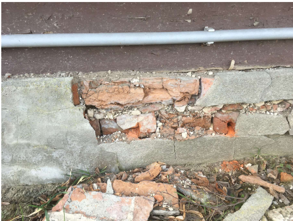
Fot. 35. Degradacja muru fundamentu na skutek pokrycia szczelną warstwą zaprawy cementowej.
