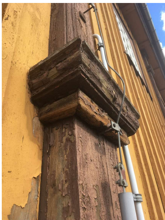
Fot. 20 i 21. Opaska i podstawa lisicy, widoczna degradacja powierzchni, spękania, korozja biologiczna.
