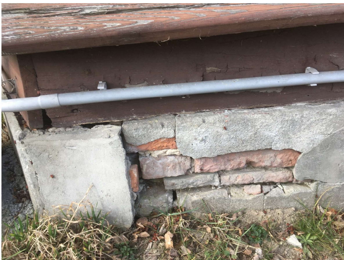
Fot. 36. Degradacja muru fundamentu na skutek pokrycia szczelną warstwą zaprawy cementowej.
