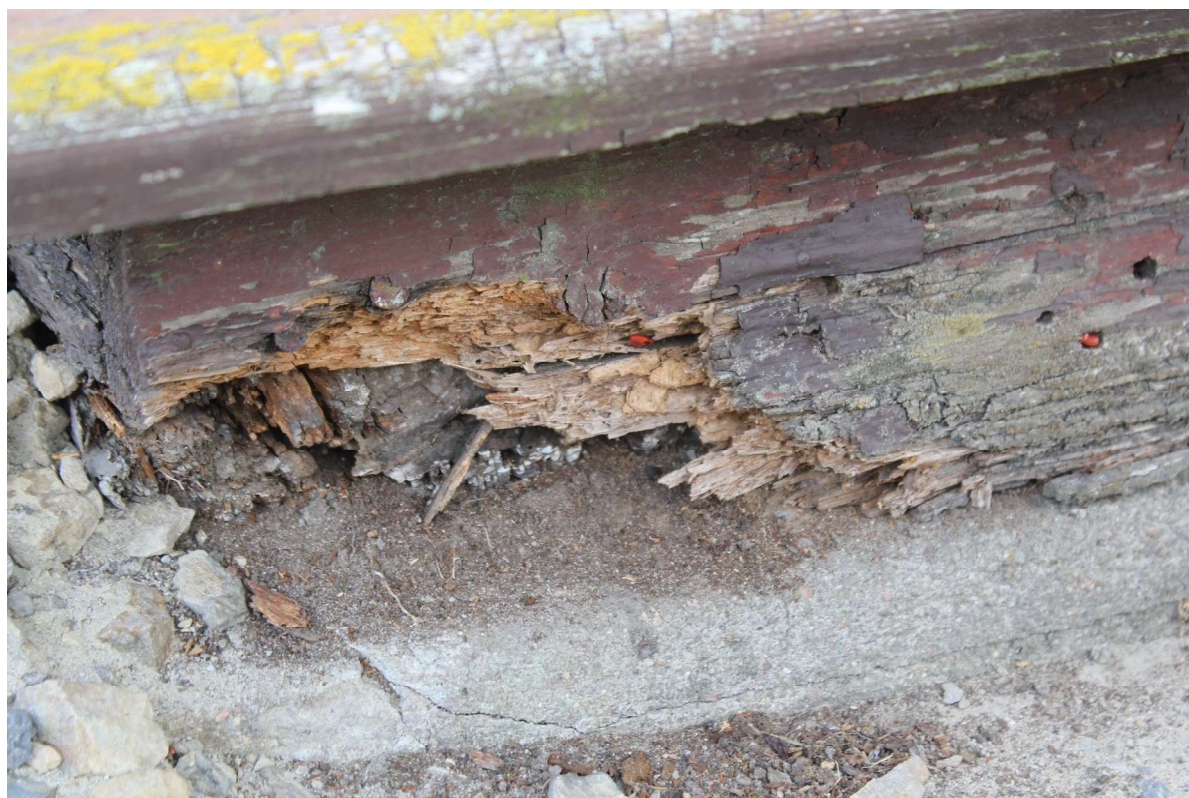
Fot. 28. Podwalina, dezintegracja i ubytki wynikające z żerowania drewnojadów.
