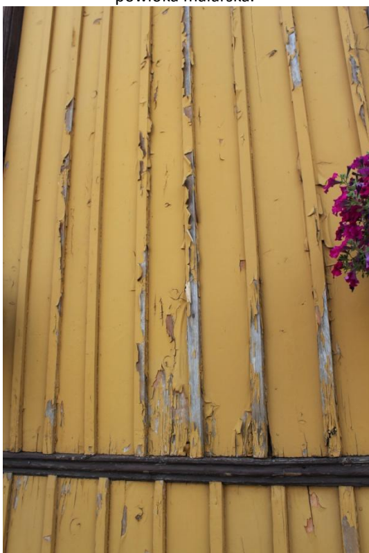
Fot.10. Kościół w Zofiborze, szalunek z listwowaniem. Widoczna gołym okiem korozja biologiczna drewna, łuszcząca się farba.
