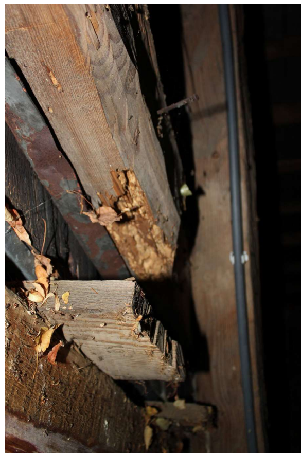
Fot. 58 i 59. Stan zachowania elementów więźby- degradacja związana z żerowaniem owadów.
