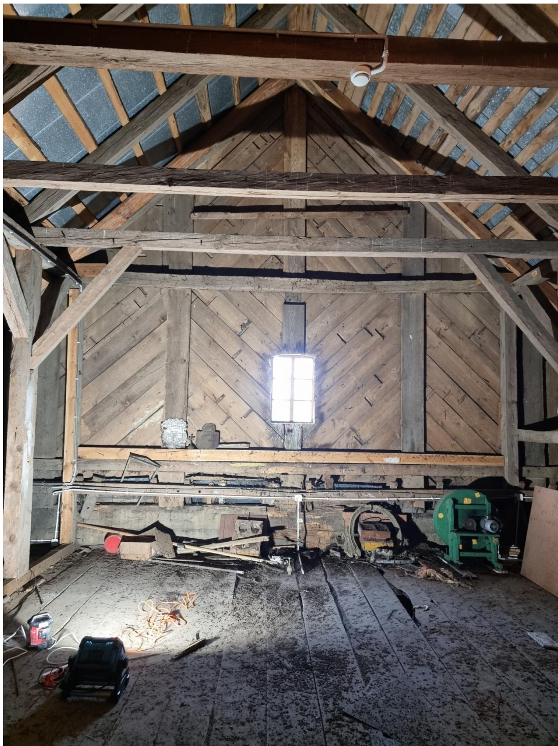
Fot.43. Kościół w Zofiborze, ściana szczytowa elewacji frontowej z oknem. Deskowanie ułożone w jodełkę, widoczne zniszczenia i ubytki drewna.
