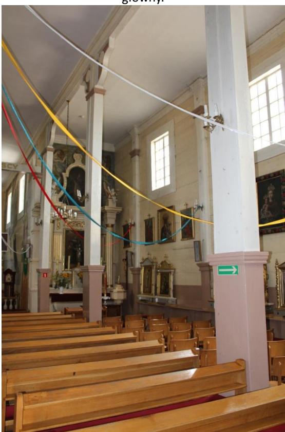
Fot.20. Kościół w Zofiborze, wnętrze, widok na słupy wewnętrzne oraz podciąg podłużny.
