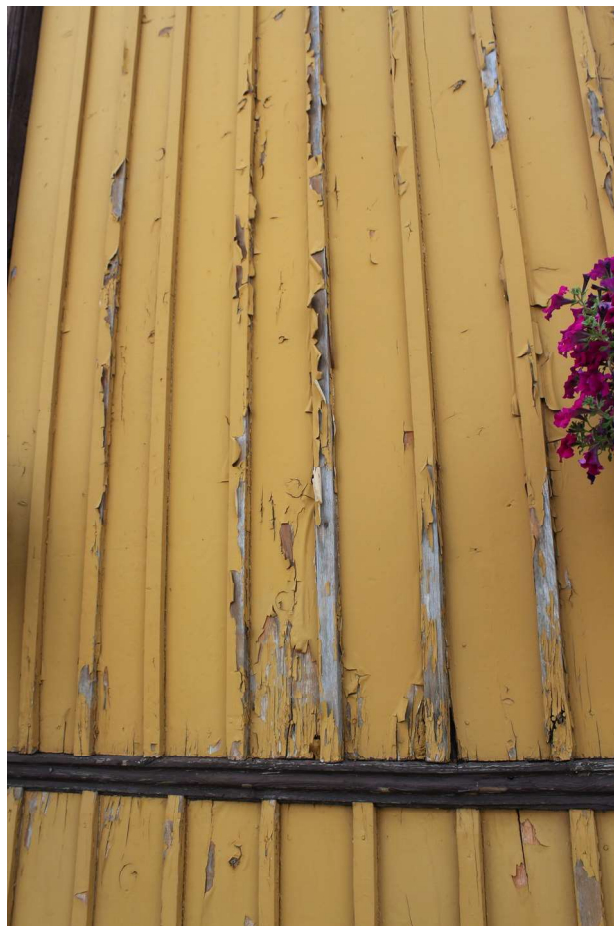
Fot. 16. Szalunek, widoczny stan zachowania.
