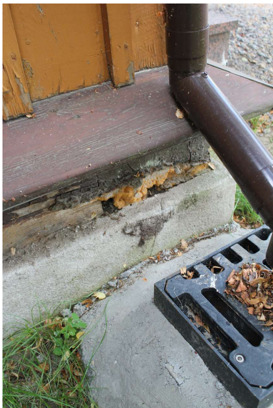
Fot. 33. Narożnik, widoczne naprawy podwaliny za pomocą pianki PUR.
