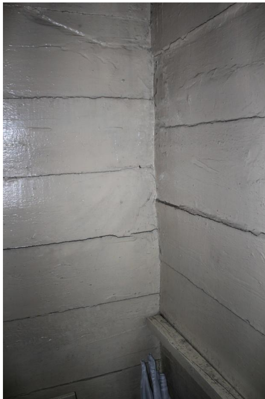
Fot.31. Kościół w Zofiborze, wewnątrz, widok na bierwiona, widoczne szerokie rysy pomiędzy elementami bierwion, świadczące o pracy całej ściany.
