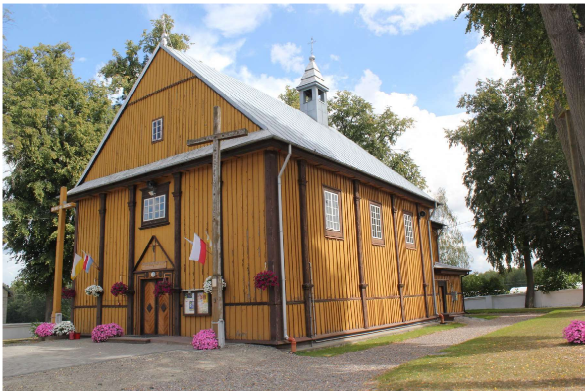
Fot. 1. Elewacje zachodnia i południowa. Widoczne podziały lisicami, szalunek oblistwowany, pokrycie dachu z blachy ocynkowanej, wzniesienie terenu przy elewacji zachodniej.
