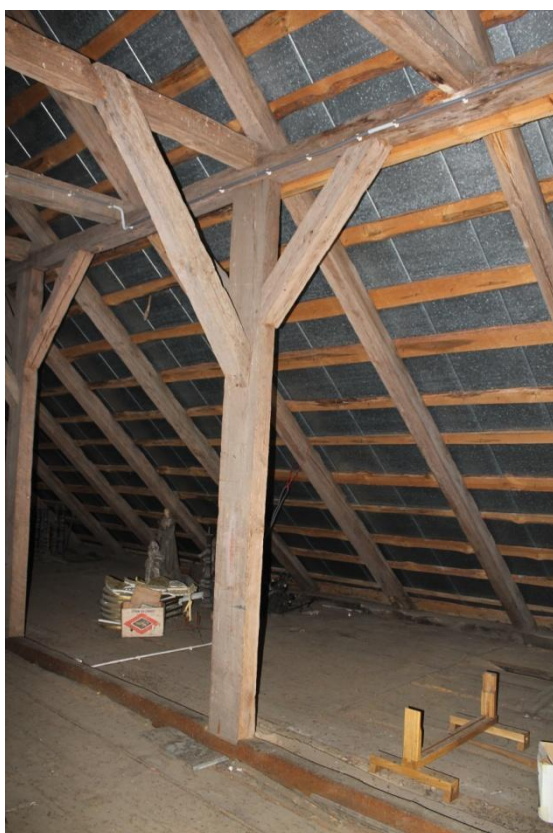
Fot.34. Kościół w Zofiborze, widok ogólny na więźbę dachową. Widok na słupy, miecze, płatwie oraz jętki.
