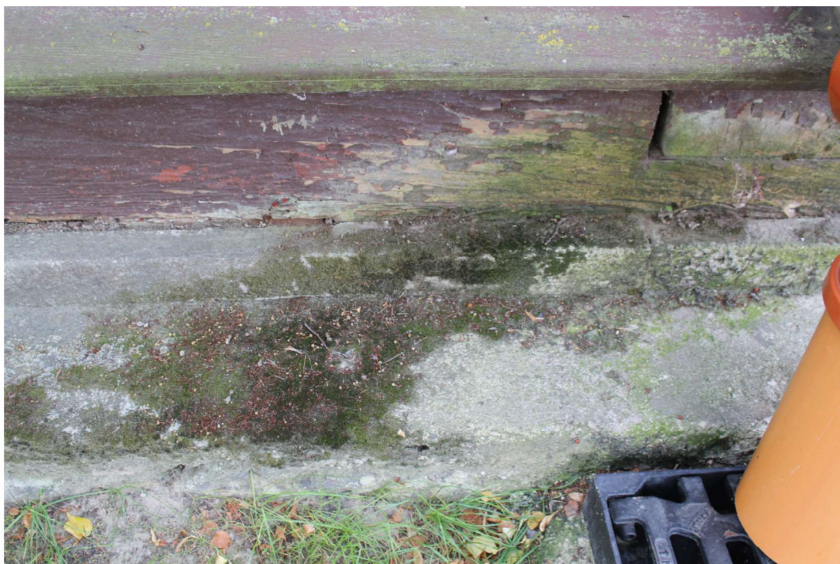
Fot. 32. Fundament i podwalina, widoczne skutki kumulacji wilgoci w murze.
