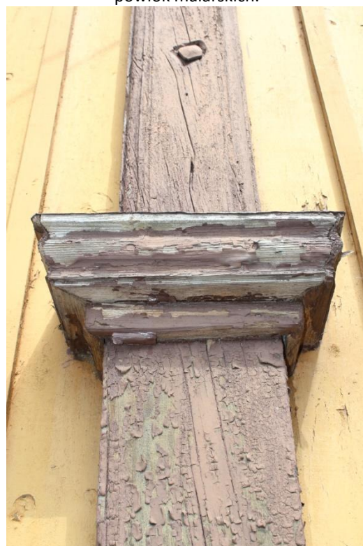
Fot.7. Kościół w Zofiborze, lisice zewnętrzne z detalem drewnianym w formie gzymsu. Degradacja elementów drewnianych oraz łuszcząca się, wtórna powłoka malarska.
