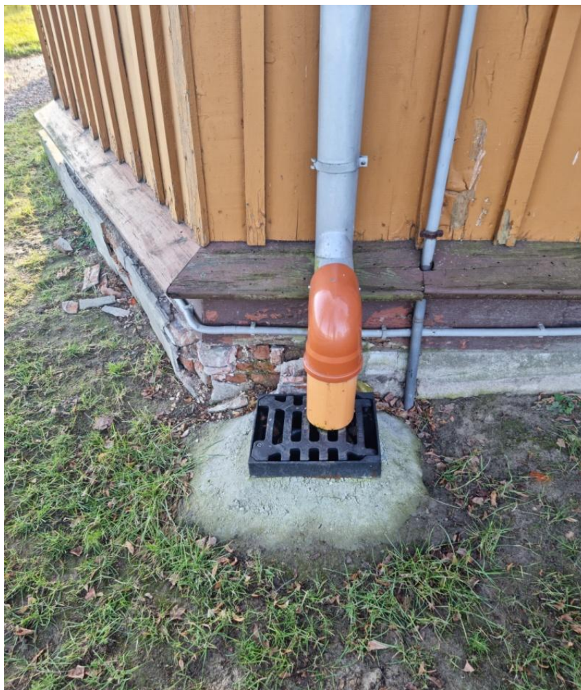
Fot. 4. Stopień zniszczenia obrzutki cementowej cokołu.
