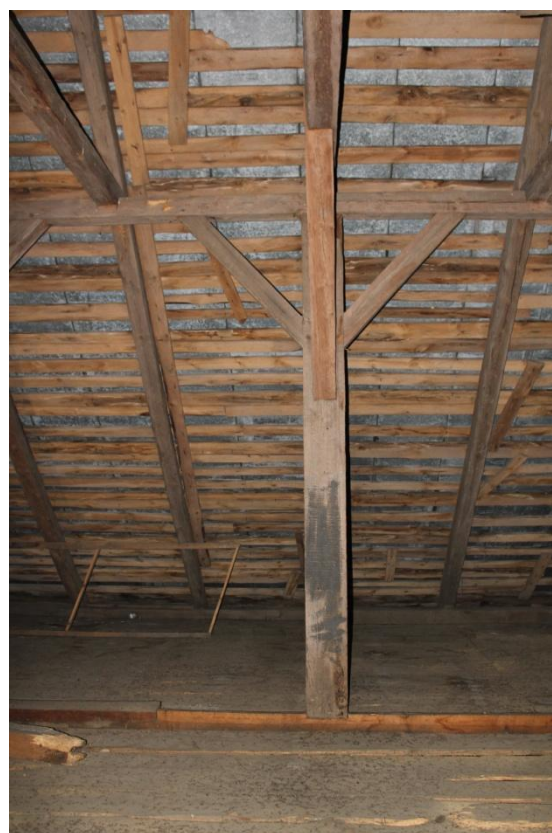
Fot.35. Kościół w Zofiborze, widok ogólny na więźbę dachową. Widok na słupy, miecze, płatwie oraz jętki.
