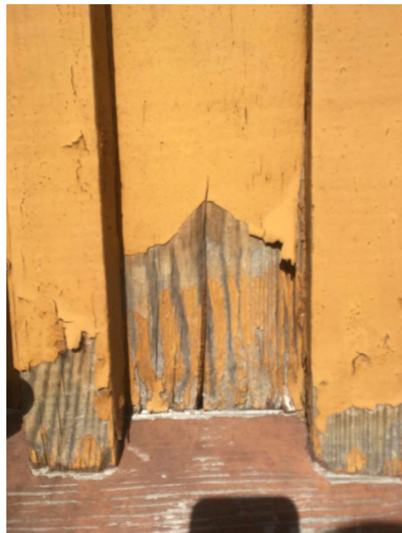
Fot. 22. Szalunek powyżej listwy obiegającej, widoczna degradacja drewna, spękania.
