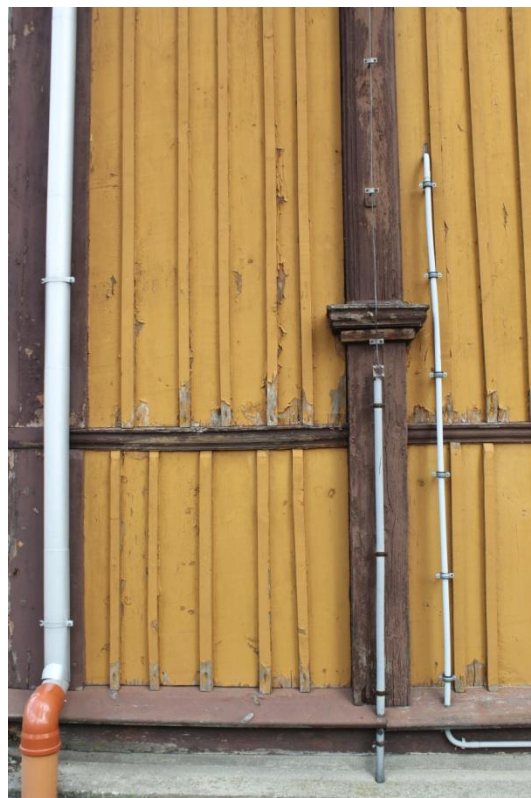
Fot.5. Kościół w Zofiborze, fragment szalunku elewacji, widoczny dolny okapnik, deskowanie, lisice. Widoczna degradacja elementów drewnianych oraz powłok malarskich.
