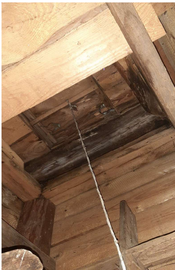
Fot. 52. Zawilgocenie podstawy sygnaturki.
