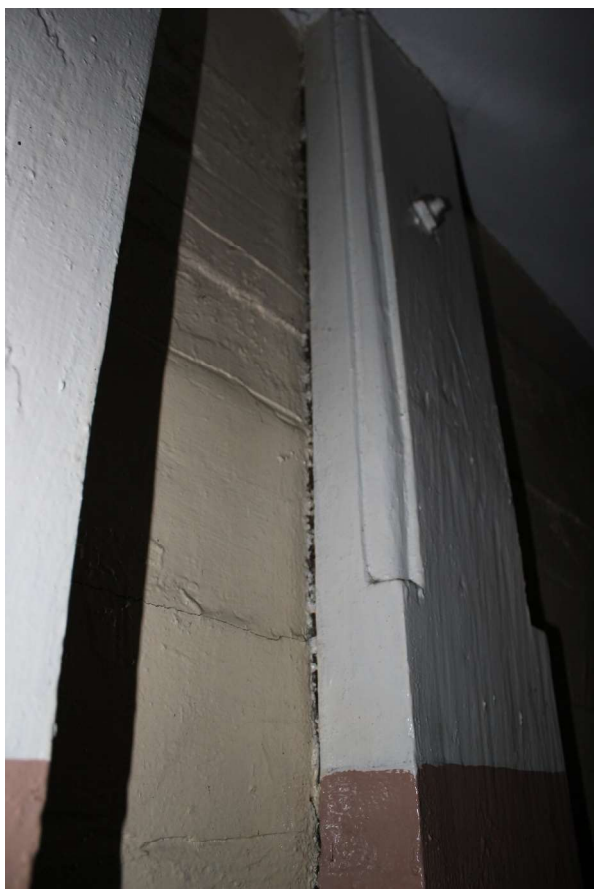
Fot. 69. Lisica, dolna część, widoczna śruba Ściągająca i wykończenie krawędzi.
