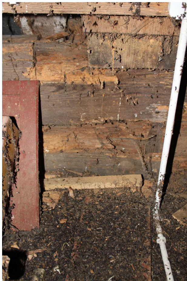
Fot. 43 i 44. Ściana szczytowa ( zachodnia), widoczny katastrofalny stan zachowania, daleko posunięta destrukcja drewna na skutek żerowania drewnojadów oraz penetracji wody opadowej dostającej się przez nieszczelne okno.
