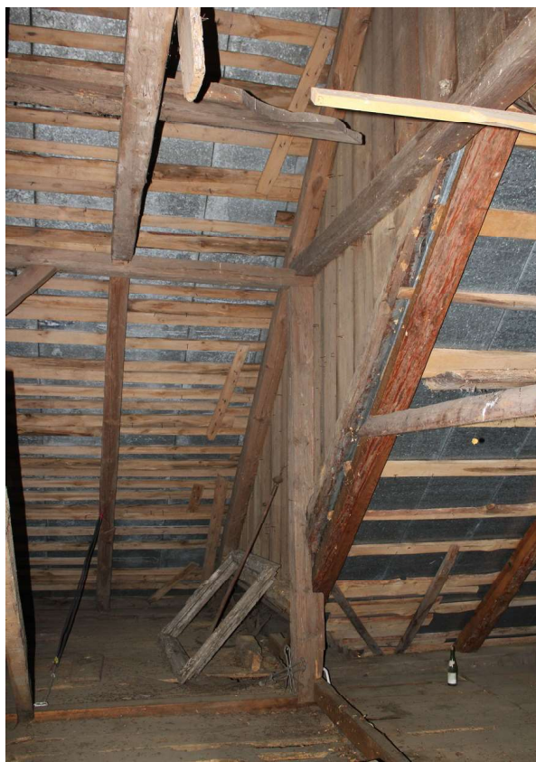
Fot. 54. Styk dachu nawy z dachem prezbiterium.
