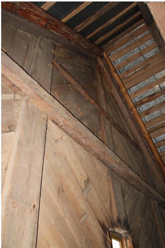
Fot.44. Kościół w Zofiborze, ściana szczytowa elewacji frontowej z oknem. Deskowanie ułożone w jodełkę.
