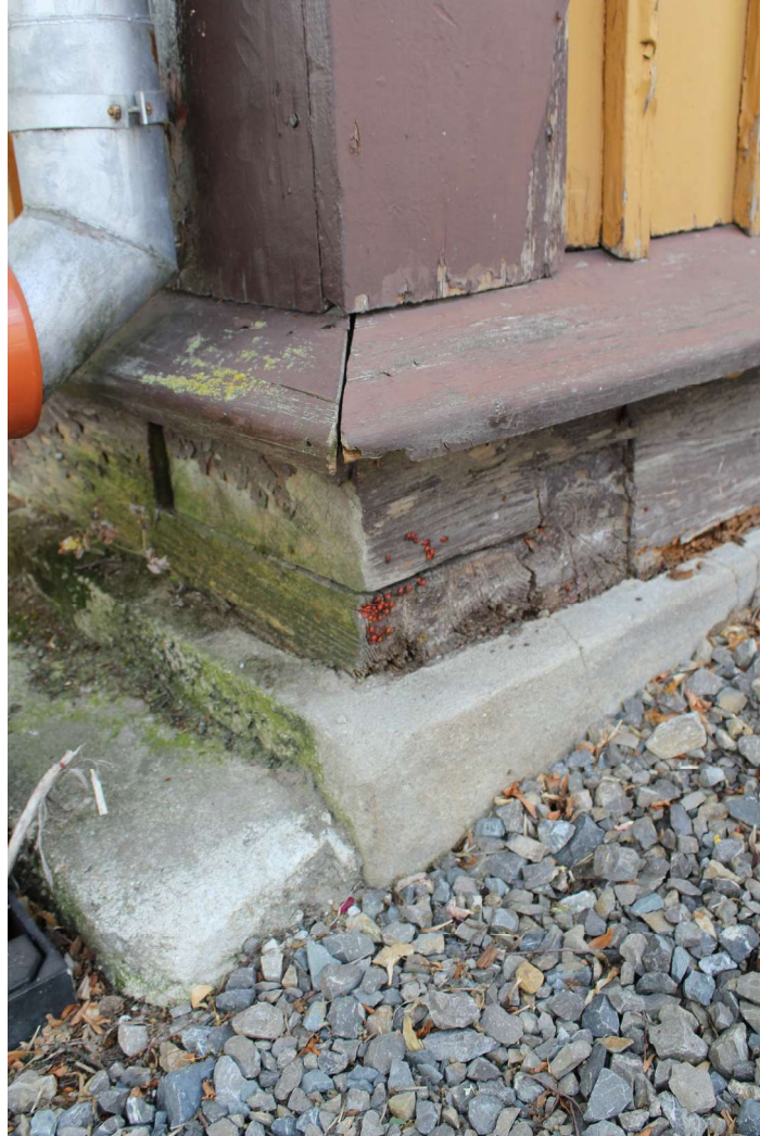
Fot. 31. Narożnik, widoczna konstrukcja złączy podwaliny ( zakładka prosta) oraz stan zachowania- korozja biologiczna, spękania oraz szczelna warstwa cementowa na styku podwaliny i fundamentu.
