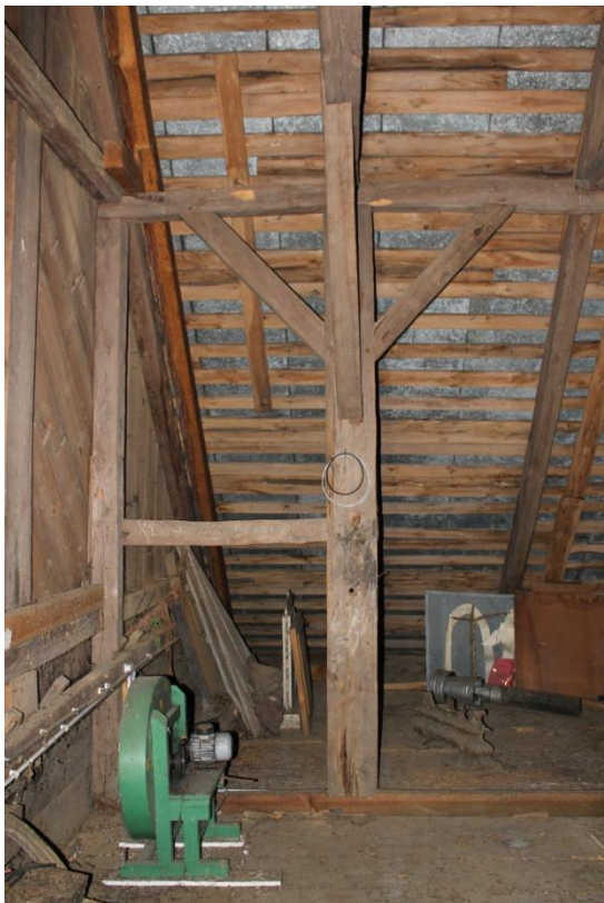
Fot.36. Kościół w Zofiborze, widok ogólny na więźbę dachową. Widoczne ubytki w deskowaniu.
