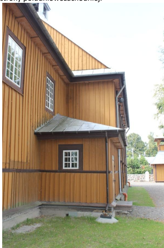
Fot.3. Kościół w Zofiborze, widok od strony północnowschodniej. Widoczne uzupełnienia szalunku.
