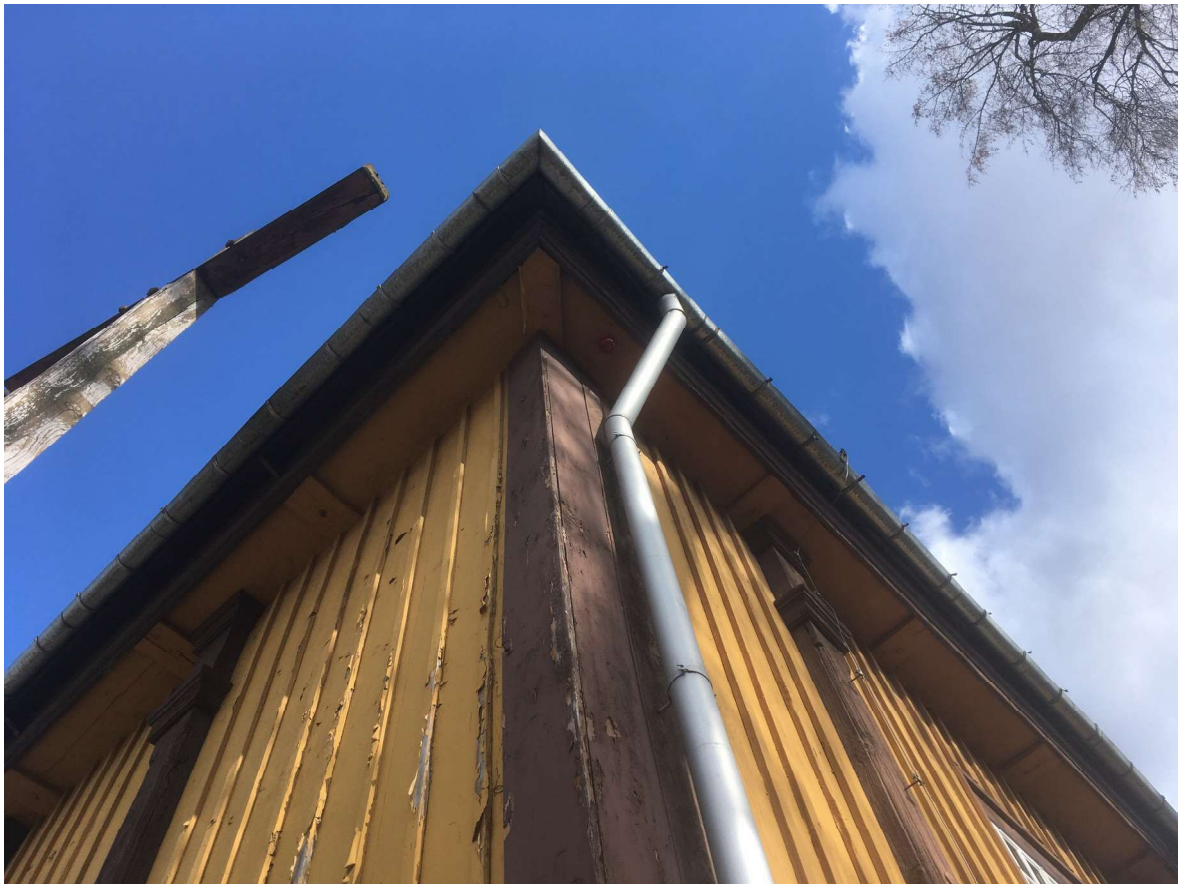
Fot. 13. Narożnik, widoczne deskowanie narożnika i podbitka.
