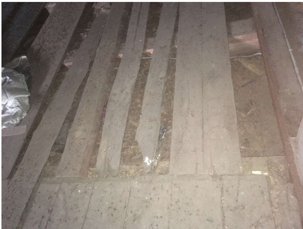
Fot. 49. Nawierzchnia stropodachu, w znacznym stopniu utraciła swoją funkcję techniczną.
