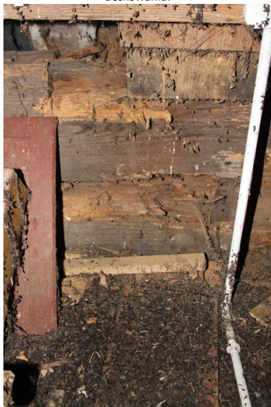
Fot.42. Kościół w Zofiborze, ubytki w drewnie elementów drewnianych.
