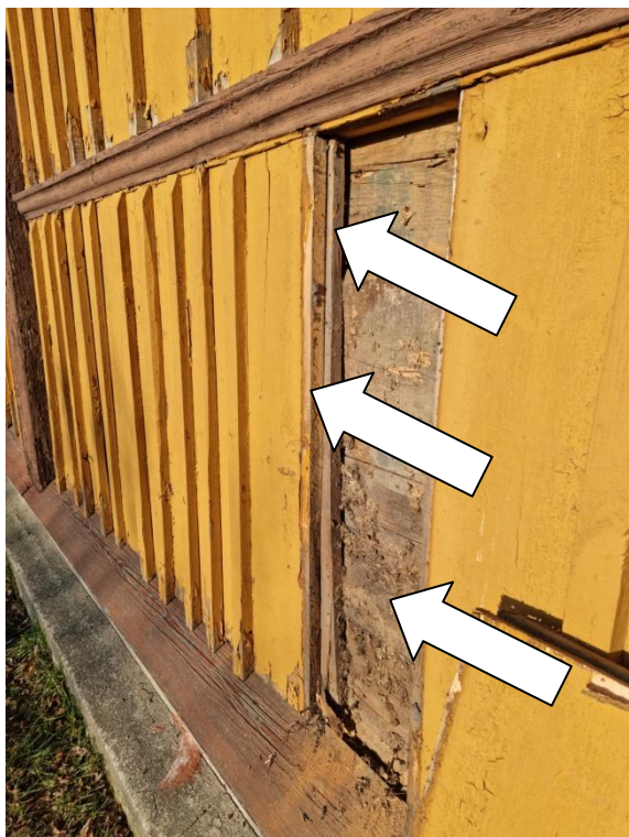
Fot. 6. Szalunek zewnętrzny – strzałka górna – deskowanie pierwotne, poniżej szalunek obecny, strzałka u dołu pokazuje bierwiona ścian.
