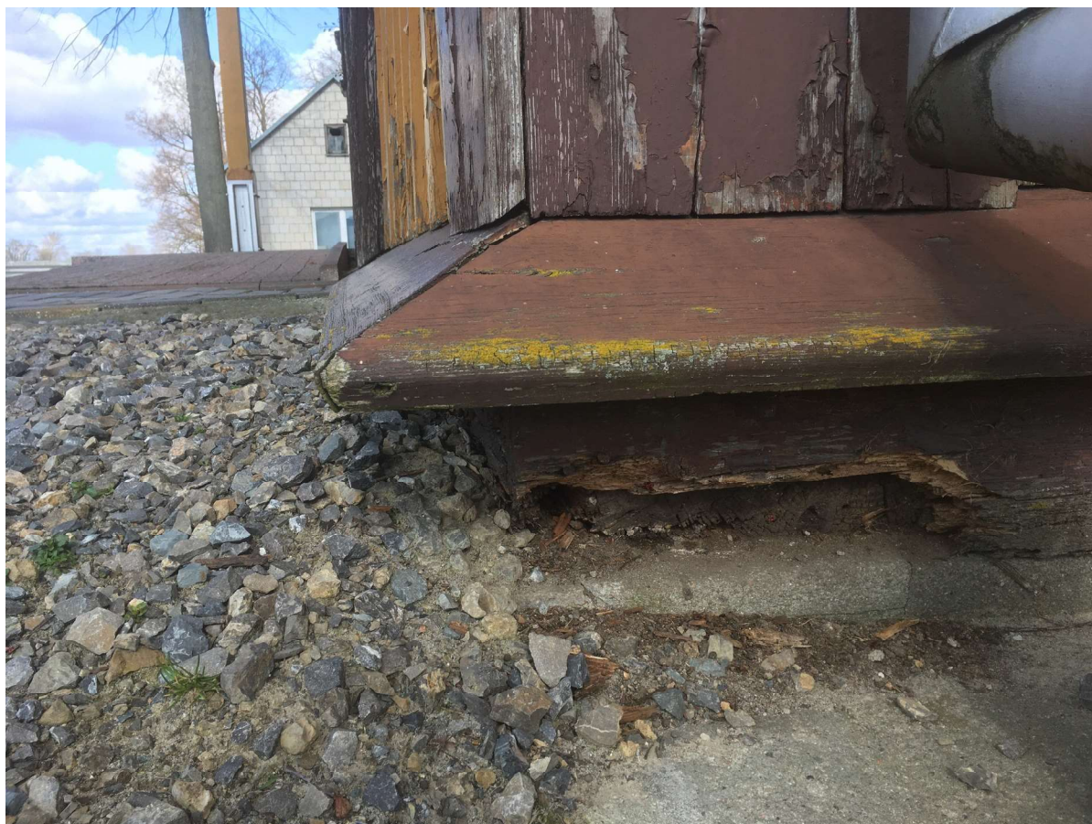
Fot. 27. Okapnik i podwalina, widoczna degradacja warstw.
