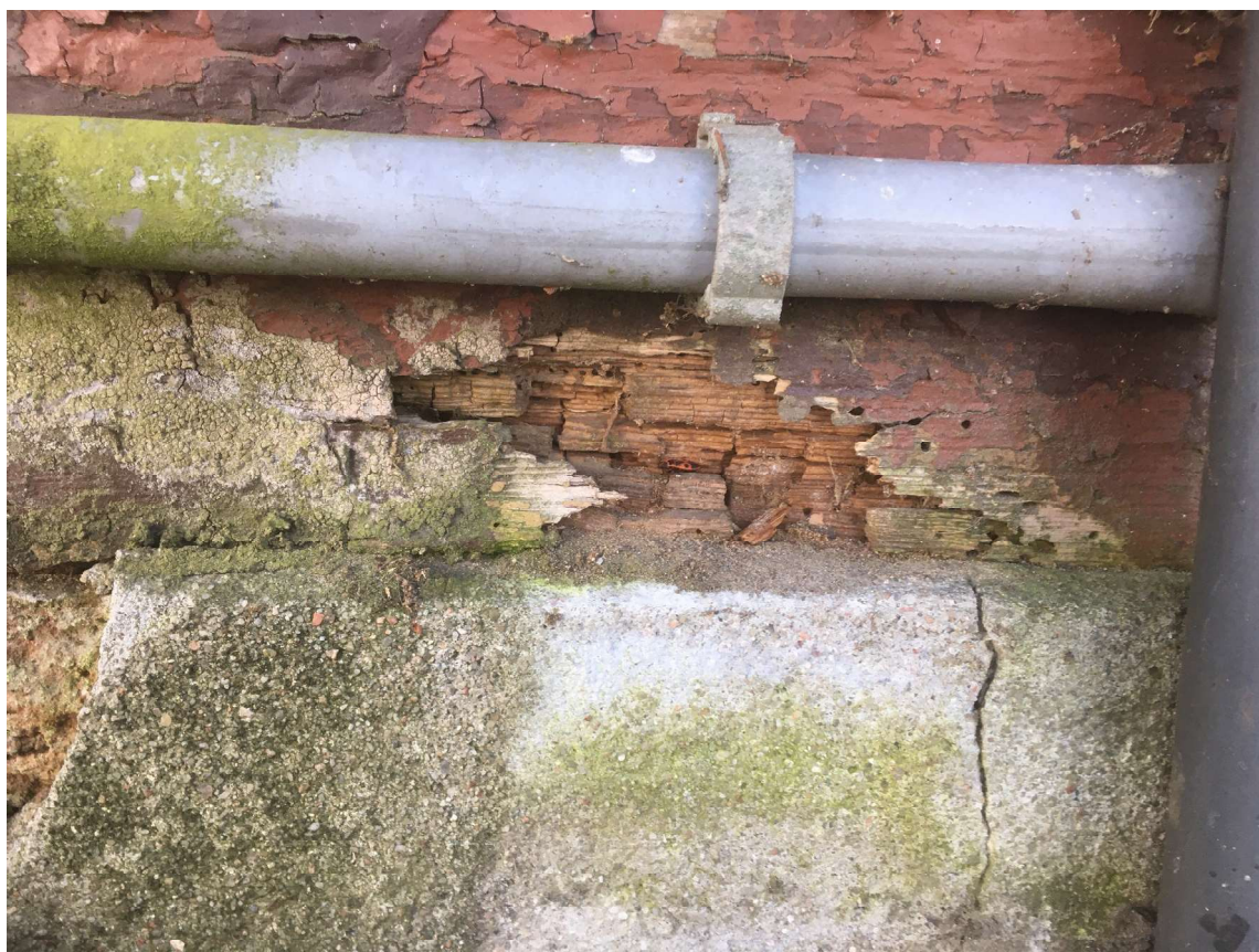
Fot. 34. Styk podwaliny i fundamentu pokrytego zaprawą cementową.
