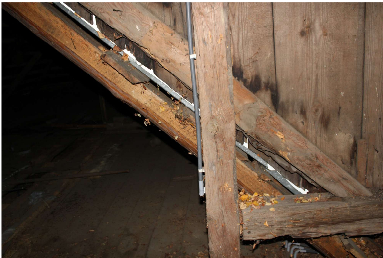
Fot. 48. Zawilgocenie na styku brył nawy i prezbiterium- niewydolna obróbka blacharska.
