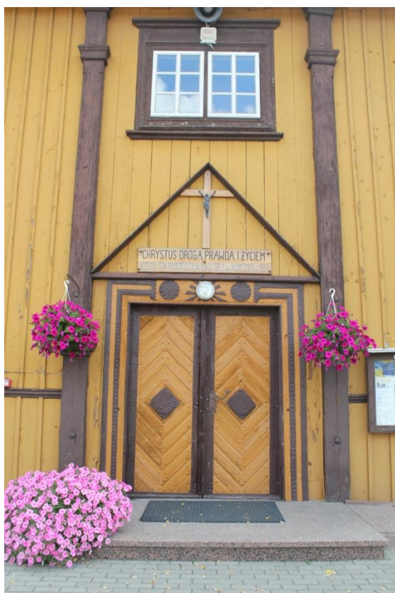
Fot.16. Kościół w Zofiborze, strefa wejścia głównego. Widoczne obramienie drzwi, ponad nim okno z obramowaniem oraz gzymsem dolnym i górnym.
