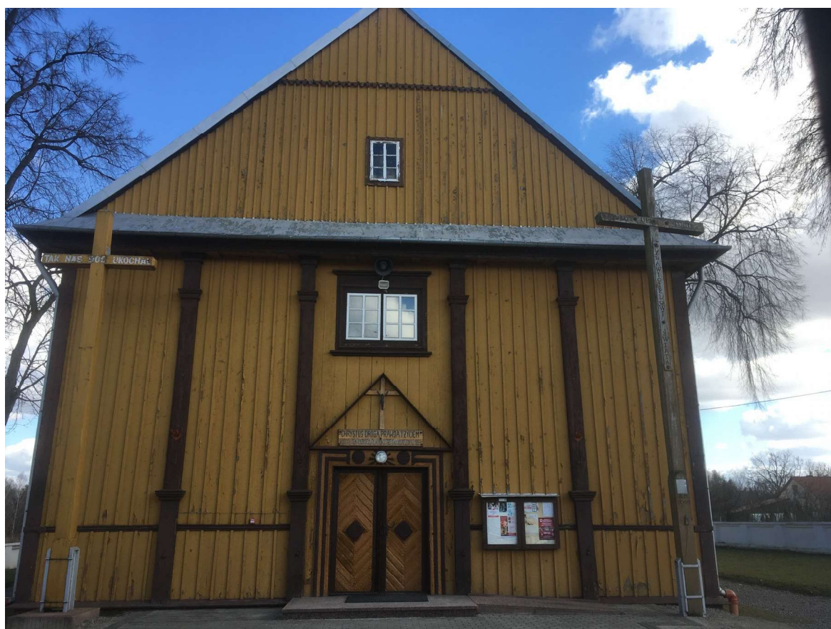
Fot. 2. Elewacja zachodnia, widoczne podziały lisicami, drzwi wejściowe ze szczykiem z listewek, okna w osi oraz szczyt nad bryłą nawy ponad linią okapu.
