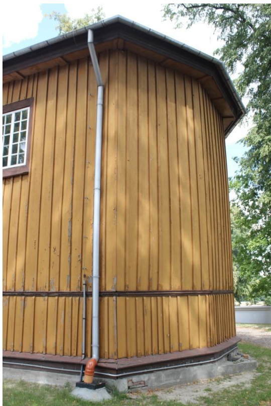
Fot.4. Kościół w Zofiborze, widok od strony wschodniej, zamknięcie prezbiterium. Widoczne ubytki w obrzutce cementowej cokołu.
