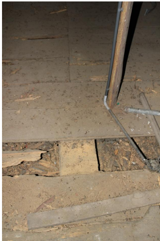
Fot.40. Kościół w Zofiborze, widok ogólny na deskowanie podłogi poddasza. Widoczne ubytki w deskowaniu.
