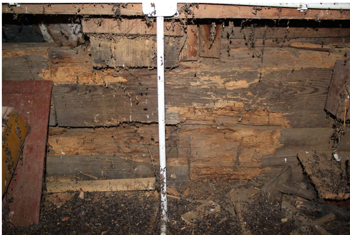
Fot. 45. Ściana szczytowa, degradacja drewna ( owady, wilgoć).
