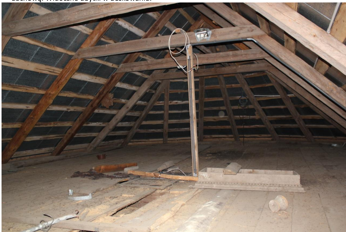
Fot.38. Kościół w Zofiborze, widok ogólny na więźbę dachową nad prezbiterium. Widoczne ubytki w deskowaniu podłogi oraz mączka po żerowaniu drewno jądów.
