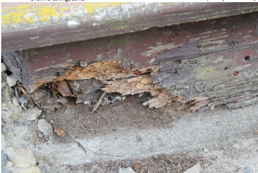
Fot.14. Kościół w Zofiborze, cokół z obrzutką cementową, na nim drewniana podwalina w stanie krytycznym. Drewno nie ma żadnych właściwości nośnych. Narożnik południowozachodni.
