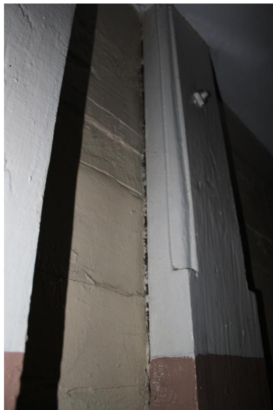
Fot.27. Kościół w Zofiborze, wnętrze, widok na ścianę wewnętrzną i bierwiona. Widoczna pomiędzy lisicami a bierwionami szeroka przerwa.
