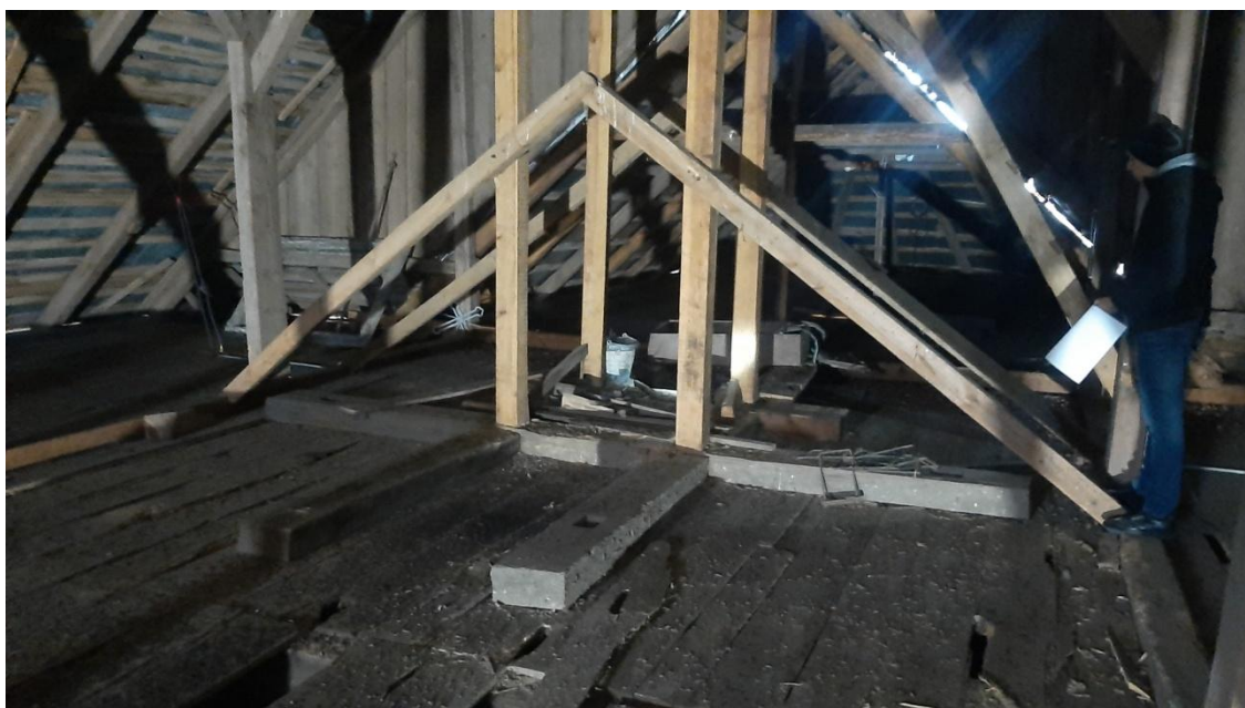
Fot.46. Kościół w Zofiborze, widok na wtórne wzmocnienia konstrukcji latarni.
