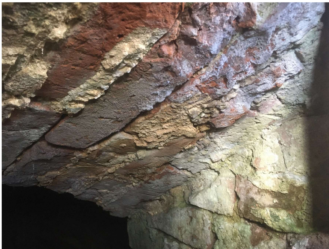
Fot. 38. Okienko wentylacyjne murowane, widoczna degradacja powierzchni cegieł oraz naloty wykrystalizowanych soli rozpuszczalnych.
