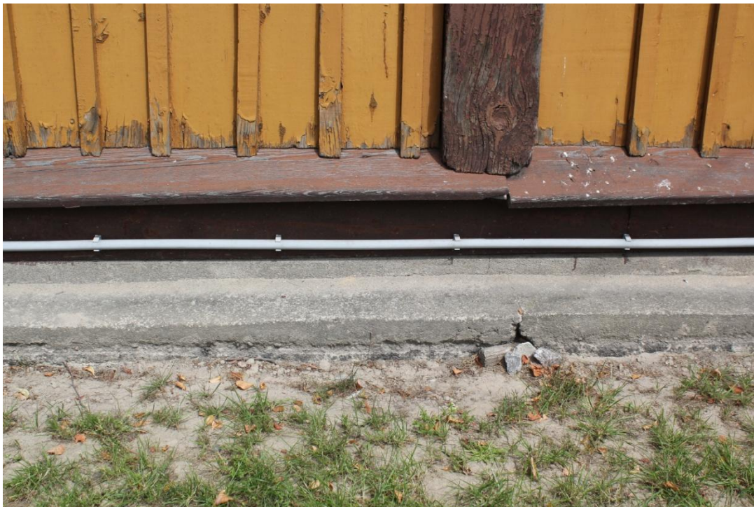
Fot.15. Kościół w Zofiborze, cokół z obrzutką cementową, na nim drewniana podwalina.
