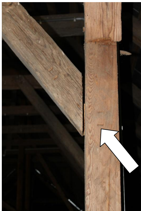
Fot. 7. Ciesielskie znaki montażowe na słupach wsporczych więźby dachowej.
