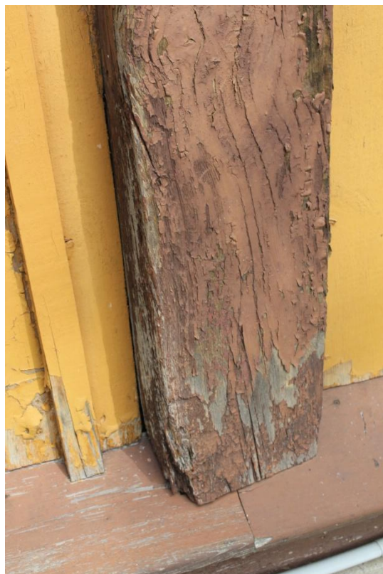
Fot.9. Kościół w Zofiborze, lisice zewnętrzne w dolnej części nad okapnikiem. Widoczne rozeschnięcia i ubytki drewna.
