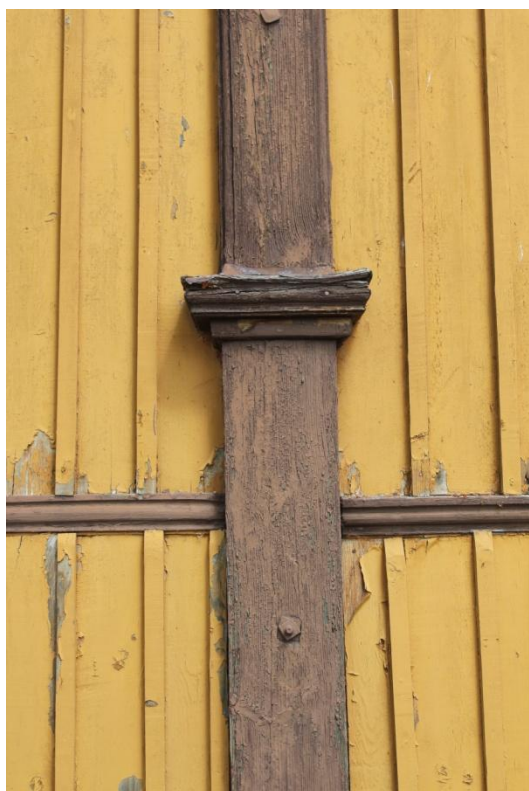
Fot.6. Kościół w Zofiborze, lisice zewnętrzne z detalem.
