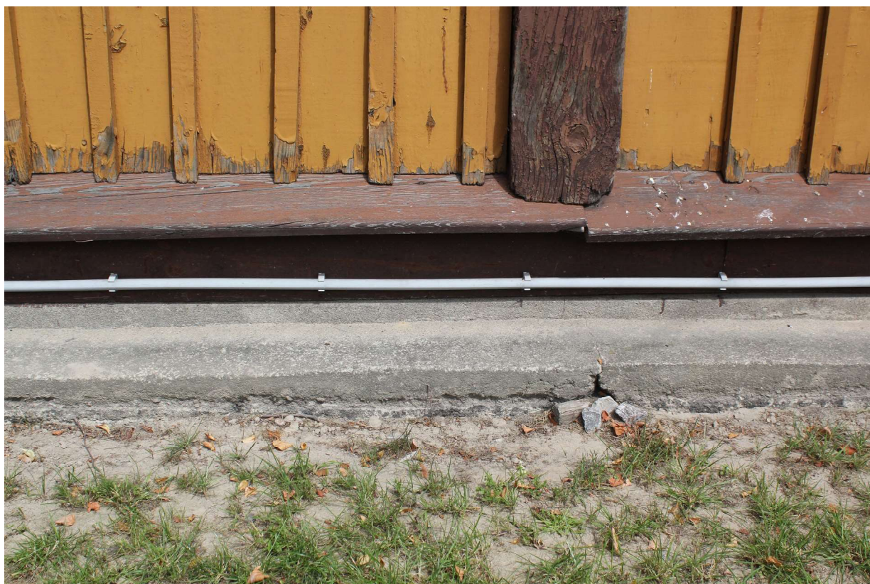
Fot. 29. Fundament z wtórnymi warstwami cementowymi, powyżej spaczony okapnik i skorodowane zakończenia desek szalunku.
