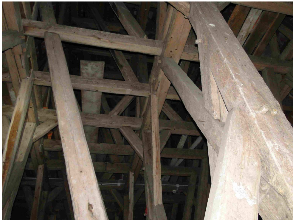
Foto 99. Fragment oryginalnej konstrukcji storczykowej
