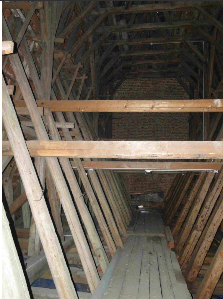
Foto 83. Widok układu konstrukcyjnego transeptu
