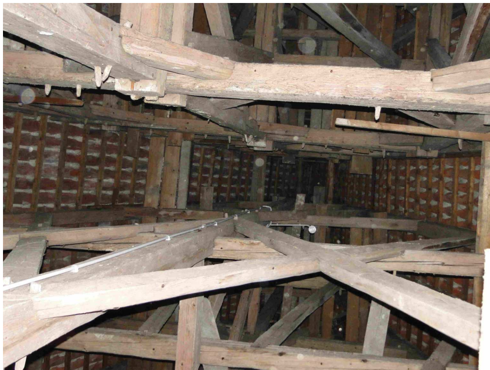
Foto 84. Granica pomiędzy więźbą storczykową w strefie międzywieżowej a konstrukcją na nawę główną
