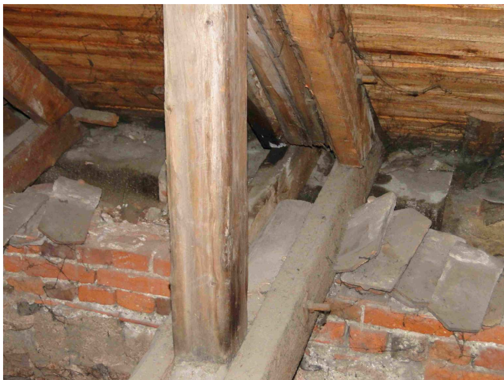
Foto 48. Nadmurowanie korony ścian cegłą ceramiczną
