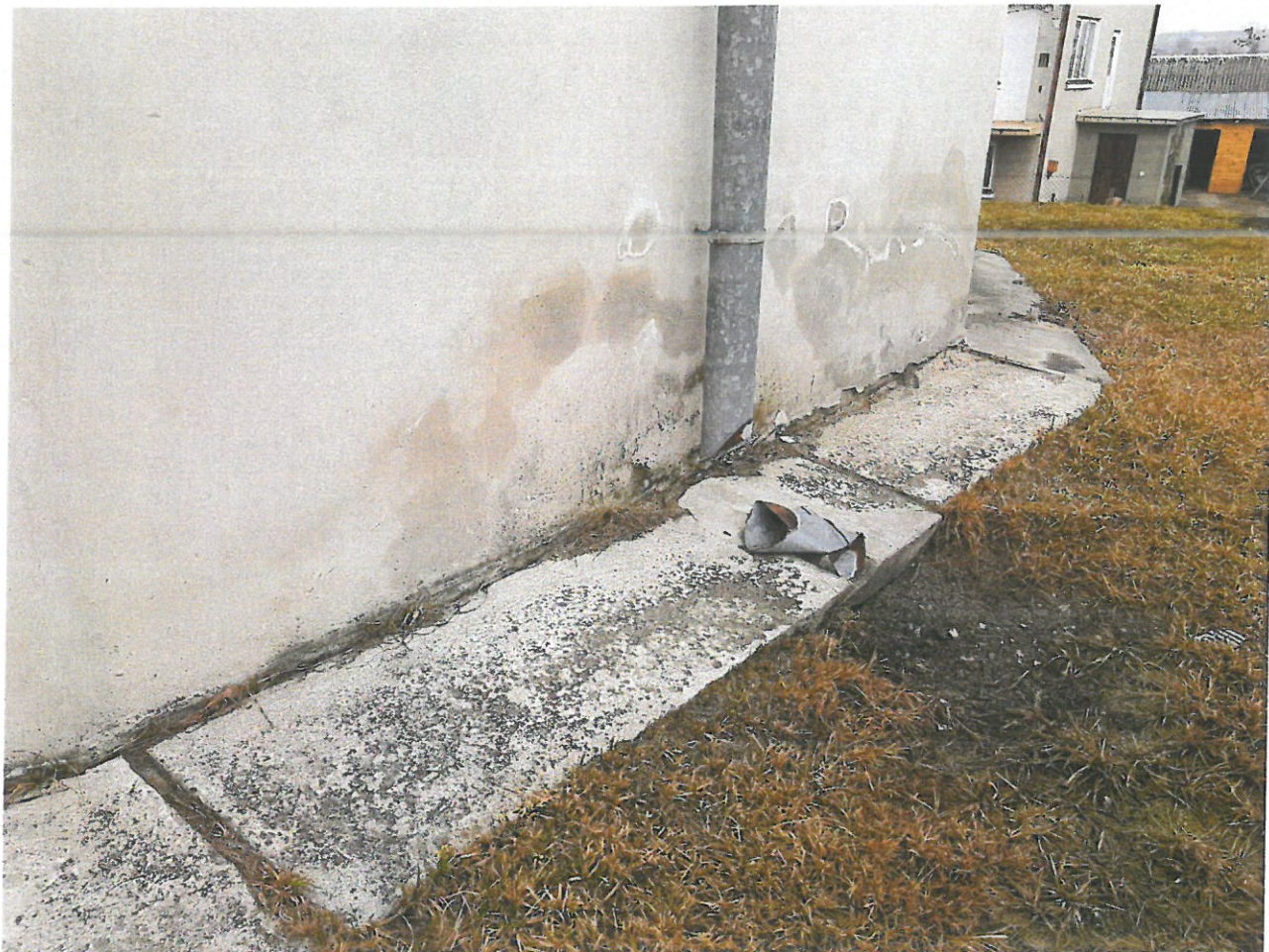
Fot.15 Odprowadzenie wody opadowej – strona wschodnia
