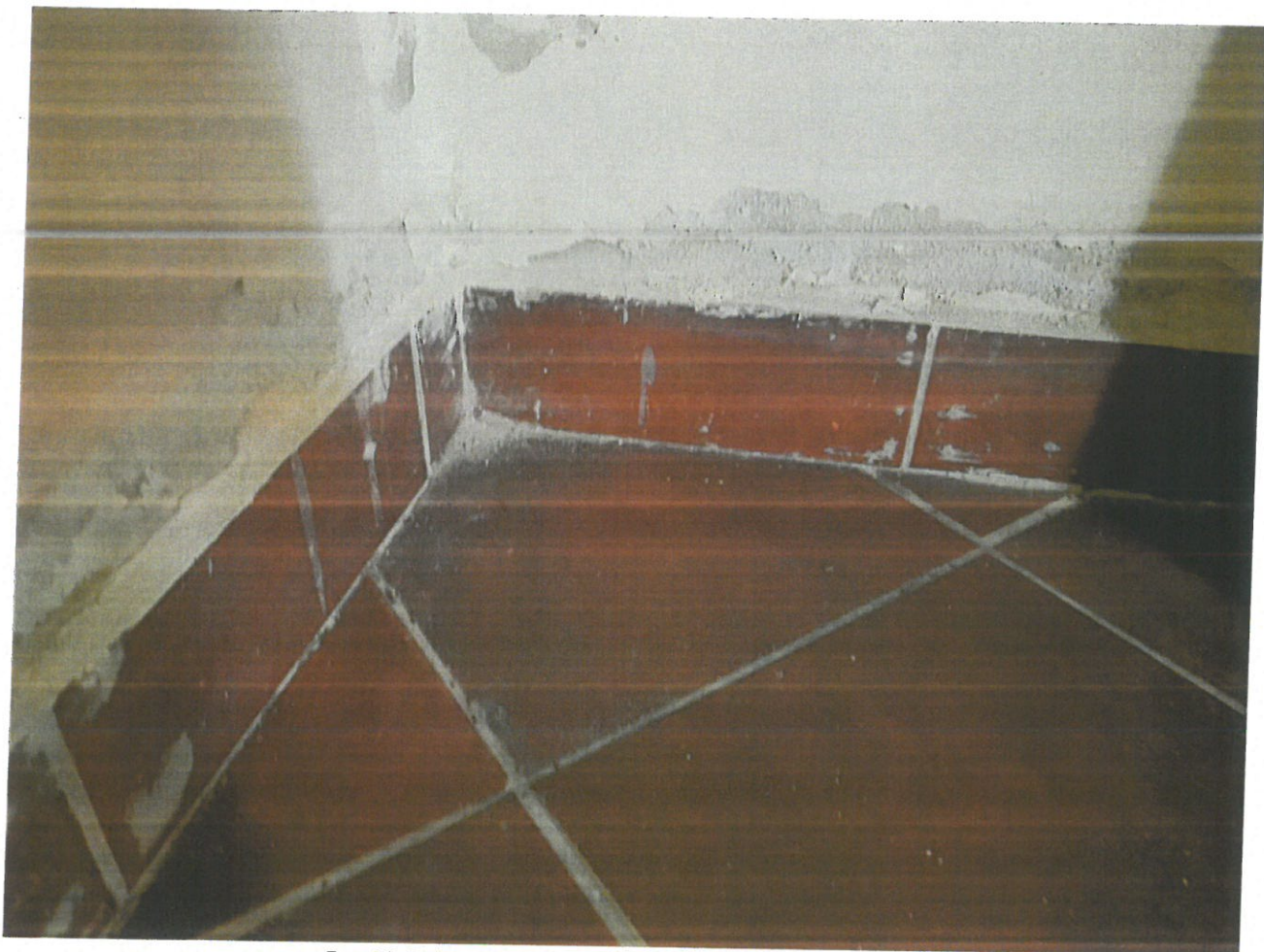
Fot.19 Zniszczenia tynku na ścianach części głównej
