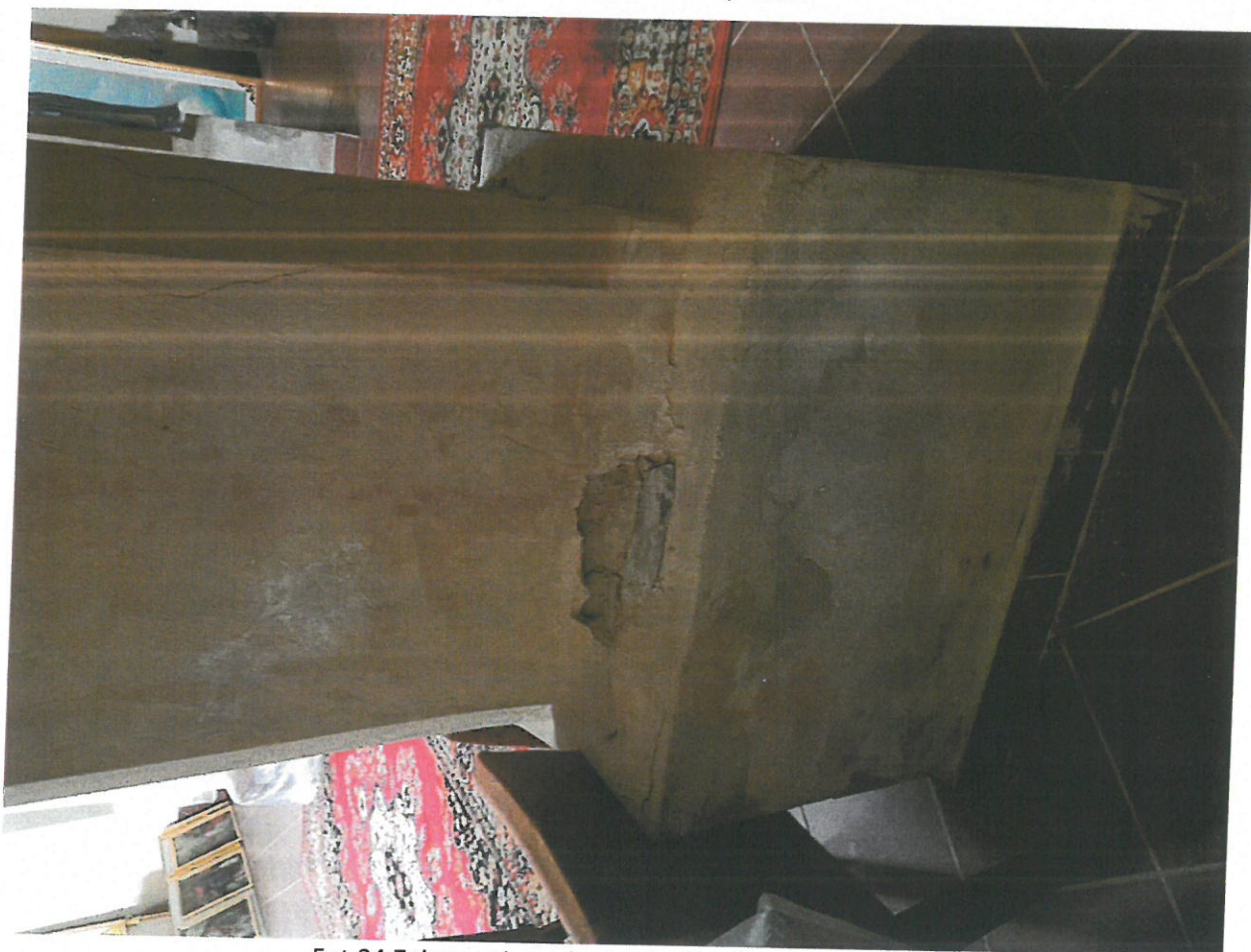
Fot.24 Zniszczenia tynku na słupie północnym chóru
