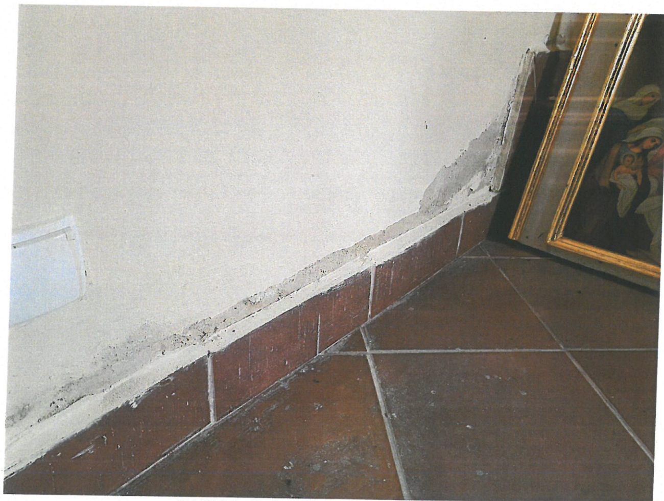
Fot.20 Zniszczenia tynku na ścianie części głównej
