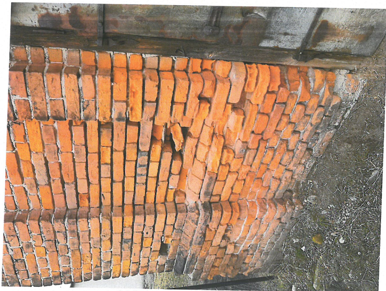
Fot.6 Zniszczenia w elewacji południowej
