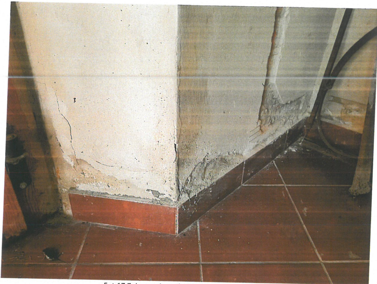
Fot.17 Zniszczenia tynku na ścianie przedsionka
