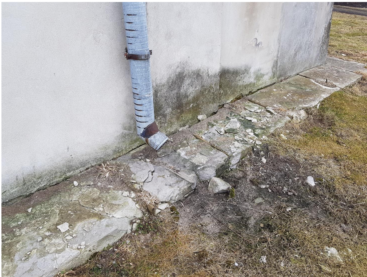
Fot.16 Odprowadzenie wody opadowej – strona północna
