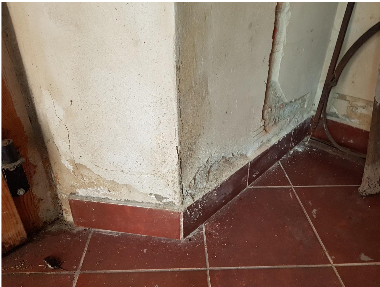
Fot.17 Zniszczenia tynku na ścianie przedsionka
