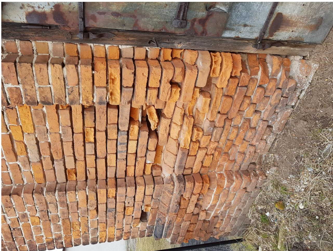
Fot.6 Zniszczenia w elewacji południowej
