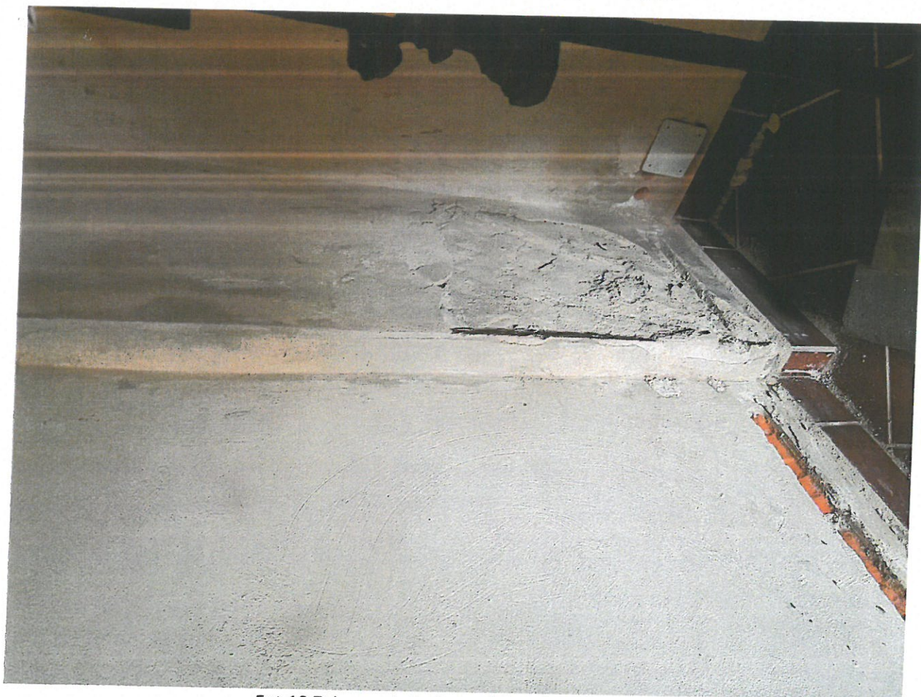
Fot.18 Zniszczenia tynku na ścianie przedsionka
