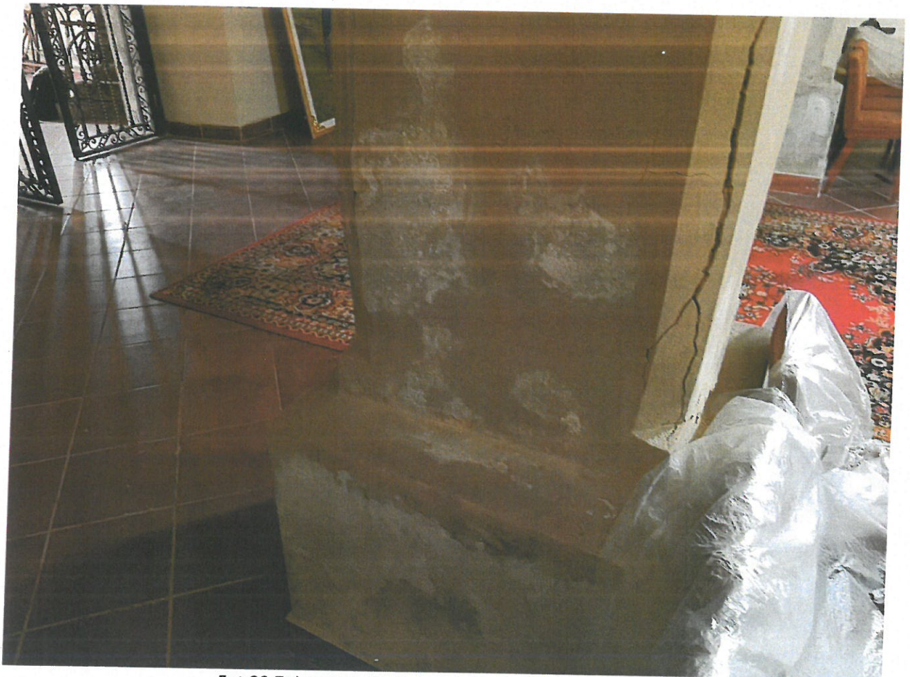
Fot.22 Zniszczenia tynku na słupie południowym chóru
