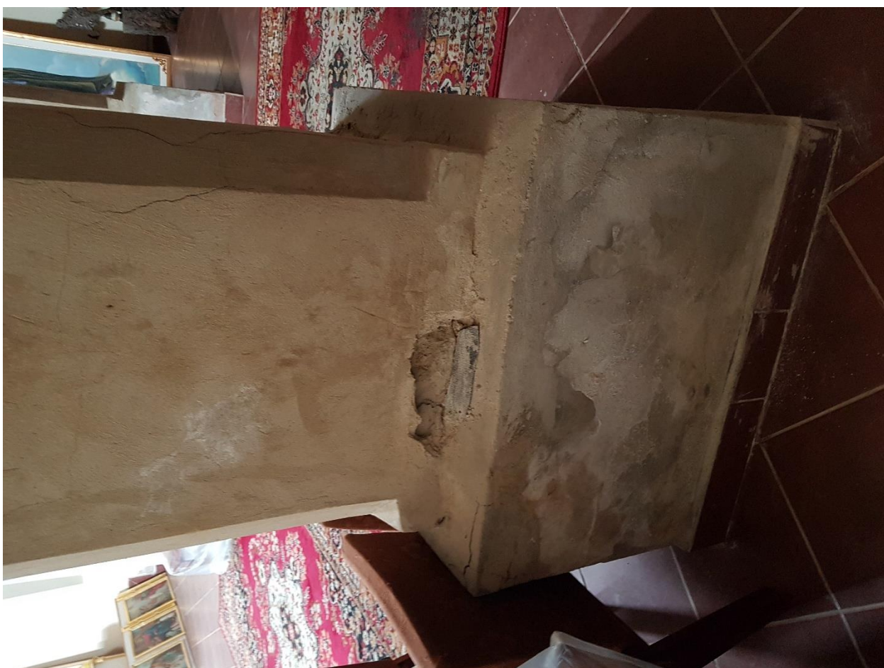
Fot.24 Zniszczenia tynku na słupie północnym chóru
