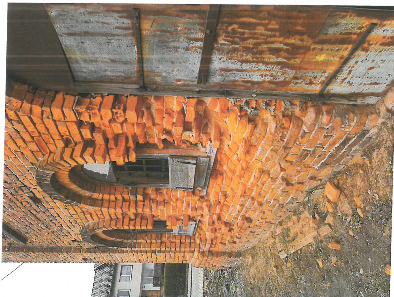
Fot.8 Zniszczenia w elewacji wschodniej
