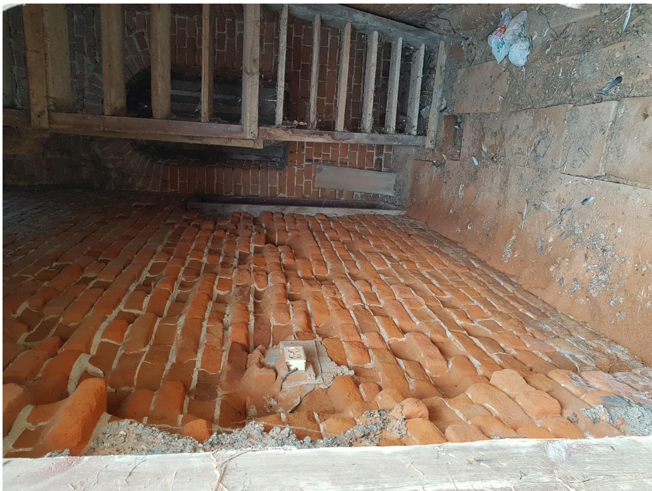
Fot.14 Zniszczenia ściany wewnętrznej parteru
