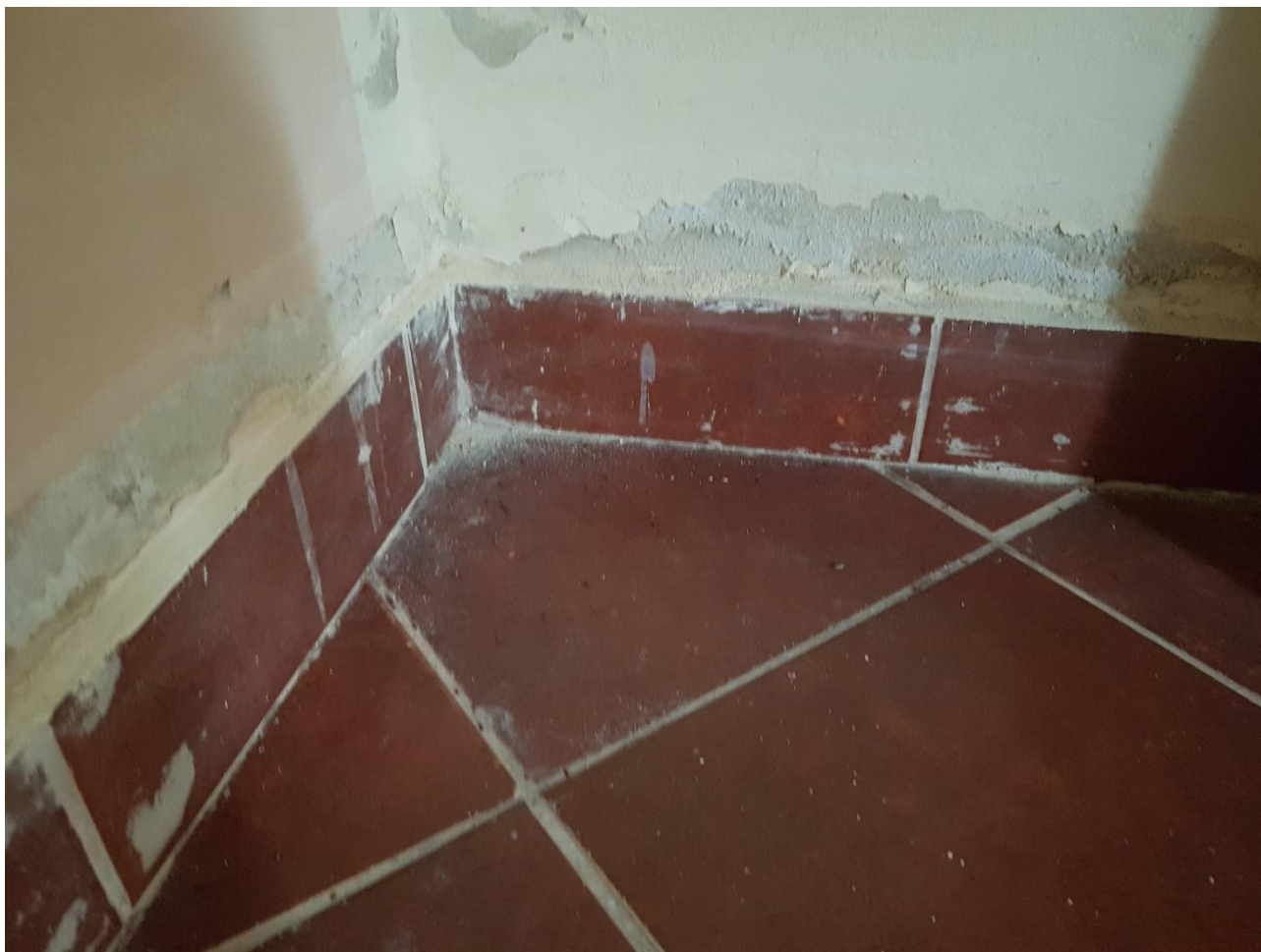
Fot.19 Zniszczenia tynku na ścianach części głównej
