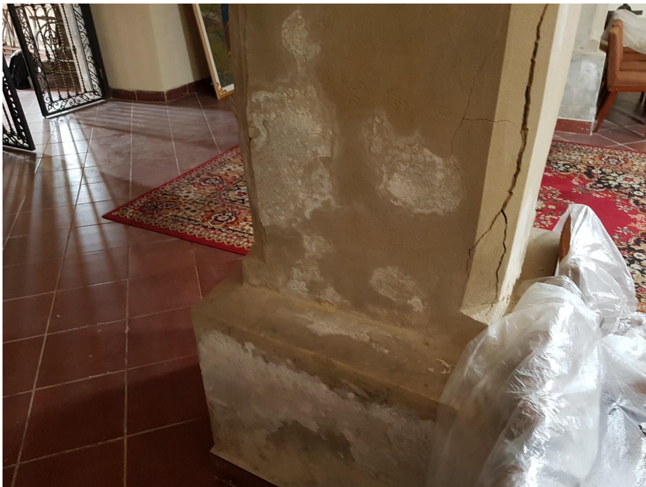
Fot.22 Zniszczenia tynku na słupie południowym chóru
