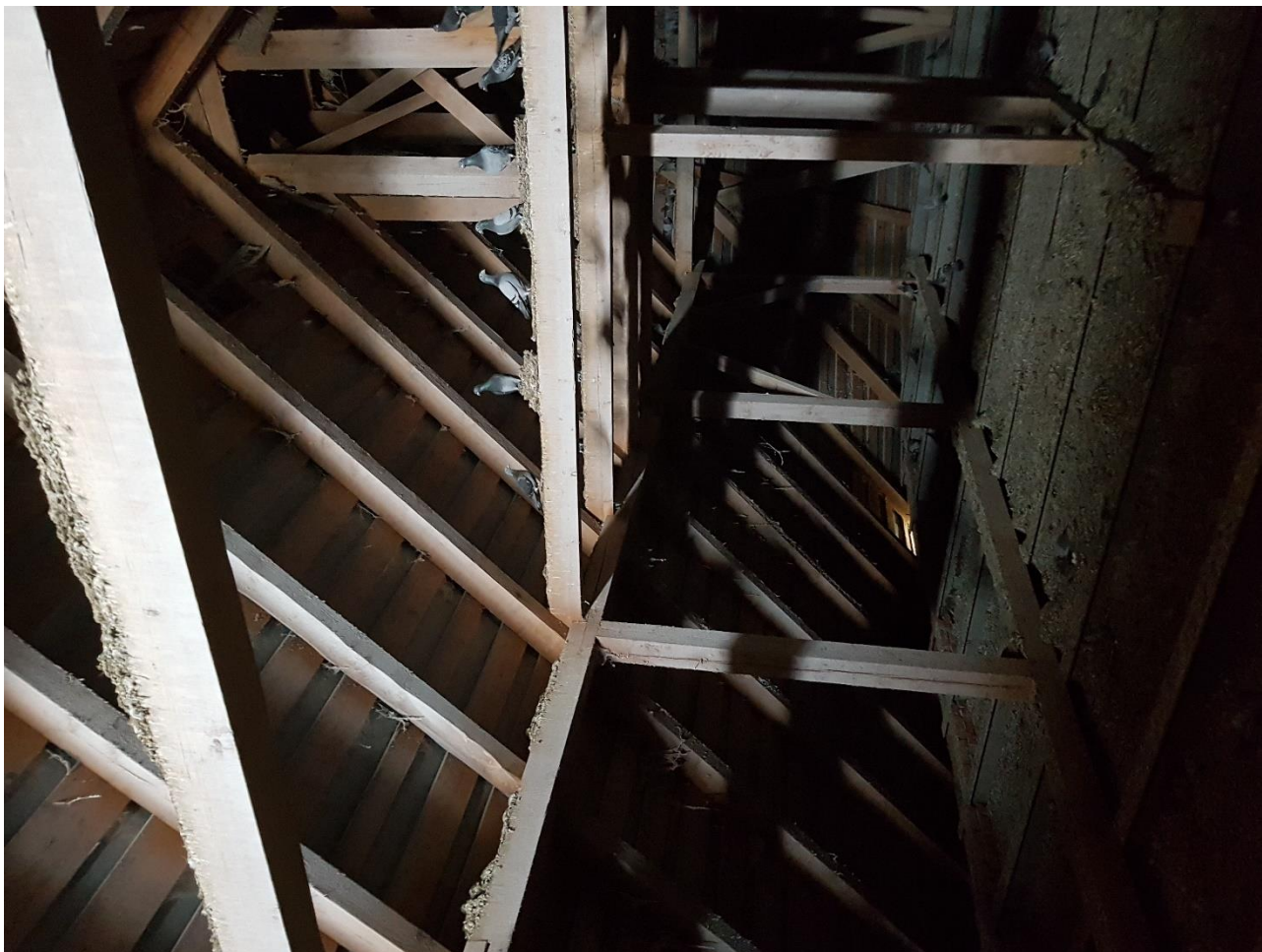
Fot.7 Wieżba dachowa
