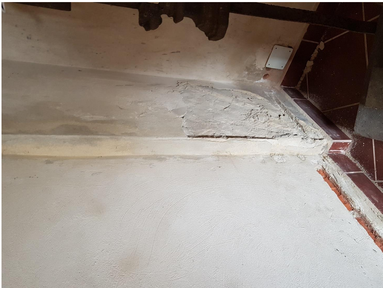
Fot.18 Zniszczenia tynku na ścianie przedsionka
