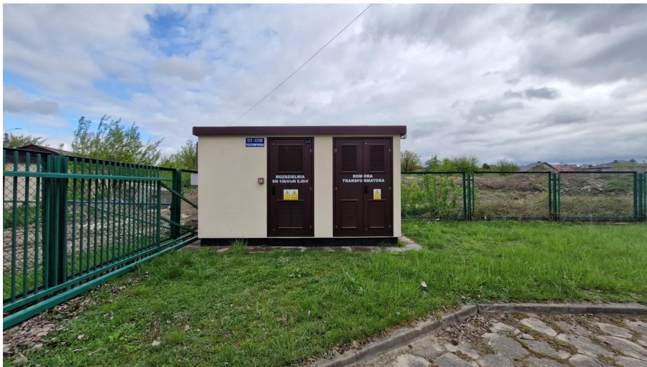
Rysunek 5 Rozdzielnia SN + komora transformatora
