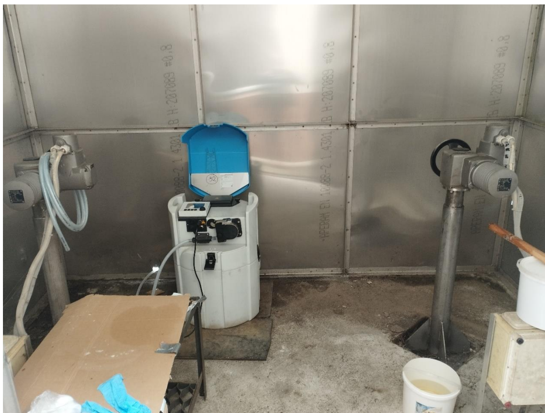
Rysunek 23 Stacja poboru próbek ścieków surowych zlokalizowana na komorze zasuw
