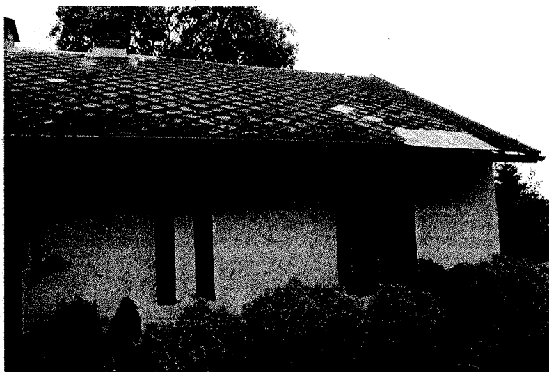
Fot. 4 Zawilgocenia ścian zewewnętrznych, ubytki w pokryciu dachu.
