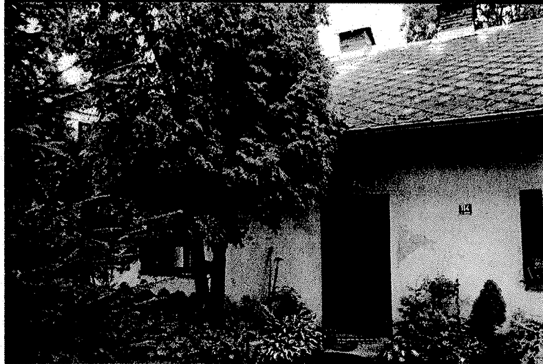
Fot. 5 Zawilgocenia ścian zewewnętrznych, ubytki w pokryciu dachu.
