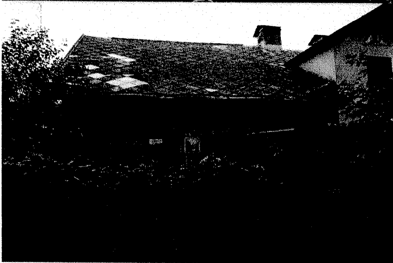
Fot. 3 Zawilgocenia ścian zewewnętrznych, ubytki w pokryciu dachu.
