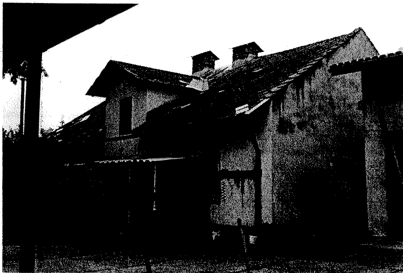
Fot. 1 Zawilgocenia ścian zewewnętrznych, ubytki w pokryciu dachu.
