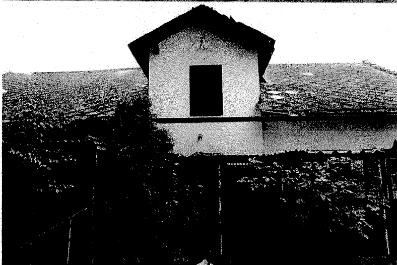
Fot. 2 Zawilgocenia ścian zewewnętrznych, ubytki w pokryciu dachu.
