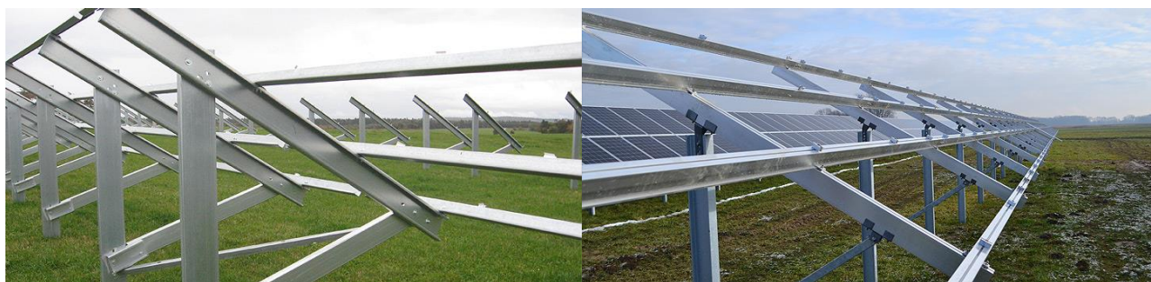
Rysunek nr 5. Przykładowe szkielety przed montażem paneli (Źródło: servus-solar.com).
