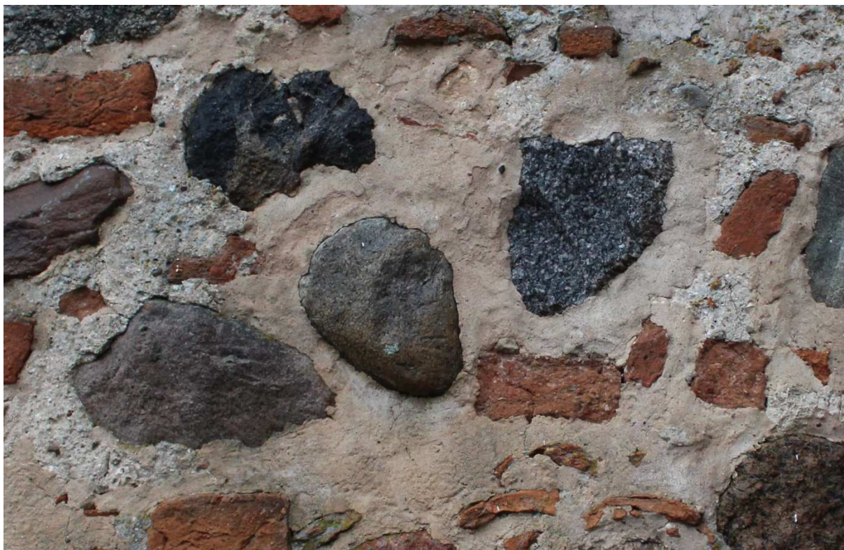
Fot.15. Kielbasin, kościół pw. NARODZENIA NMP, fragment wątku kamiennego przyziemia wieży. Ciemniejsza spoina to współczesna zaprawa konserwatorska, widoczna dzięki wysokiej zawartości pigmentów i innej od oryginału nasiąkliwości. Czytelność uzupełnień może się zmieniać w zależności od warunków atmosferycznych i wilgotności powietrza.
