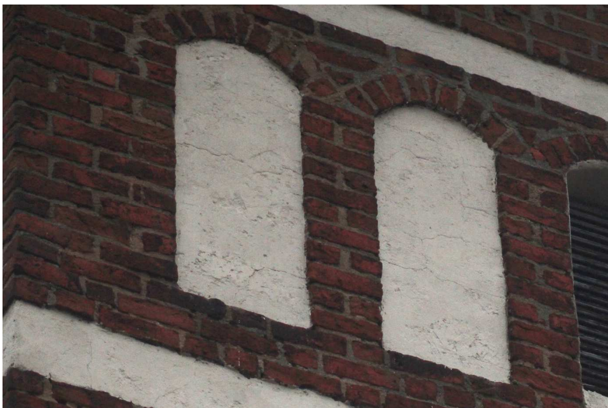
Fot.26. Kiełbasin, kościół pw. NARODZENIA NMP, kamienny. Stan zachowania tynków blend wieży. Na zdjęciach widoczne głębokie spękania wypraw tynkarskich.
