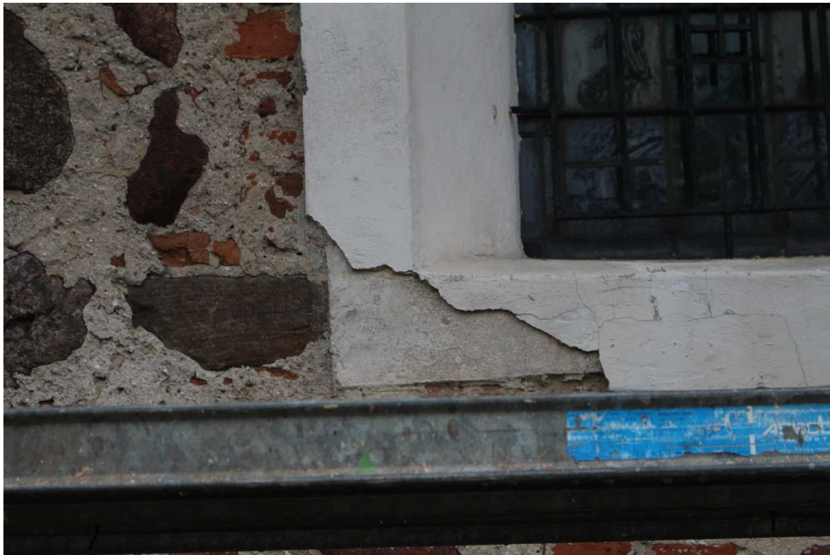
Fot.24. Kielbasin, kościół pw. NARODZENIA NMP, opaska drugiego okna elewacji południowej. Na zdjęciu widoczne odspojenie zaprawy wierzchniej, ujawniające warstwową budowę tynków.
