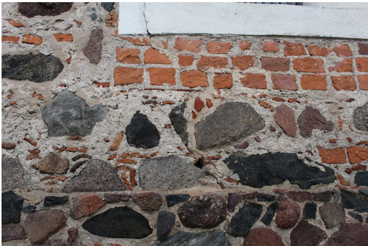
Fot.11. Kielbasin, kościół pw. NARODZENIA NMP, fragment wątku kamiennego i ceglanego elewacji południowej. Na zdjęciu widoczne włosowate spękanie przebiegające przez parapet okna pierwszej osi.
