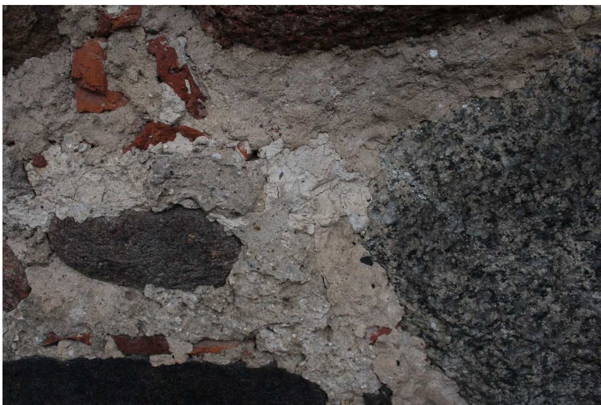
Fot.22. Kiełbasin, kościół pw. NARODZENIA NMP, kamienny. Stan zachowania spoin historycznych. Widoczne przemieszanie warstw historycznych i współczesnych.
