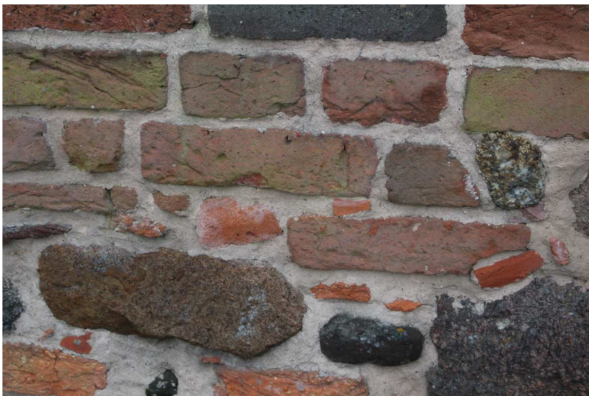
Fot.30. Kielbasin, kościół pw. NARODZENIA NMP, watek kamienny. Na zdjęciu nawarstwienia biologiczne, watek ceglany w strefie cokołowej.
