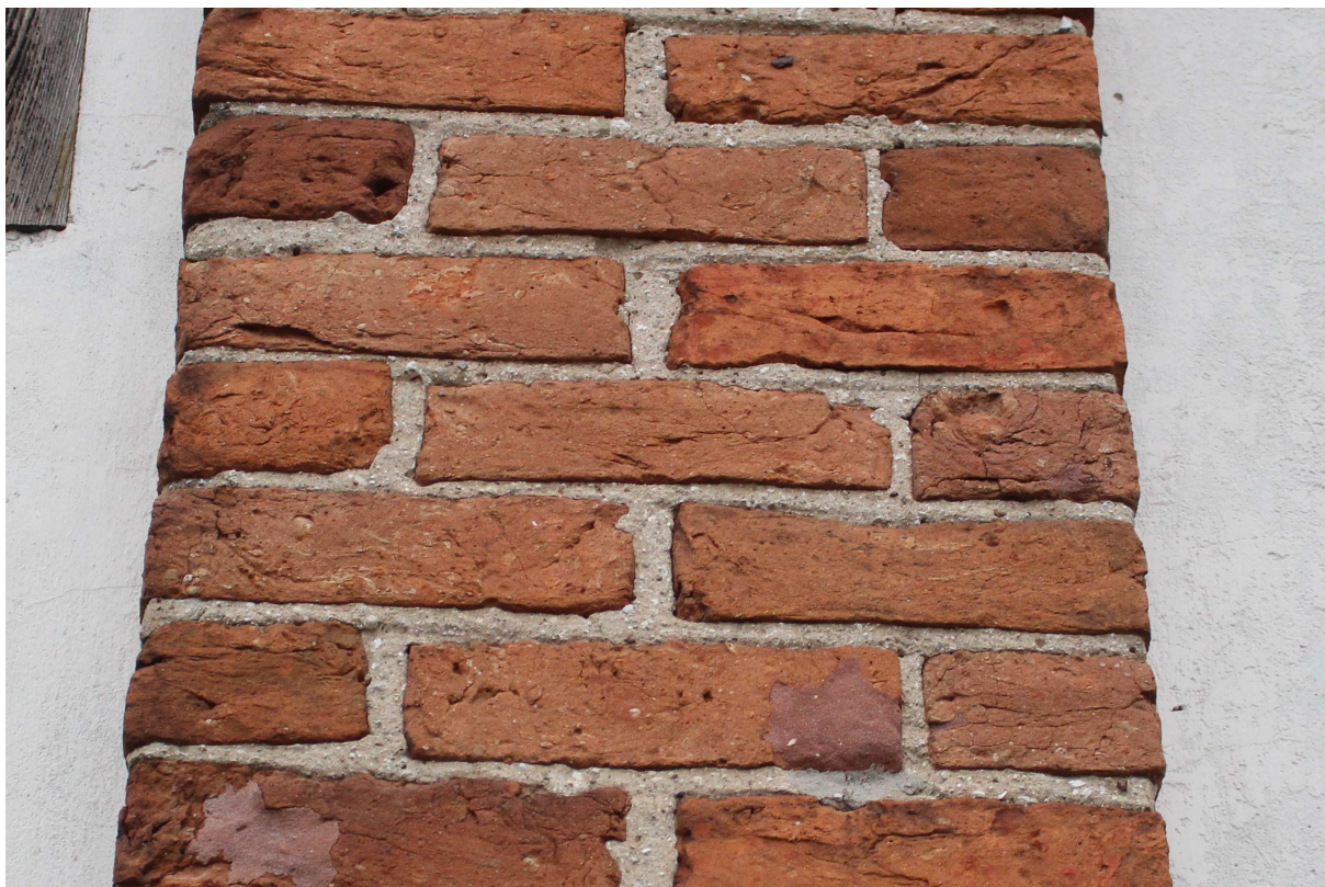
Fot.13. Kielbasin, kościół pw. NARODZENIA NMP, fragment wátku ceglanego elewacji wschodniej. Spoina wátku ceglanego zachowuje ślady opracowania w postaci tzw. podcięcia.
