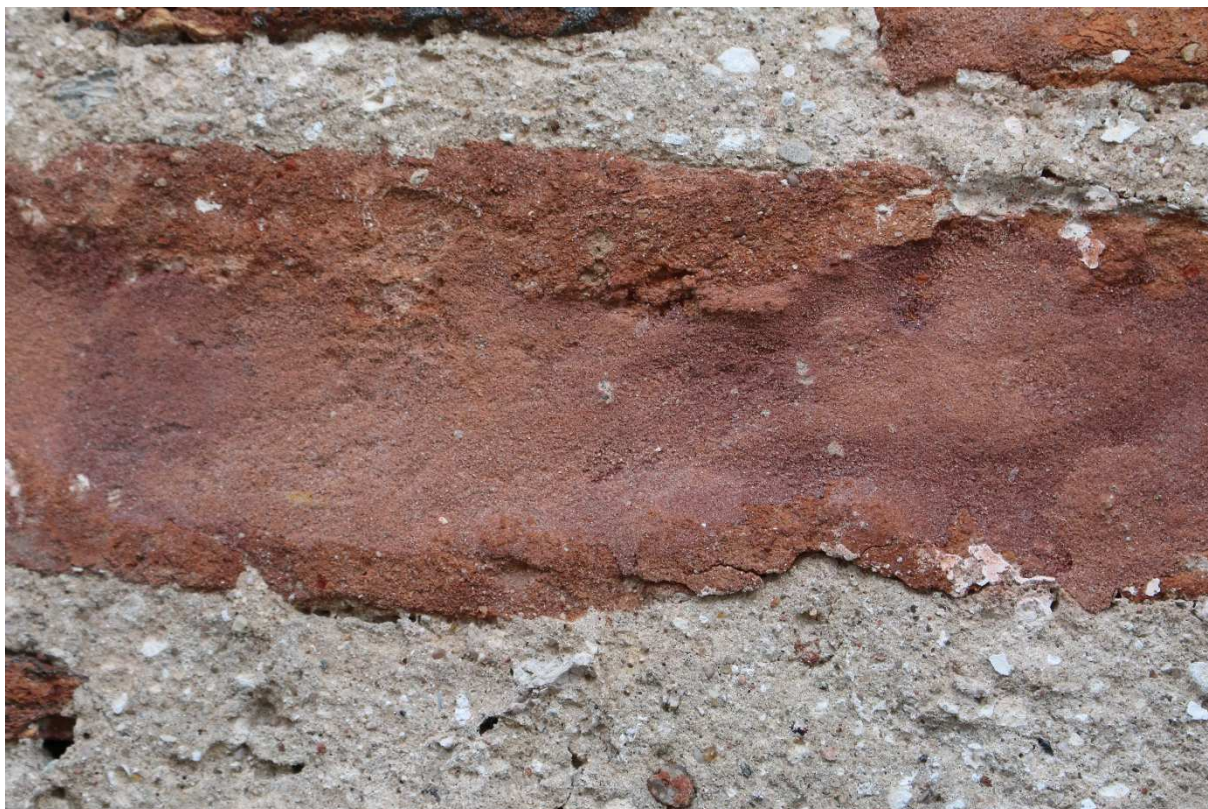
Fot.21. Kiełbasin, kościół pw. NARODZENIA NMP, wątek ceglany. Na zdjęciu cegła z zaprawą uzupełniającą.
