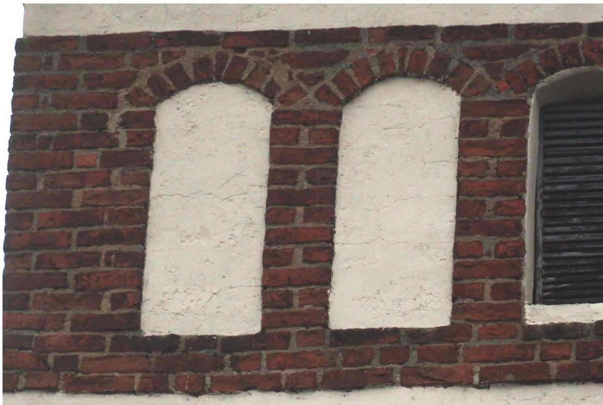
Fot.25. Kiełbasin, kościół pw. NARODZENIA NMP, kamienny. Stan zachowania tynków blend wieży. Na zdjęciach widoczne głębokie spękania wypraw tynkarskich pokryte jasną, współczesną monochromią.
