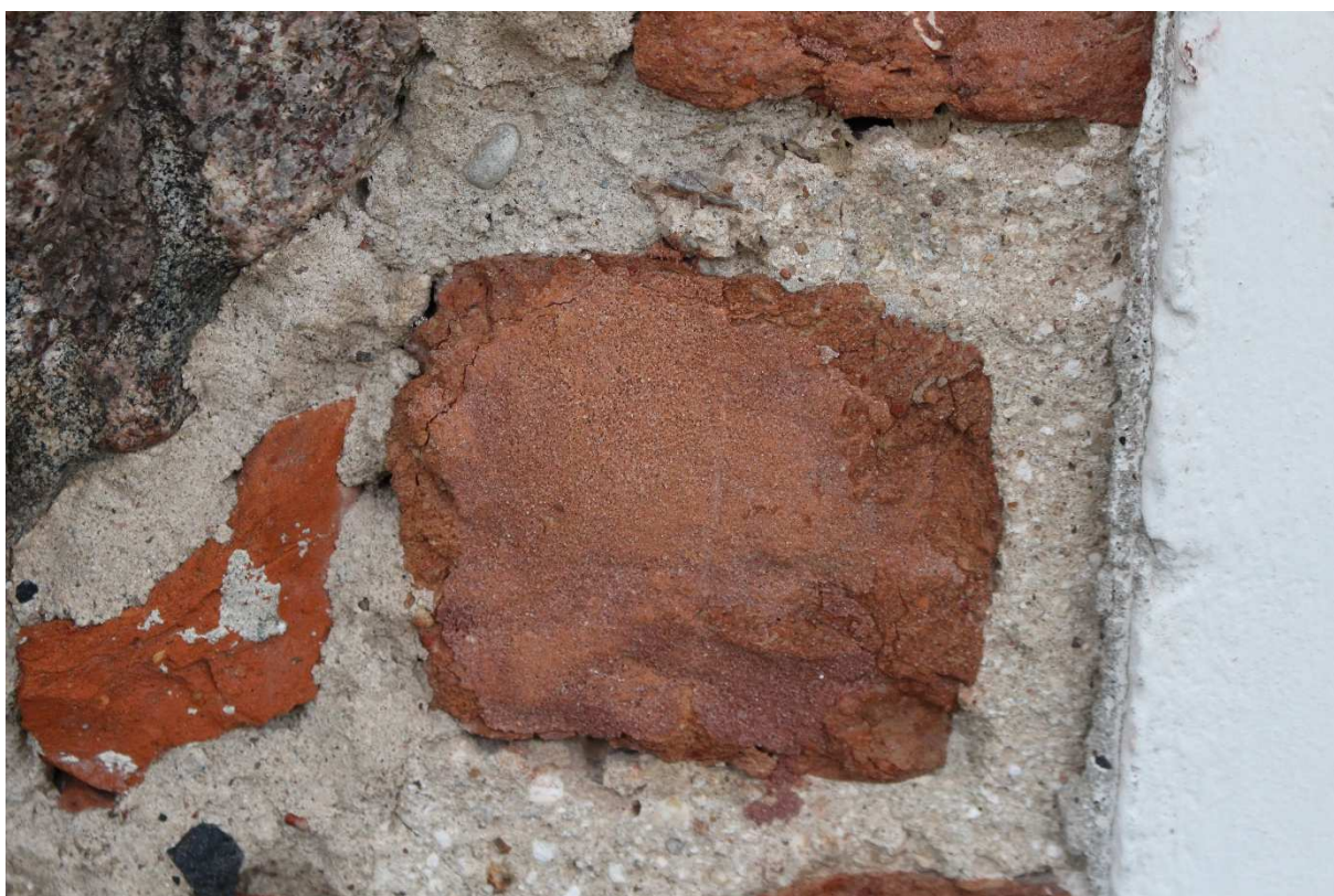
Fot.20. Kielbasin, kościół pw. NARODZENIA NMP, wątek ceglany. Na zdjęciu cegła z zaprawą uzupełniającą. Wokół cegły historyczna zaprawa spoinująca w kolorze jasno-brazowym.
