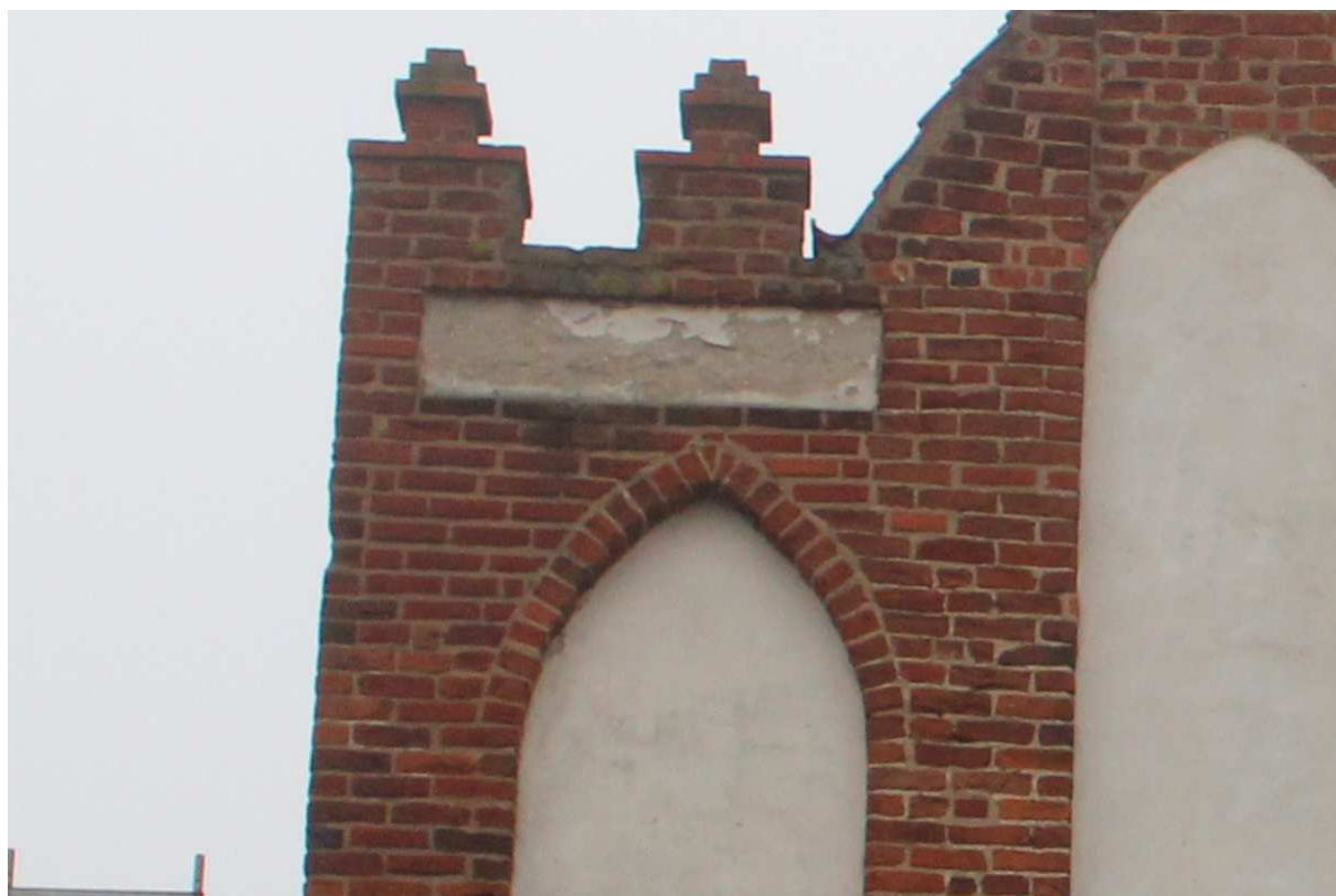
Fot.28. Kielbasin, kościół pw. NARODZENIA NMP, kamienny. Stan zachowania tynków szczytu wschodniego. Na zdjęciu widoczny odsłonięty miąższ tynków pola fryzowego. Ciemna kolorystyka i obecność grubego wypełniacza wskazują na historyczną proveniencję elementu.
