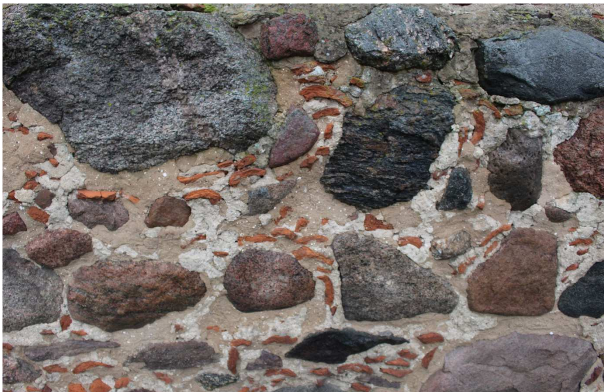
Fot.17. Kielbasin, kościół pw. NARODZENIA NMP, fragment wątku kamiennego przyziemia wieży. Ciemniejsza spoina to współczesna zaprawa konserwatorska, widoczna dzięki wysokiej zawartości pigmentów i innej od oryginału nasiąkliwości. Czytelność uzupełnień może się zmieniać w zależności od warunków atmosferycznych i wilgotności powietrza.
