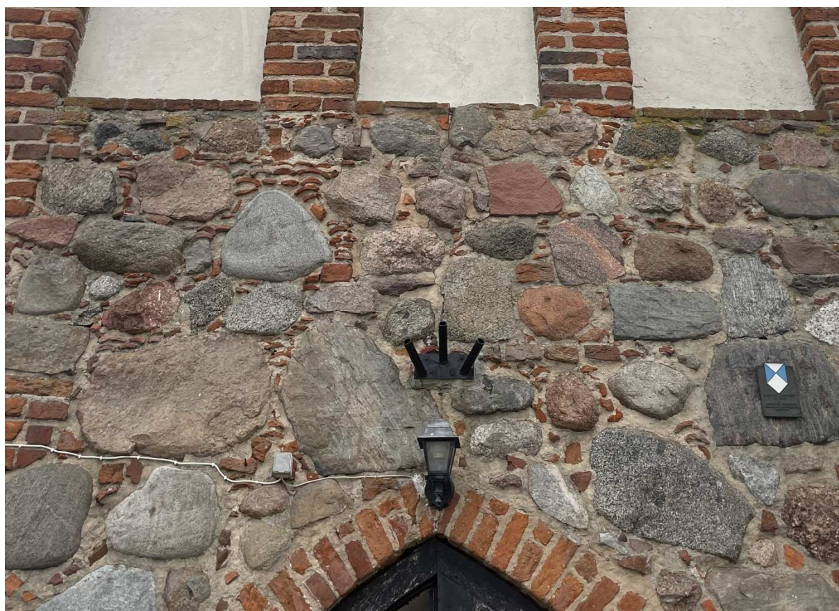
Fot.6. Kielbasin, kościół pw. NARODZENIA NMP, wążek kamienny nad portalem głównym. Spękanie ukryte w wążku kamiennym.
