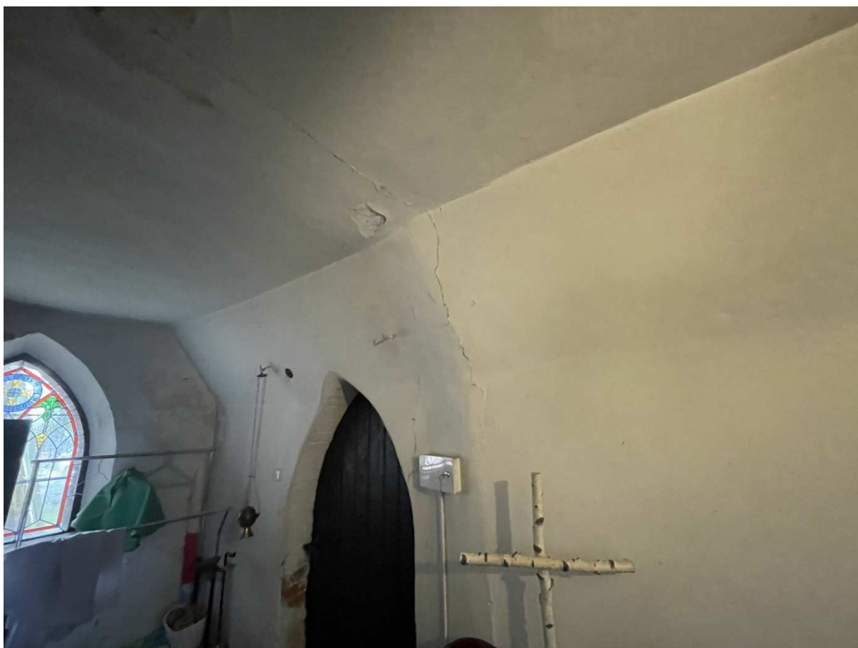
Fot.8. Kiełbasin, kościół pw. NARODZENIA NMP, spękanie ścian i stropu zakrystii.
