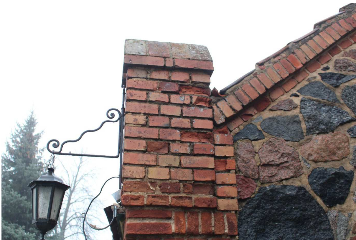
Fot.18. Kielbasin, kościół pw. NARODZENIA NMP, watek ceglany. Stan zachowania sterczynki zakrystii.
