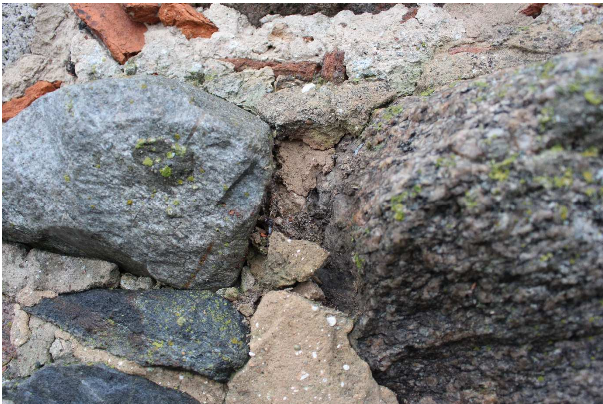
Fot.23. Kielbasin, kościół pw. NARODZENIA NMP, kamienny. Stan zachowania spoin. Widoczne liczne spękania oraz uzupełnienia.
