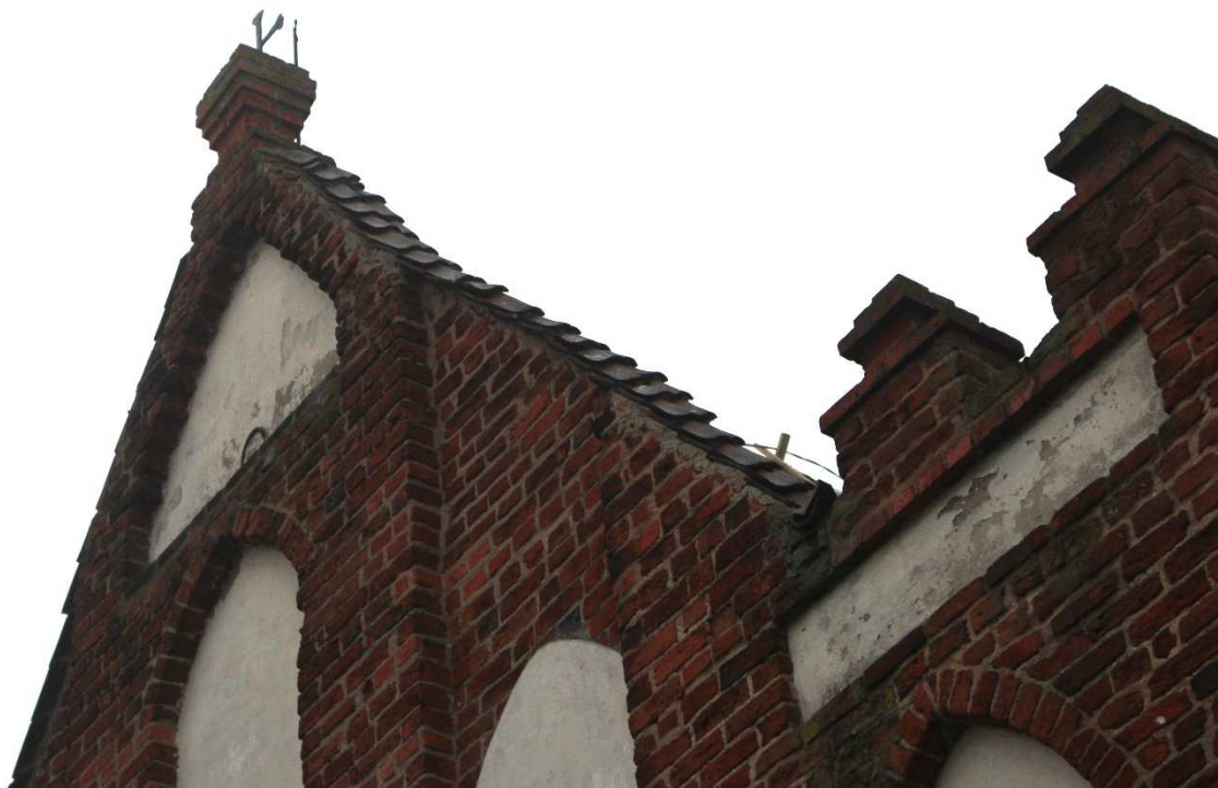
Fot.27. Kielbasin, kościół pw. NARODZENIA NMP, kamienny. Stan zachowania tynków szczytu wschodniego. Na zdjęciu widoczne złuszczenia i odspojenia warstwy malarskiej.
