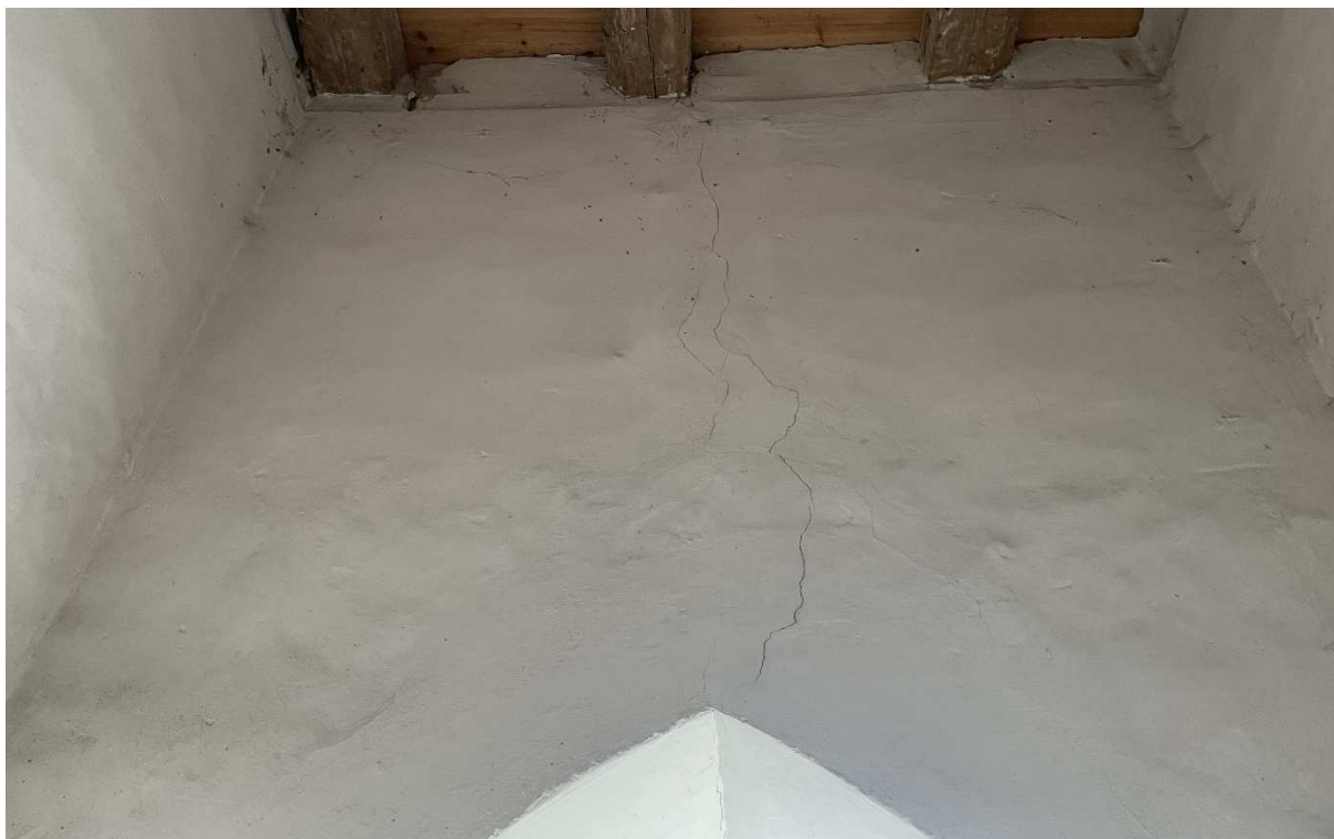
Fot.7. Kiełbasin, kościół pw. NARODZENIA NMP, spękanie zachodniej ściany wieży widoczne od wnętrza kruchty.
