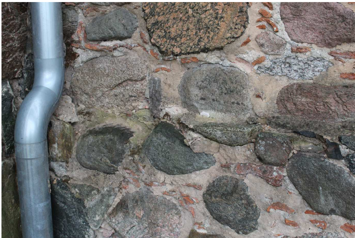
Fot.29. Kielbasin, kościół pw. NARODZENIA NMP, watek kamienny. Na zdjęciu nawarstwienia biologiczne pokrywające spływ odsadzki cokołu.
