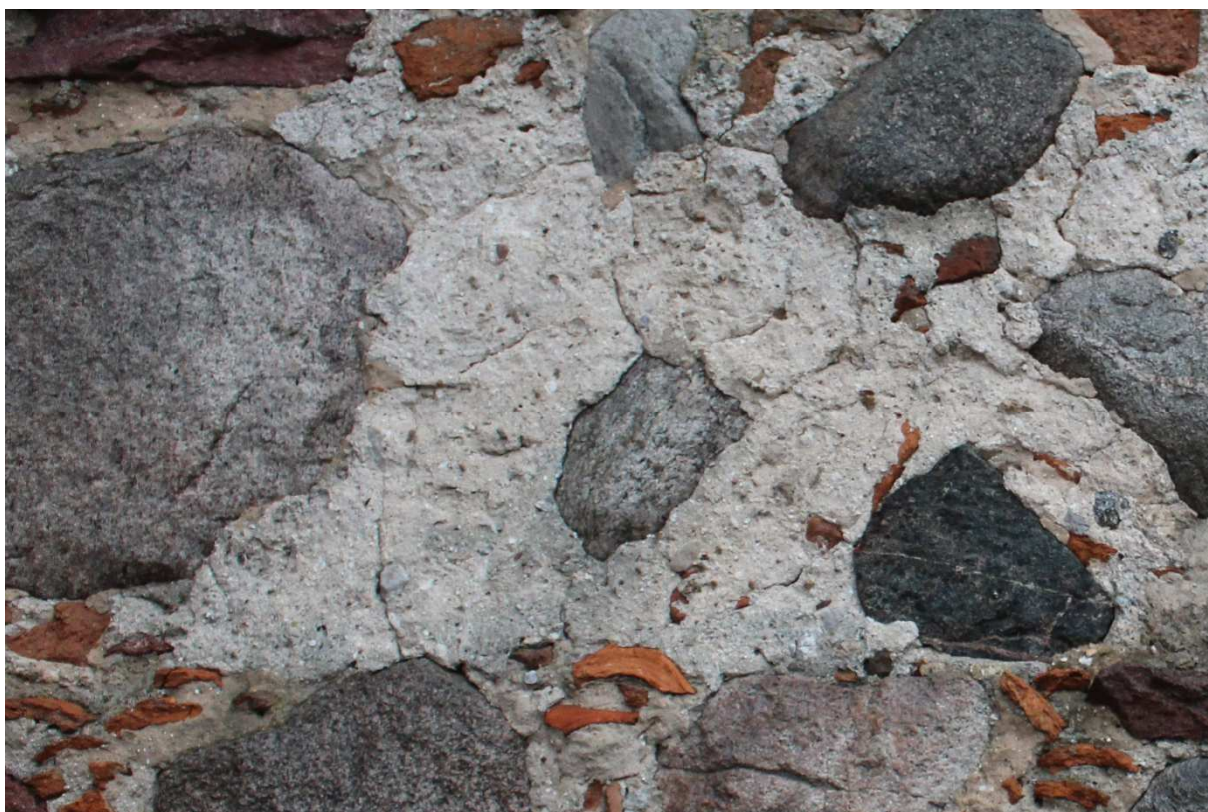
Fot.14. Kielbasin, kościół pw. NARODZENIA NMP, fragment wátku kamiennego przyziemia wieży. Widoczne spękania historycznych zapraw. Zapraw historyczna w kolorze szarym.
