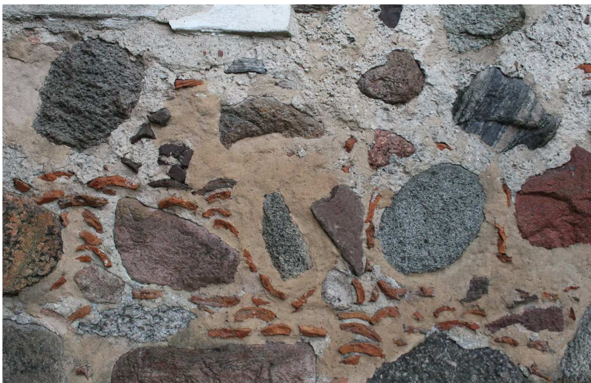
Fot.16. Kielbasin, kościół pw. NARODZENIA NMP, fragment wątku kamiennego przyziemia wieży. Ciemniejsza spoina to współczesna zaprawa konserwatorska, widoczna dzięki wysokiej zawartości pigmentów i innej od oryginału nasiąkliwości. Czytelność uzupełnień może się zmieniać w zależności od warunków atmosferycznych i wilgotności powietrza.
