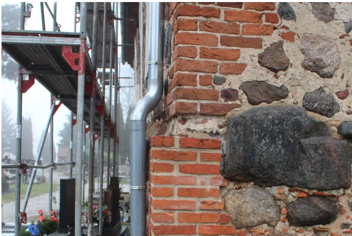
Fot.19. Kielbasin, kościół pw. NARODZENIA NMP, wątek ceglany. Ubytek w pokryciu spływu cokołu.
