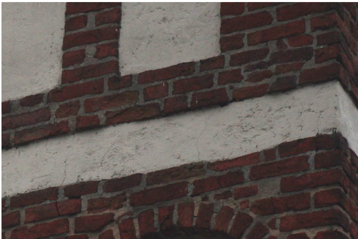
Fot.9. Kielbasin, kościół pw. NARODZENIA NMP, zachodnia elewacja wieży. Spękania wątku w okolicach dolnego fryzu.
