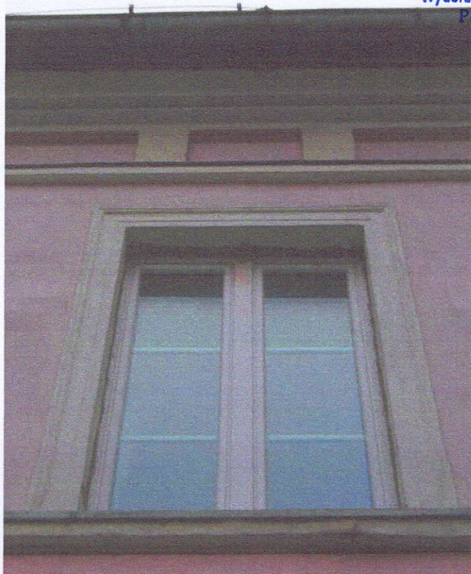
Fot. 18. Fasada, okno piętra z widokiem na ściankę kolankową i gzyms podokapowy
