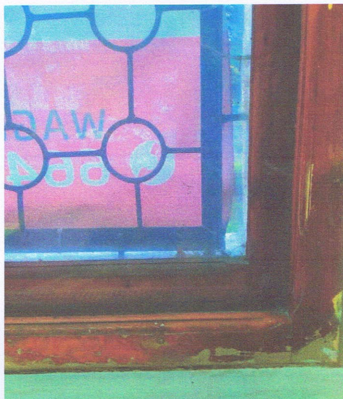
Fot. 24. Okno w elewacji frontowej od strony wewnętrznej – profilowanie ramiaka
