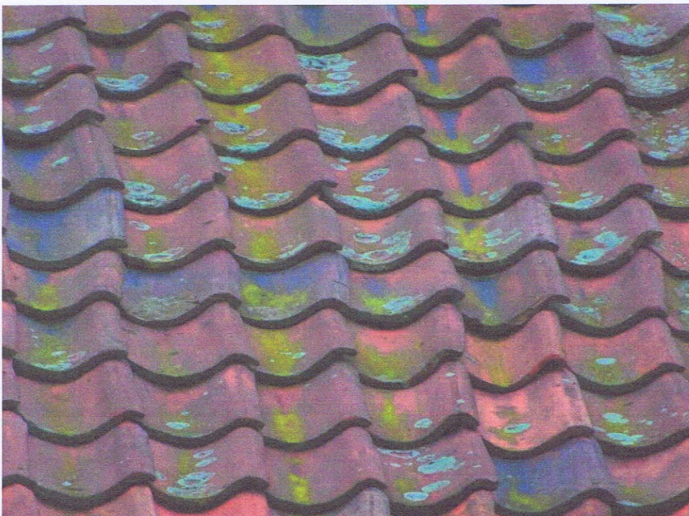
Fot. 35. Elewacja podwórzowa. Dachówki porośnięte glonami i mikroorganizmami, silnie zabrudzone
