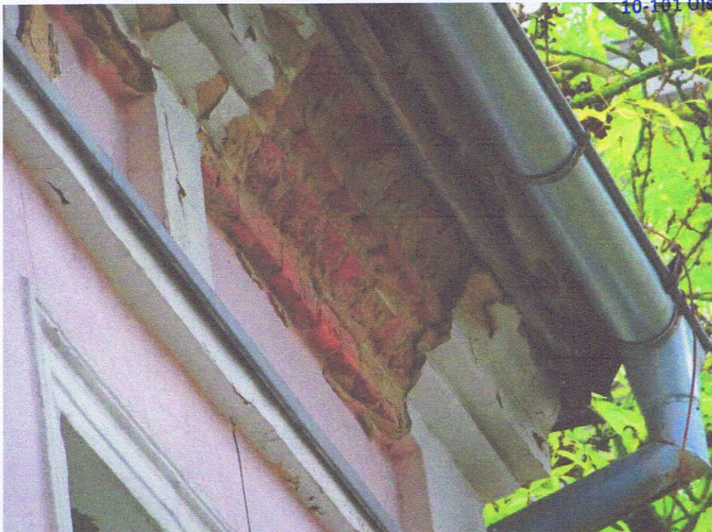
Fot. 20. Fasada, stan zachowania gzymsu podokapowego
