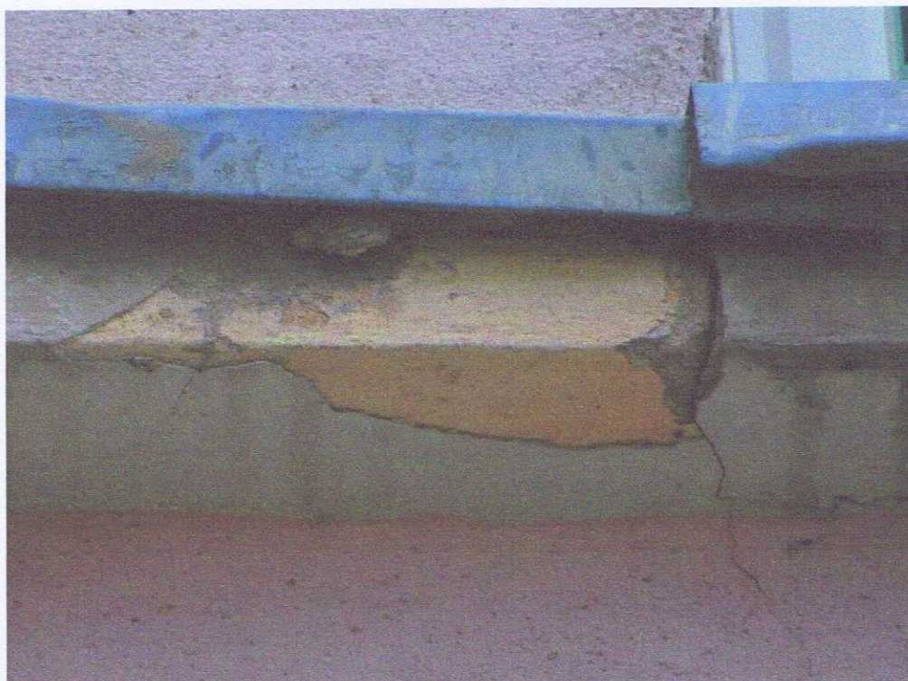
Fot. 31. Elewacja zachodnia. Stan zachowania gzymsu podokiennego/parapetu szczytu. Widoczne wtórne ugrowe przemalowania oraz wcześniejsza biała powłoka malarska
