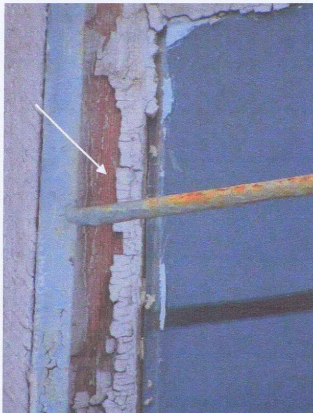
Elewacja podwórzowa. Okno lewego ryzalitu piętra. Ramiak skrzydła okiennego ze śladami oryginalnej, brązowej powłoki malarskiej
