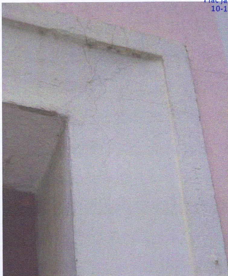
Fot. 16. Wejście główne, fragment opaski. Widoczne spękania tynków
