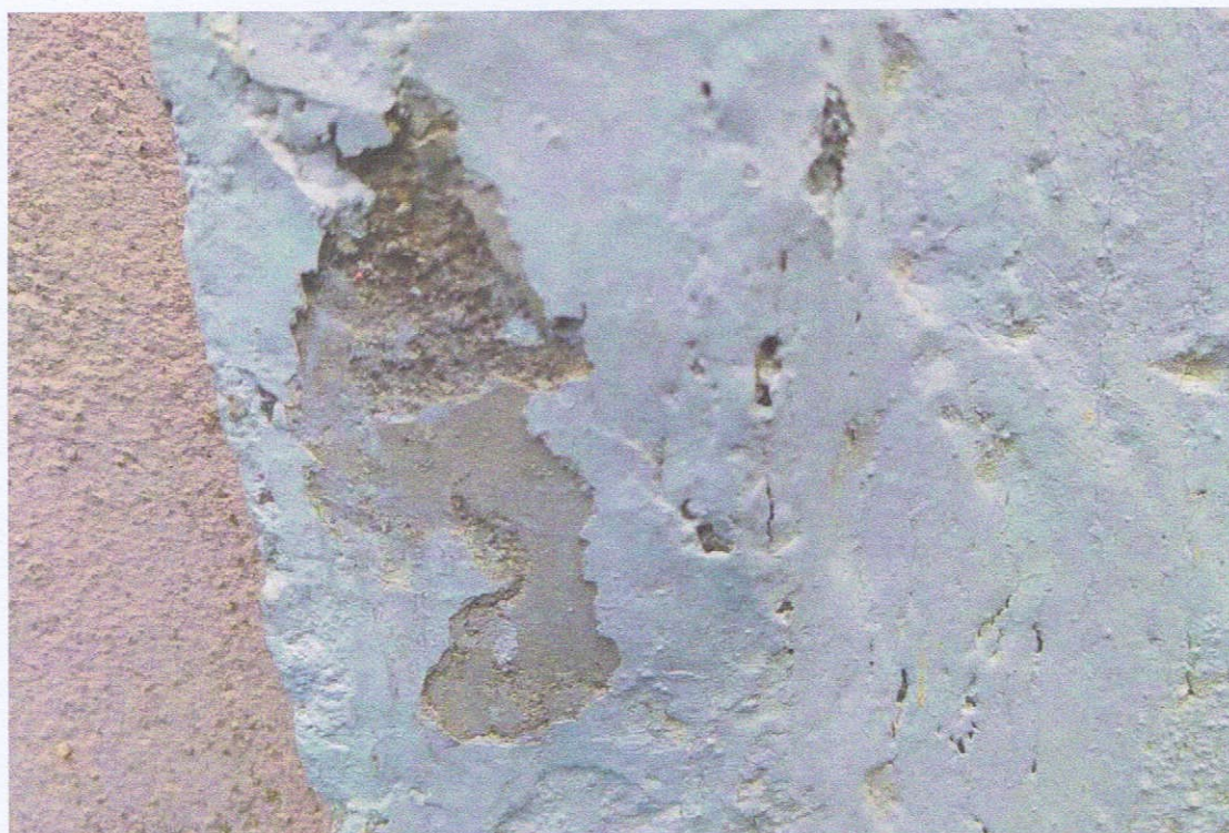
Odkrywka opaski wokół otworu drzwiowego fasady. Na tynku widoczna biała oryginalna powłoka malarska oraz wtórne schodkowe, kolejne powłoki malarskie, w tym popielata
