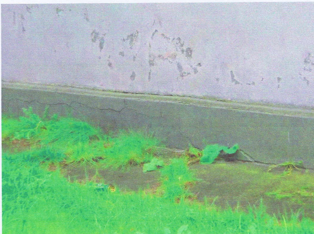
Fot. 6. Elewacja wschodnia. Partia cokołowa. Widoczne spękania oraz zawilgocenie i destrukcja tynków i powłok malarskich powyżej cokołu
