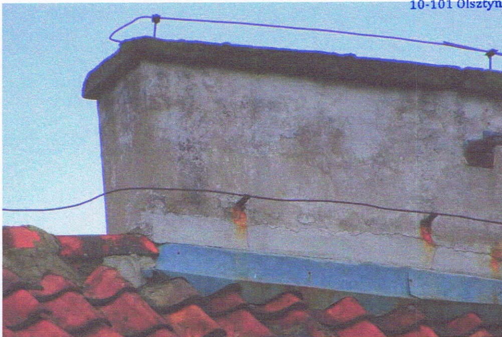
Fot. 36. Komin od strony podwórzowej. Widoczne zniszczenia tynków, silne zabrudzenia korony komina
