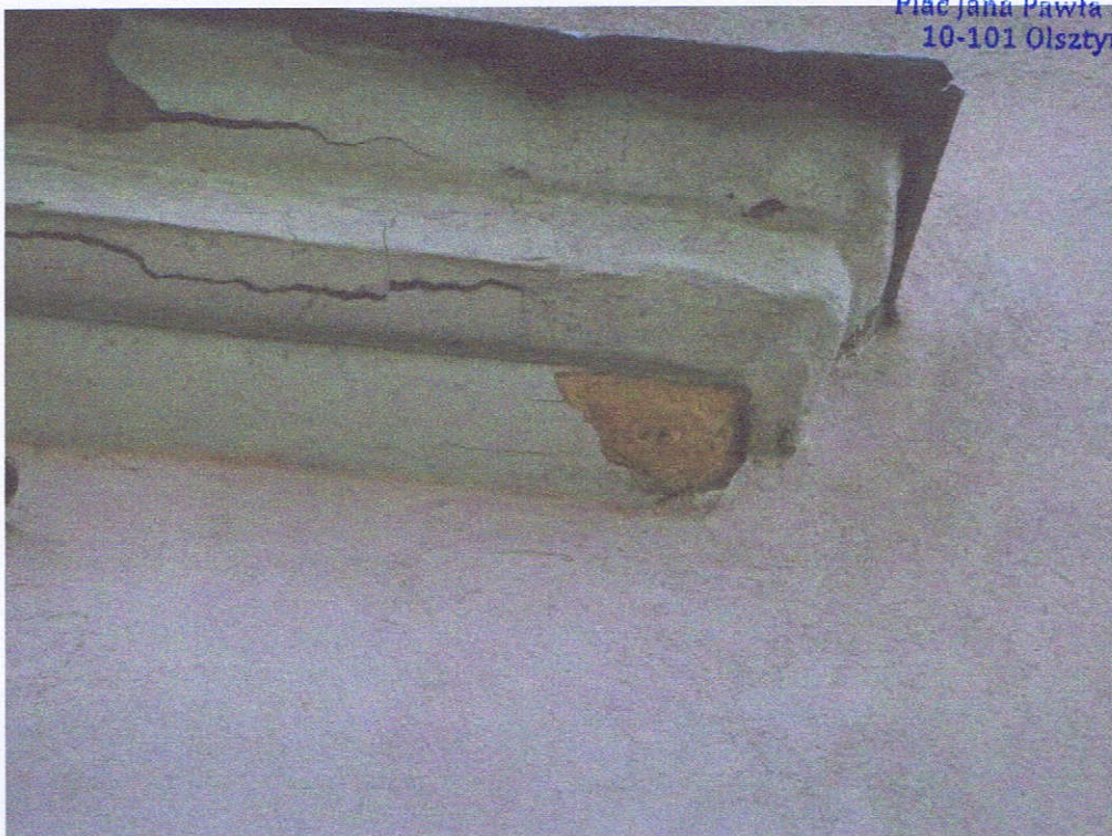
Fot. 30. Elewacja zachodnia. Stan zachowania gzymsu podokiennego/parapetu piętra
