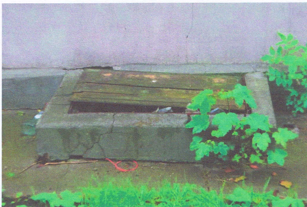
Fot. 7. Elewacja wschodnia. Spękane obramowanie studzienki okna piwnicy, wylewki cementowej i tynki elewacji
