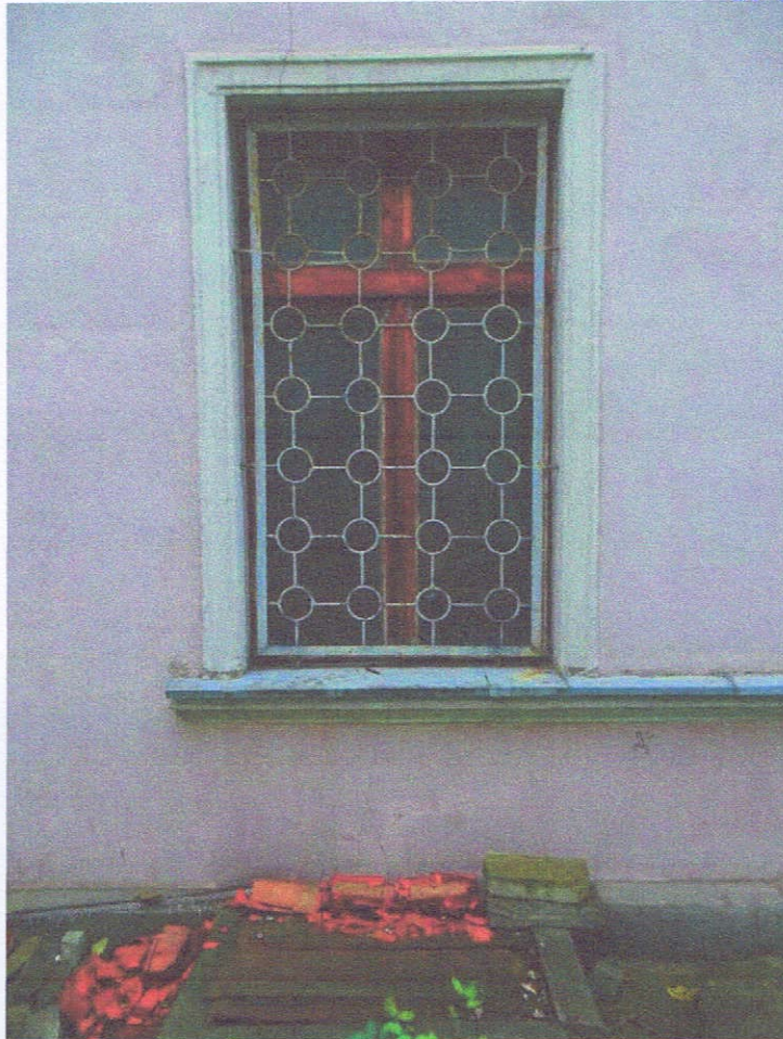
Fot. 9. Elewacja wschodnia. Spękane tynki elewacji i detalu nadproża okna. Widoczne profilowanie gzymsu/parapetu w poziomie ławy okiennej
