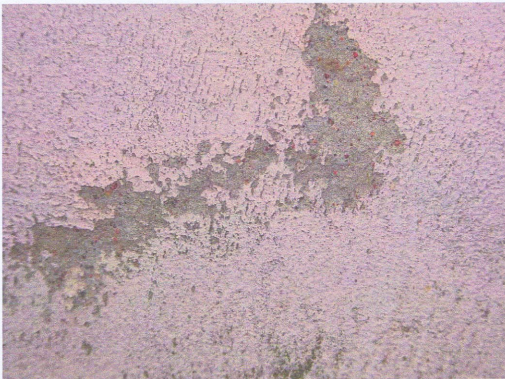
Fot. 11. Elewacja wschodnia. Postępująca degradacja tynków cementowych
