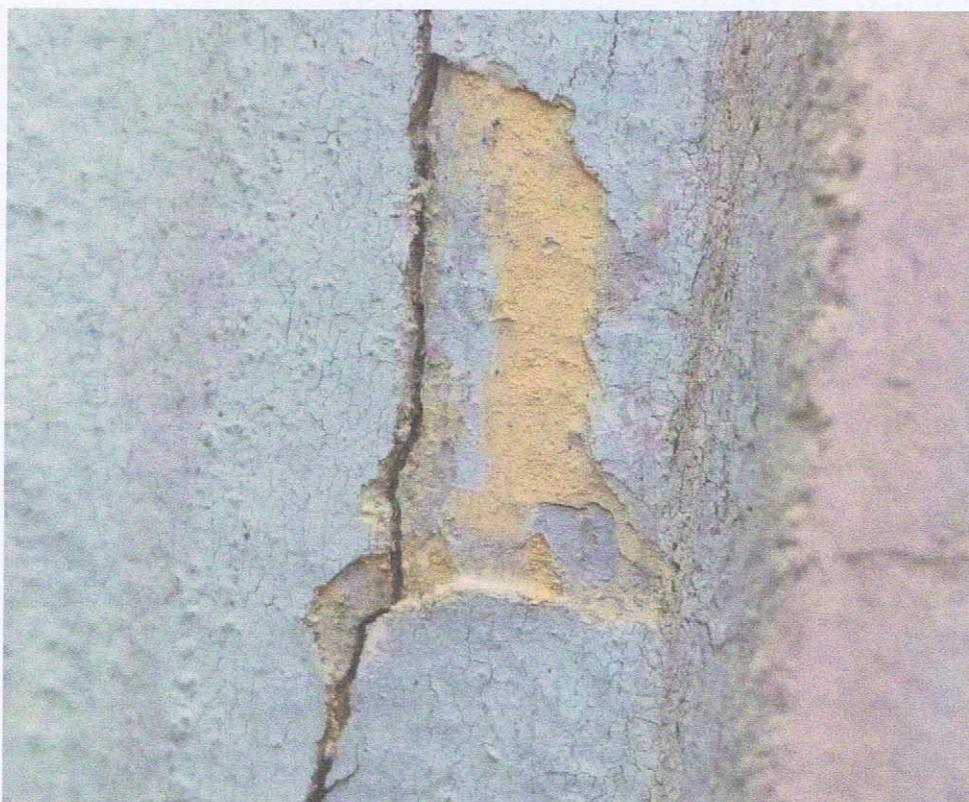
Odkrywka opaski okna 01. Na tynku widoczna biała oryginalna powłoka malarska oraz wtórne schodkowe, kolejne powłoki malarskie widoczne w próbce mikroskopowej
