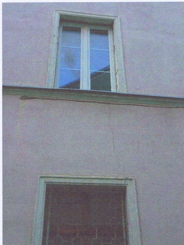
Fot. 27. Elewacja zachodnia. Widoczne pęknięcia tynku
