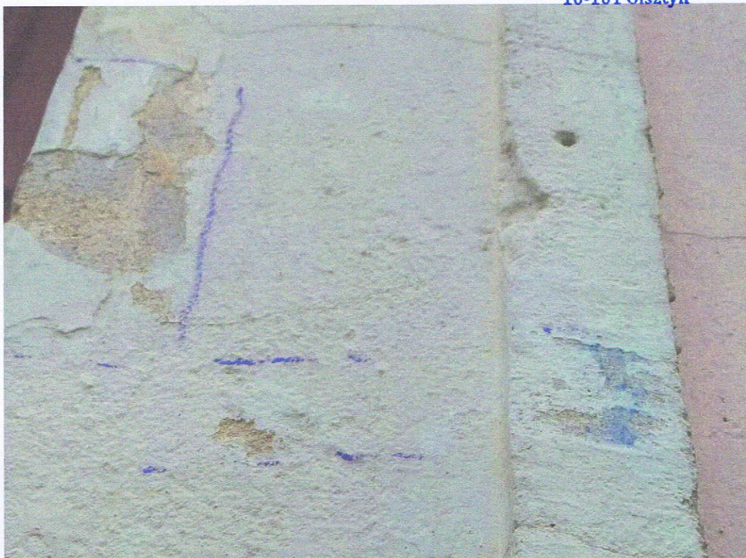
Odkrywka opaski wokół otworu drzwiowego fasady. Na tynku widoczna biała oryginalna powłoka malarska oraz wtórne schodkowe, kolejne powłoki malarskie widoczne w próbce mikroskopowej, w tym kobaltowej
