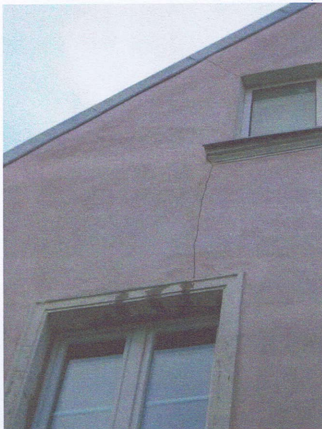
Fot. 28. Elewacja zachodnia. Widoczne spękania tynków i nadproży okiennych
