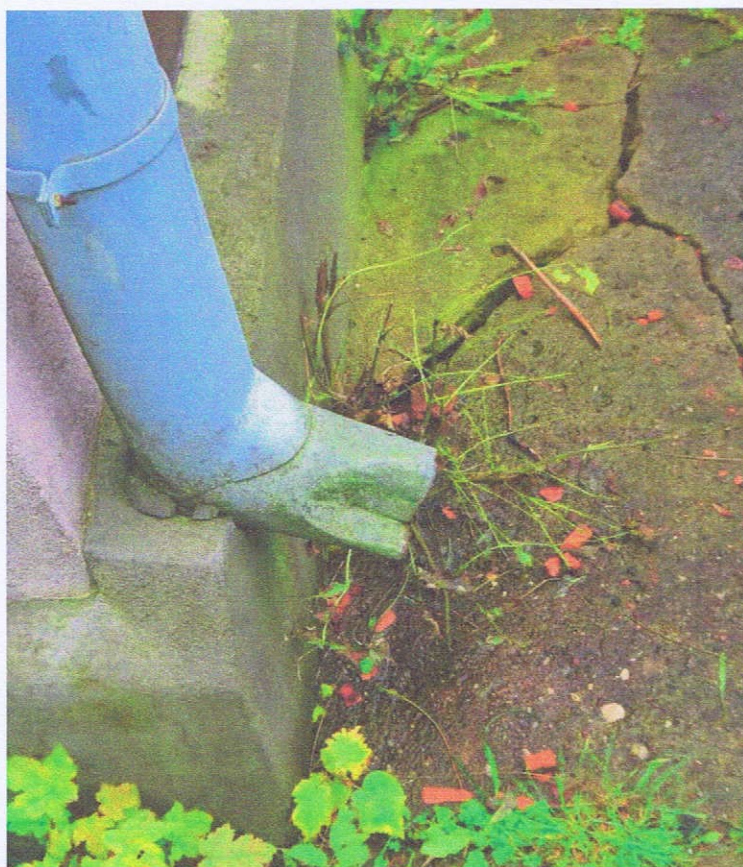
Fot. 25. Narożnik północno-wschodni od strony elewacji frontowej. Odprowadzenie rury spustowej. Widoczne glony na spękanej opasce przy budynku oraz samosiewy drzew i traw
