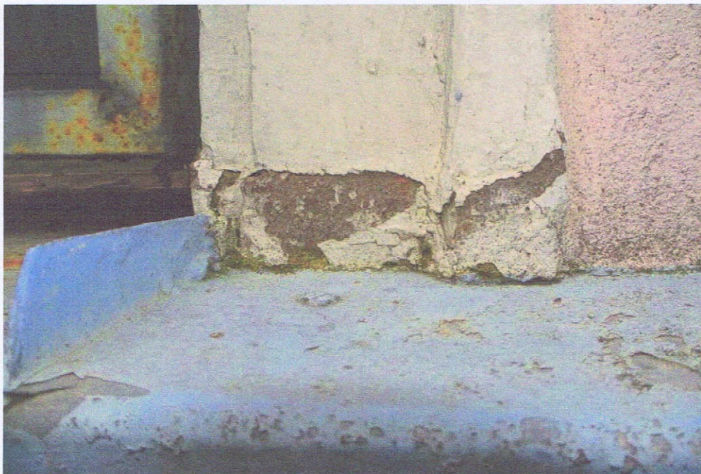
Fot. 9. Elewacja wschodnia. Stan zachowania opasek okiennych parteru
