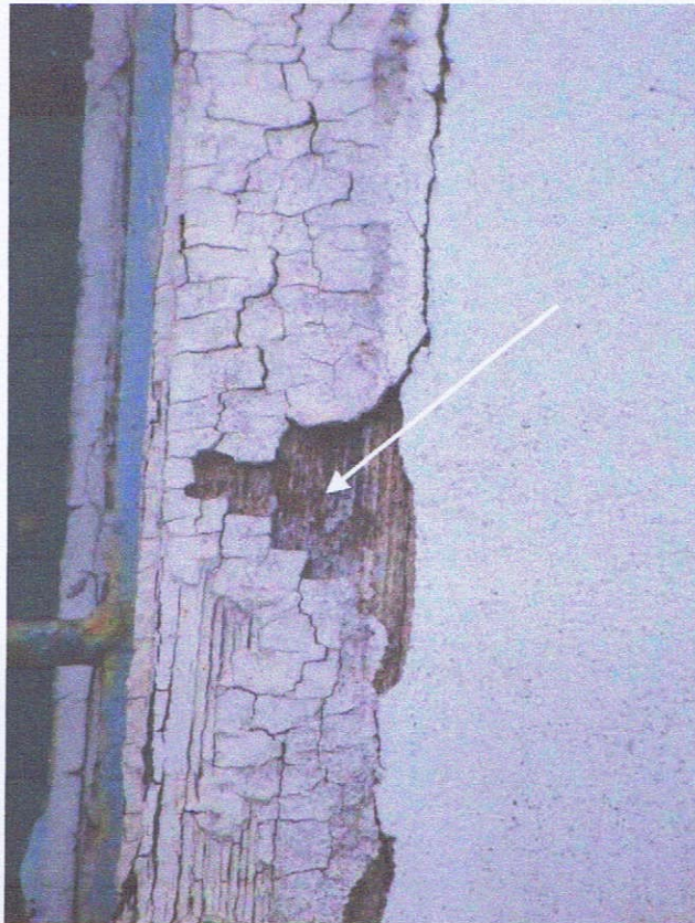
Elewacja podwórzowa. Oboknie ze śladami oryginalnej, brązowej powłoki malarskiej
