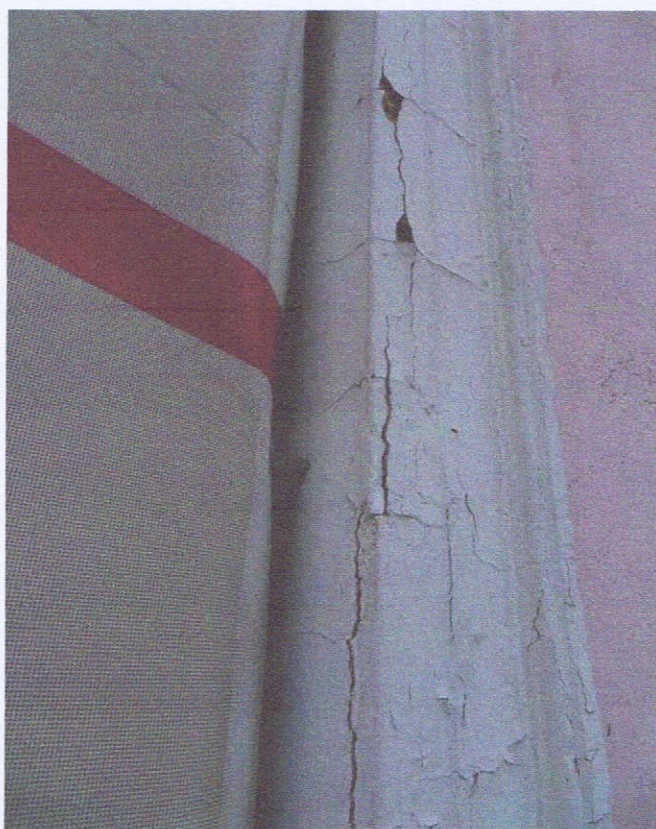
Fot. 19. Fasada, stan zachowania opaski okiennej parteru
