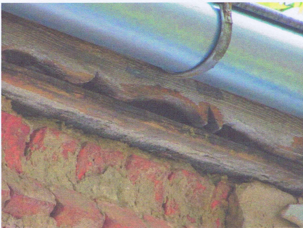
Fot. 21. Fasada, wróblownica nad gzymsem podokapowym
