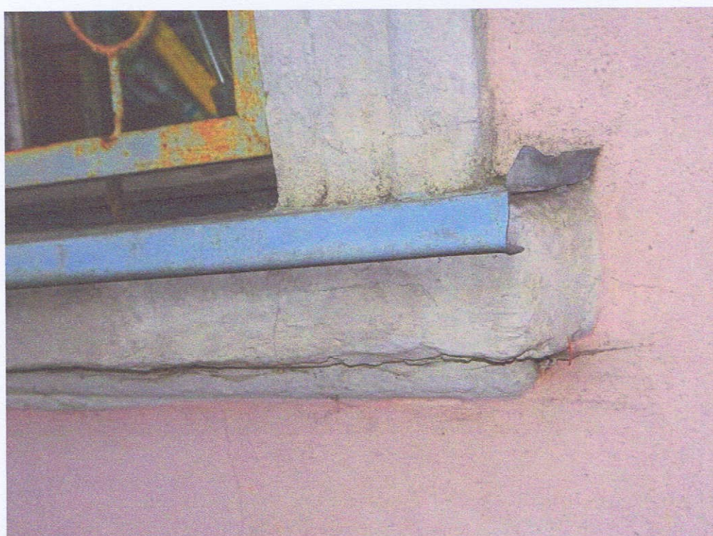
Fot. 17. Fasada, zatarte oryginalne profilowanie gzymsów/parapetów podokiennych
