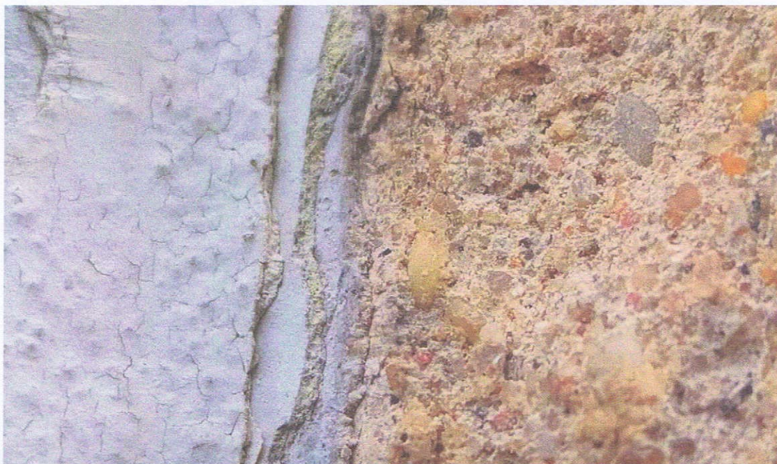
Odkrywka opaski okna 02. Na tynku widoczna biała oryginalna powłoka malarska oraz wtórne schodkowe, kolejne powłoki malarskie widoczne w próbce mikroskopowej
