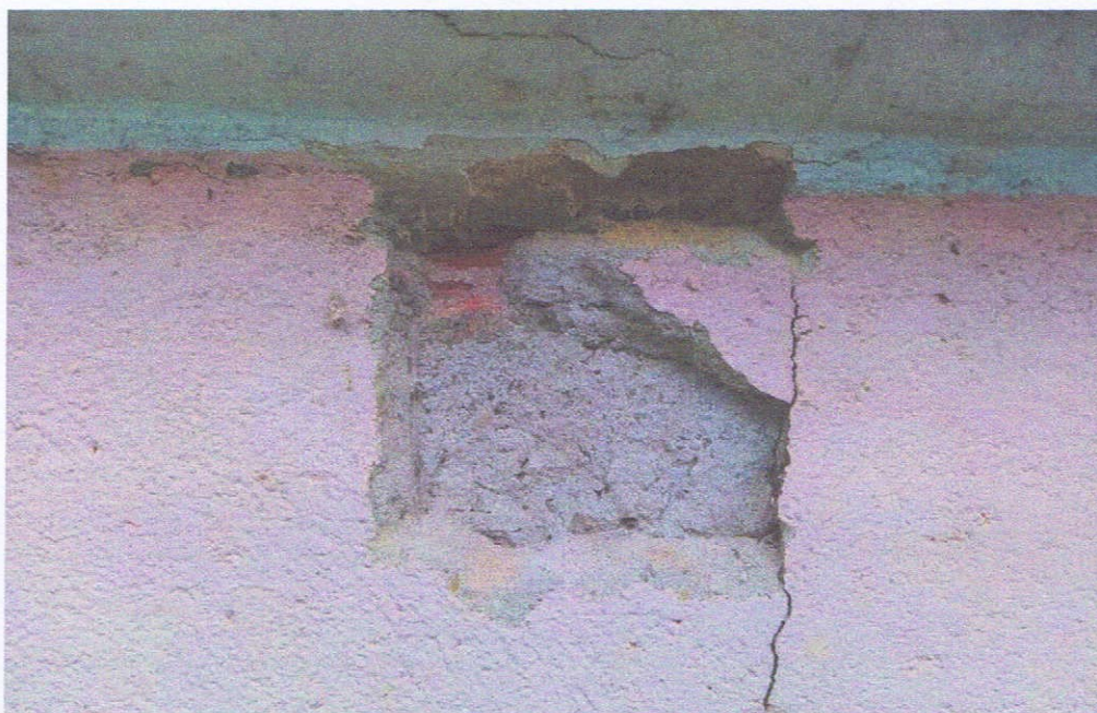
Fasada. Odkrywka współczesnego tynku sięgającego muru ceglanego. Brak oryginalnych tynków wapienno-piaskowych.
