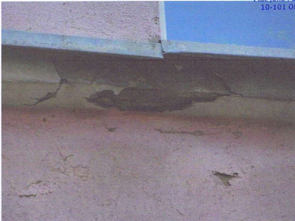
Fot. 32. Elewacja zachodnia. Stan zachowania gzymsu podokiennego/parapetu szczytu
