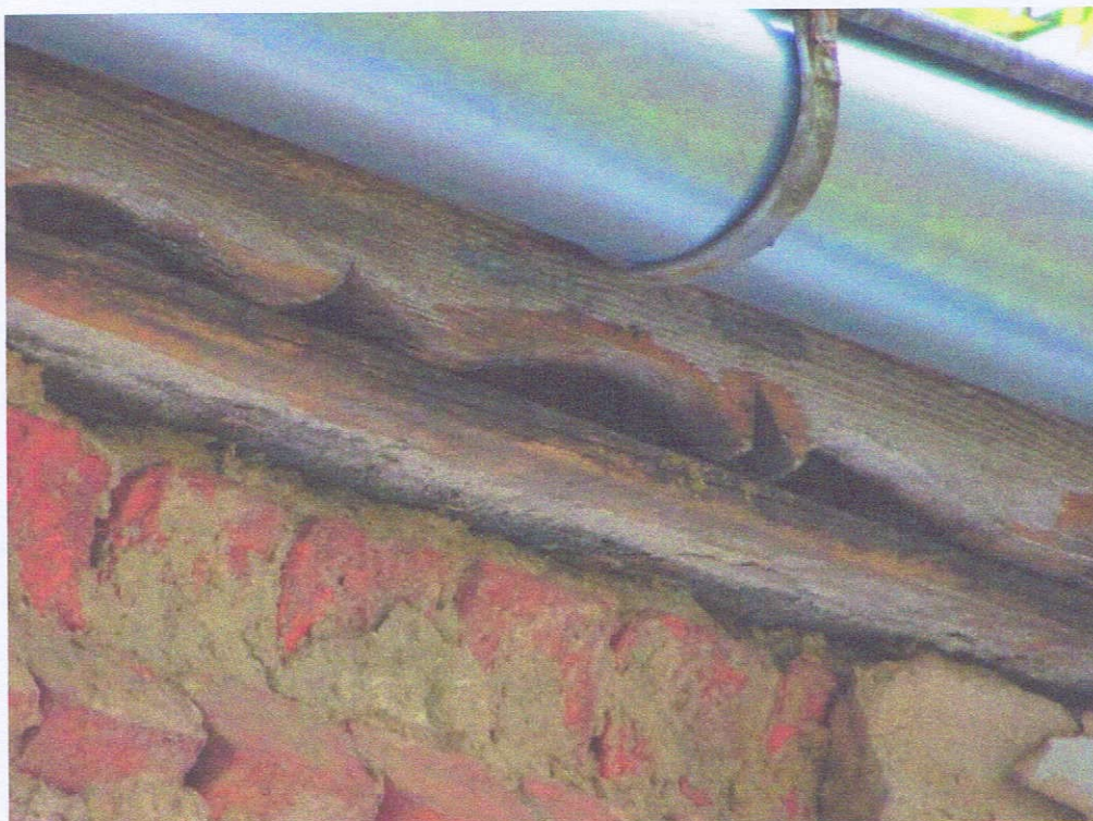
Wróblownica i deska podokapowa malowane w kolorze białym. Widoczne ciemne plamy korozji biologicznej drewna.
