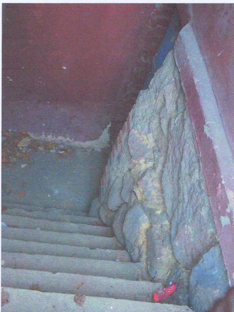
Fot. 43. Elewacja podwórzowa, wejście do piwnicy. Widoczne fundamenty ryzalitu wschodniego
