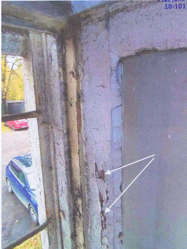
Okno elewacji podwórzowej od strony wnętrza – relikty oryginalnej powłoki malarskiej na ramiaku skrzydła okiennego
