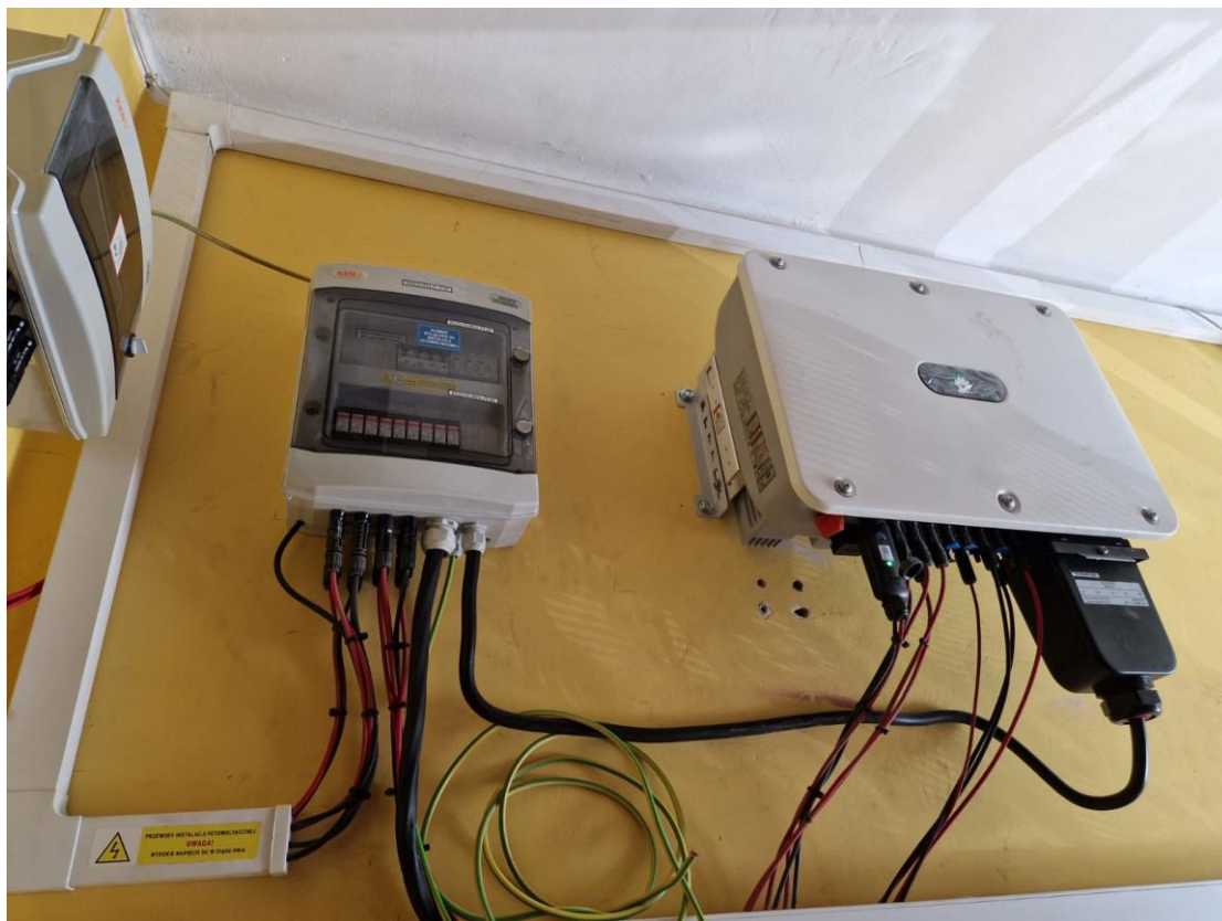
Fotografia 4. Falownik wraz z zabezpieczeniami istniejącej instalacji fotowoltaicznej
