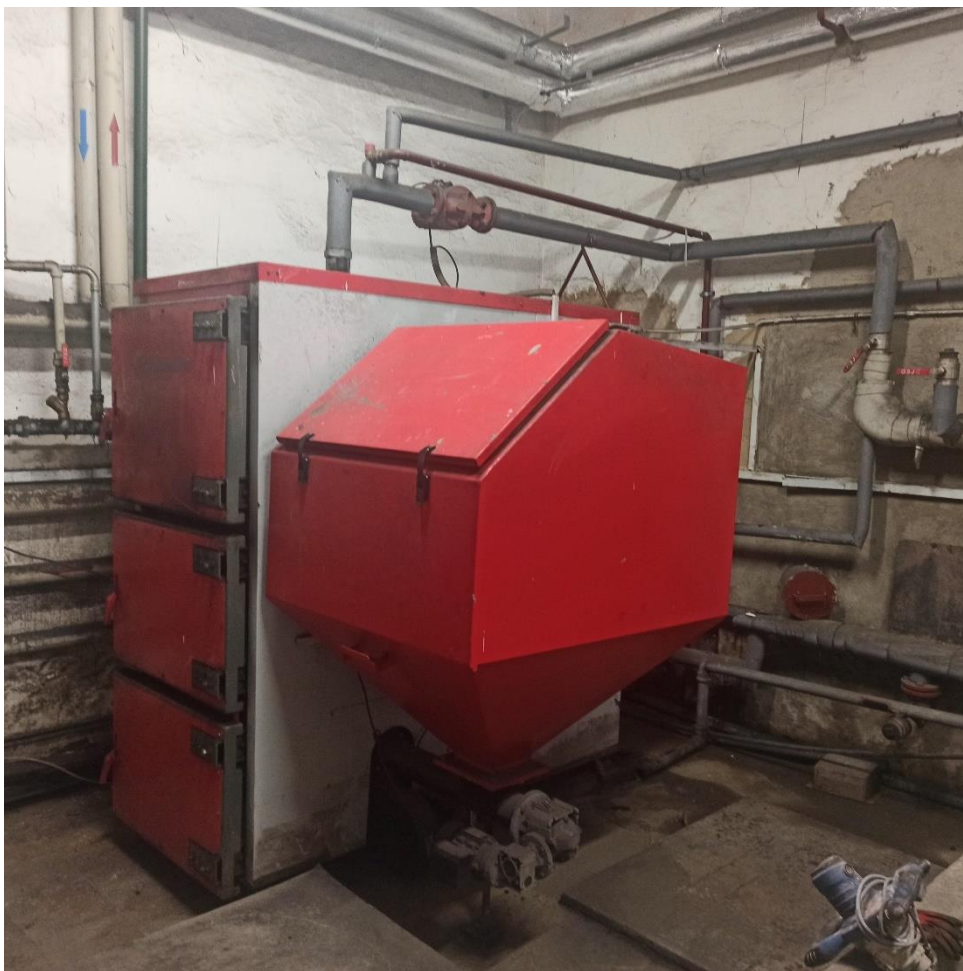
Fotografia 7. Istniejący kocioł węglowy – pozostaje jako źródło szczytowe
