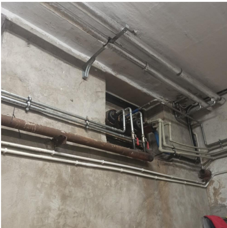
Fotografia 8. Proponowane miejsce wpięcia nowej instalacji pomp ciepła
