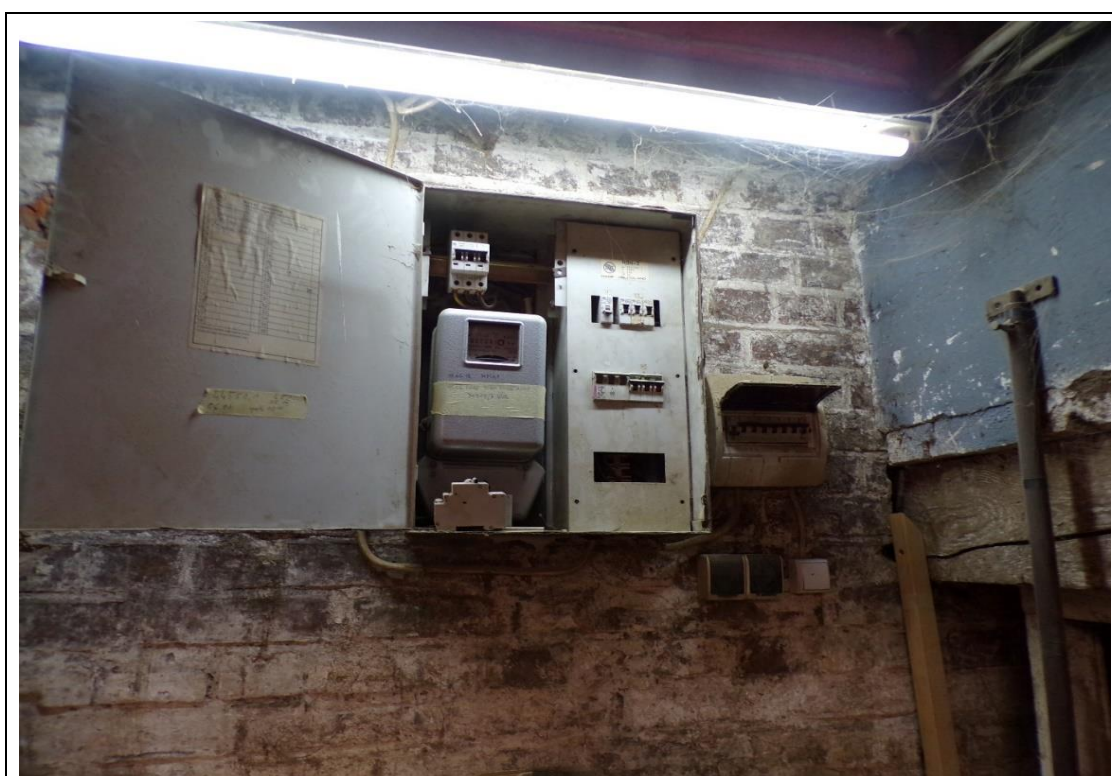
Foto. 40. Obiekt 2 E – tablica rozdzielcza z podlicznikiem energii
