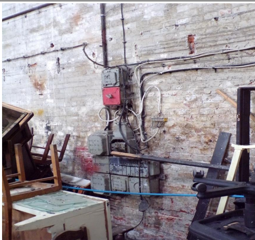
Foto. 37. Obiekt 2 A – część rozdzielcza instalacji elektrycznej z „nową” częścią czynną
