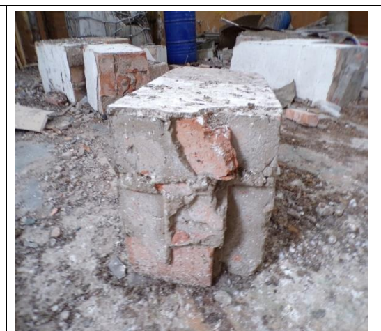
Foto. 19. Obiekt 2 B – zniszczony słup podporowy kondygnacji piętra 1
