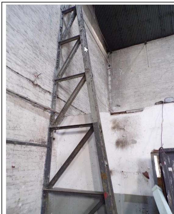
Foto. 16. Obiekt 2 A – przypora stalowa ściany zewnętrznej
