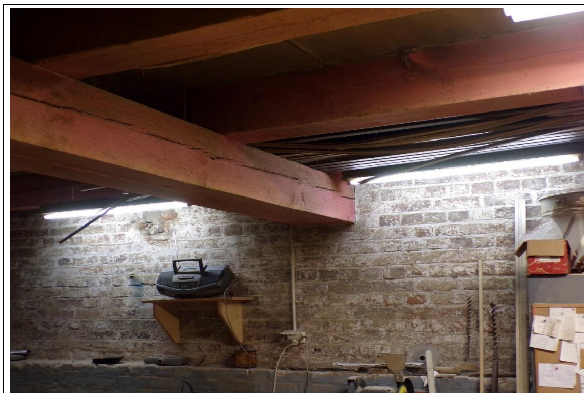
Foto. 29. Obiekt 2 E – ściana ceglana, strop drewniany bez sufitu
