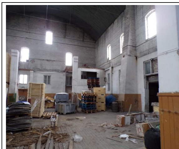
Foto. 18. Obiekt 2 B – Widoczne słupy nie istniejącej kondygnacji piętra 1
