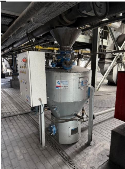
Fot. 1 Pompa pneumatyczna transportowa MET-TECH typ PTP 400/0,4
