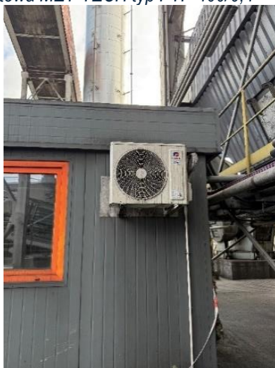
Fot. 2 Klimatyzator pomieszczenia szaf elektrycznych
