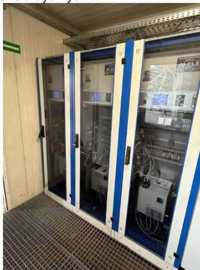
Fot. 3 Analizatory spalin GASBOARD typ 3000PLUS
