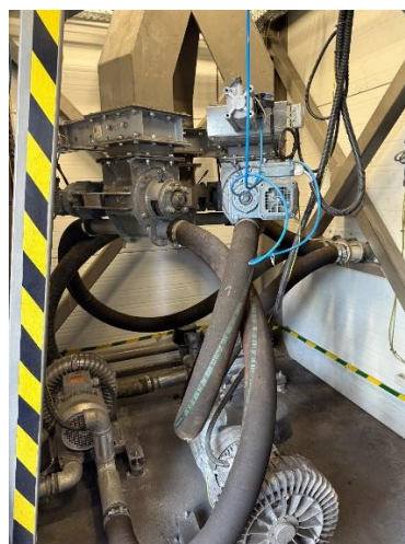
Fot. 6 Wentylatory podawania sorbentu PNEUMAT typ SC701MF
