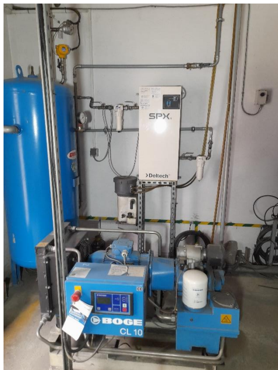
Sprężarki BOGE i osuszacz Deltech HF 36
