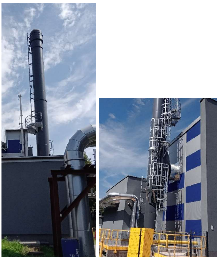
9.3. Komin stalowy w ciepłowni ZR4:
