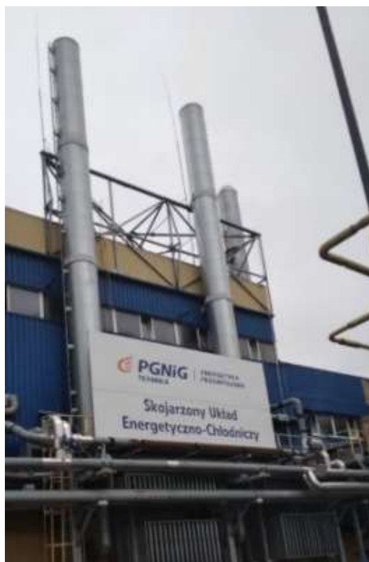
3.3. Kominy jednopłaszczyznowe silnika gazowego TCG nr 1 i TCG nr 2 rejon SUECh:
