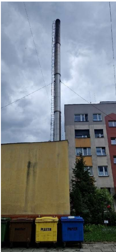
7.4. Kominny stalowe zamocowane do wspólnej konstrukcji nośnej (masztu) wolnostojącej (3 szt.):
