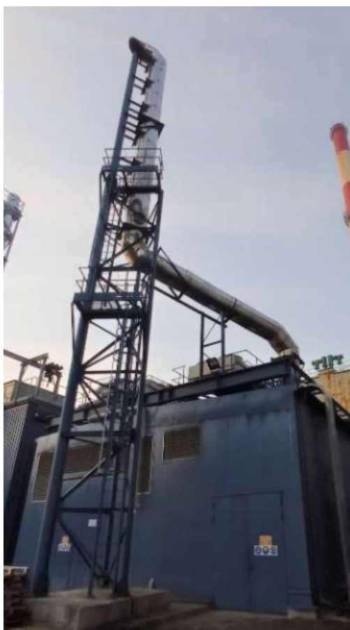
2.3. Komin stalowy silnika nr 2:
