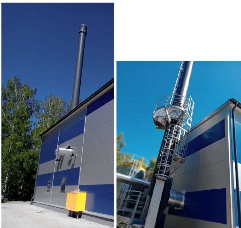
9.3. Komin stalowy w ciepłowni ZR4:
