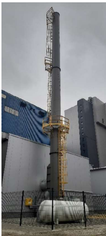
1.4. Komin wolnostojący stalowy kotła KGO-2:
