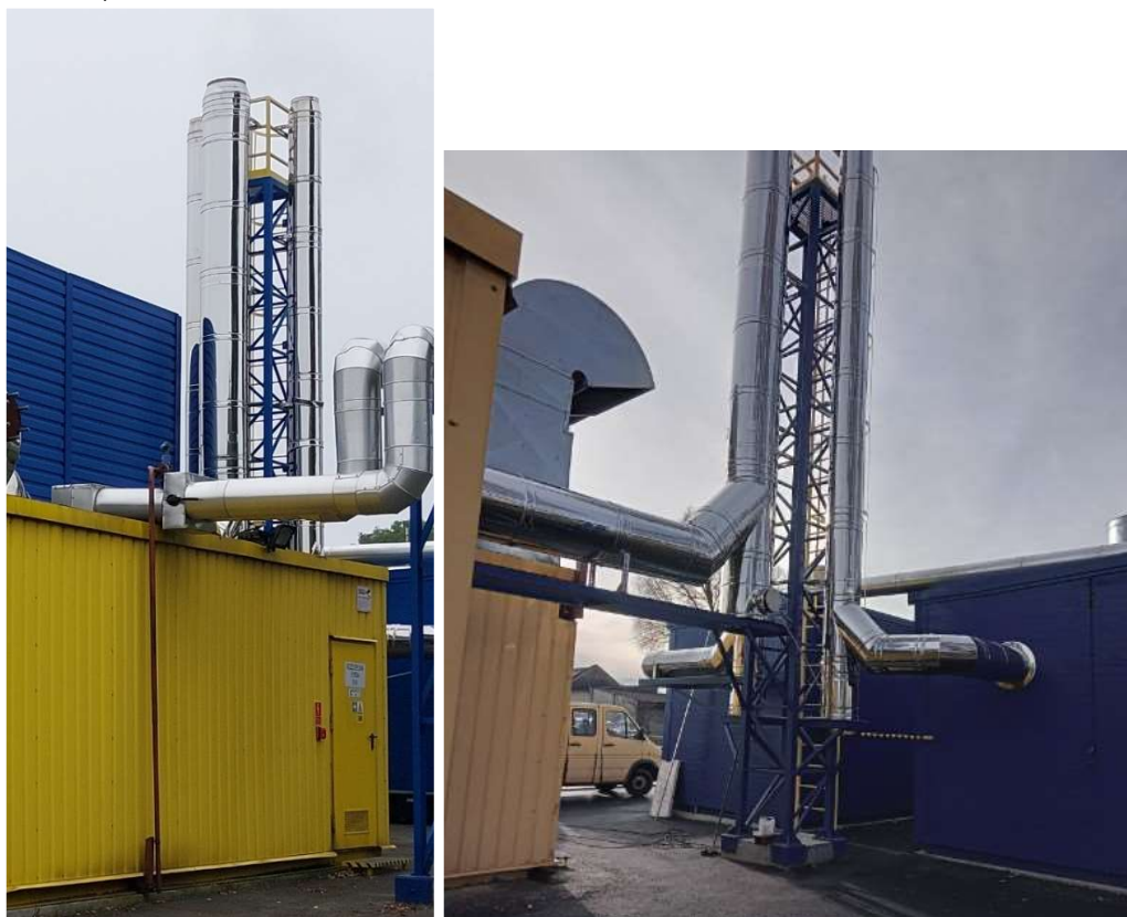
7.4. Kominny stalowe zamocowane do wspólnej konstrukcji nośnej (masztu) wolnostojącej (3 szt.):
