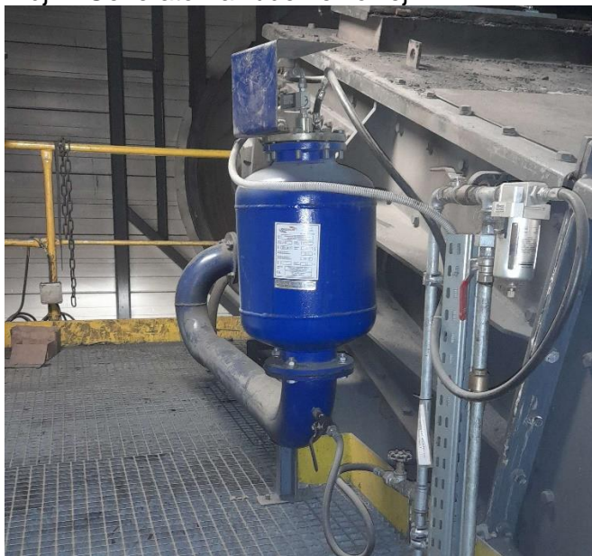
Zdj. 2 Generator fali uderzeniowej na przesypie węgla
