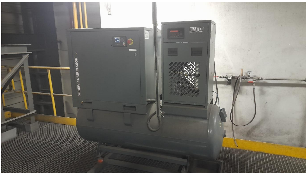
Zdj. 3 Sprężarka śrubowa WALTER SKTG 7,5 P nr ser. 2270125 zabudowana na poziomie 22,5m + osuszacz chłodniczy z wbudowanymi filtrami WALTER WDF 100
