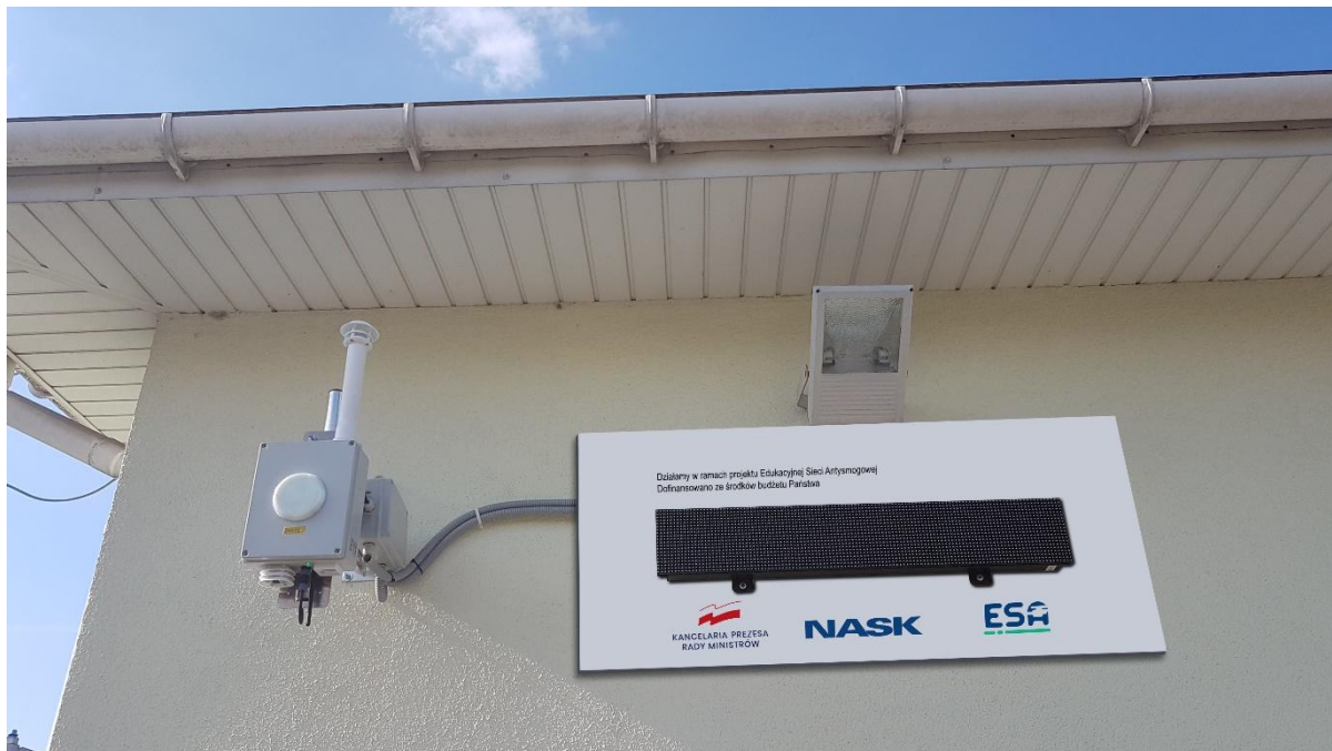
Rysunek 1. Schemat instalacyjny tablicy informacyjnej – preferowana wersja
