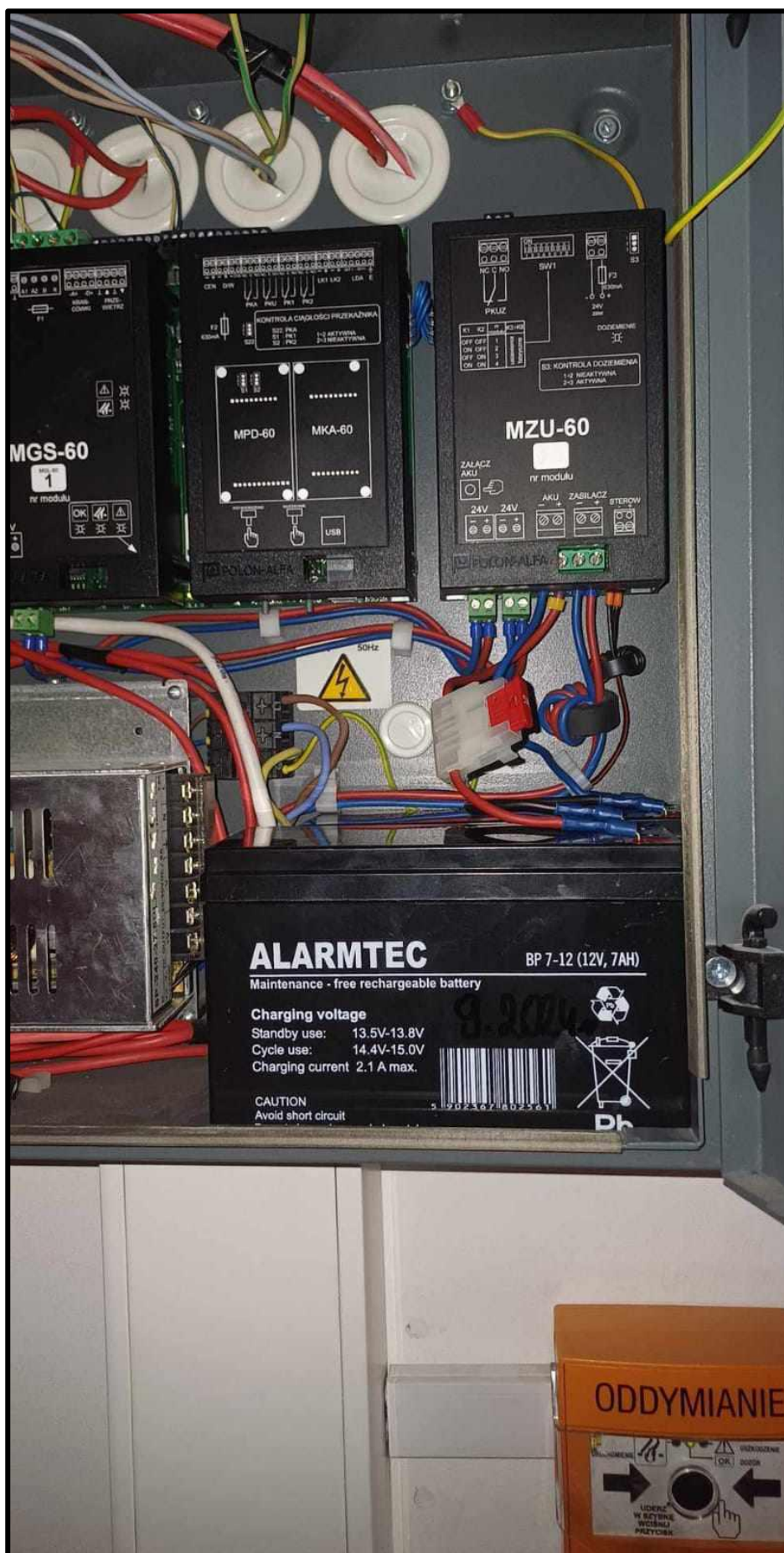
Wymieniono akumulatory w centrali UCS na nowe.
