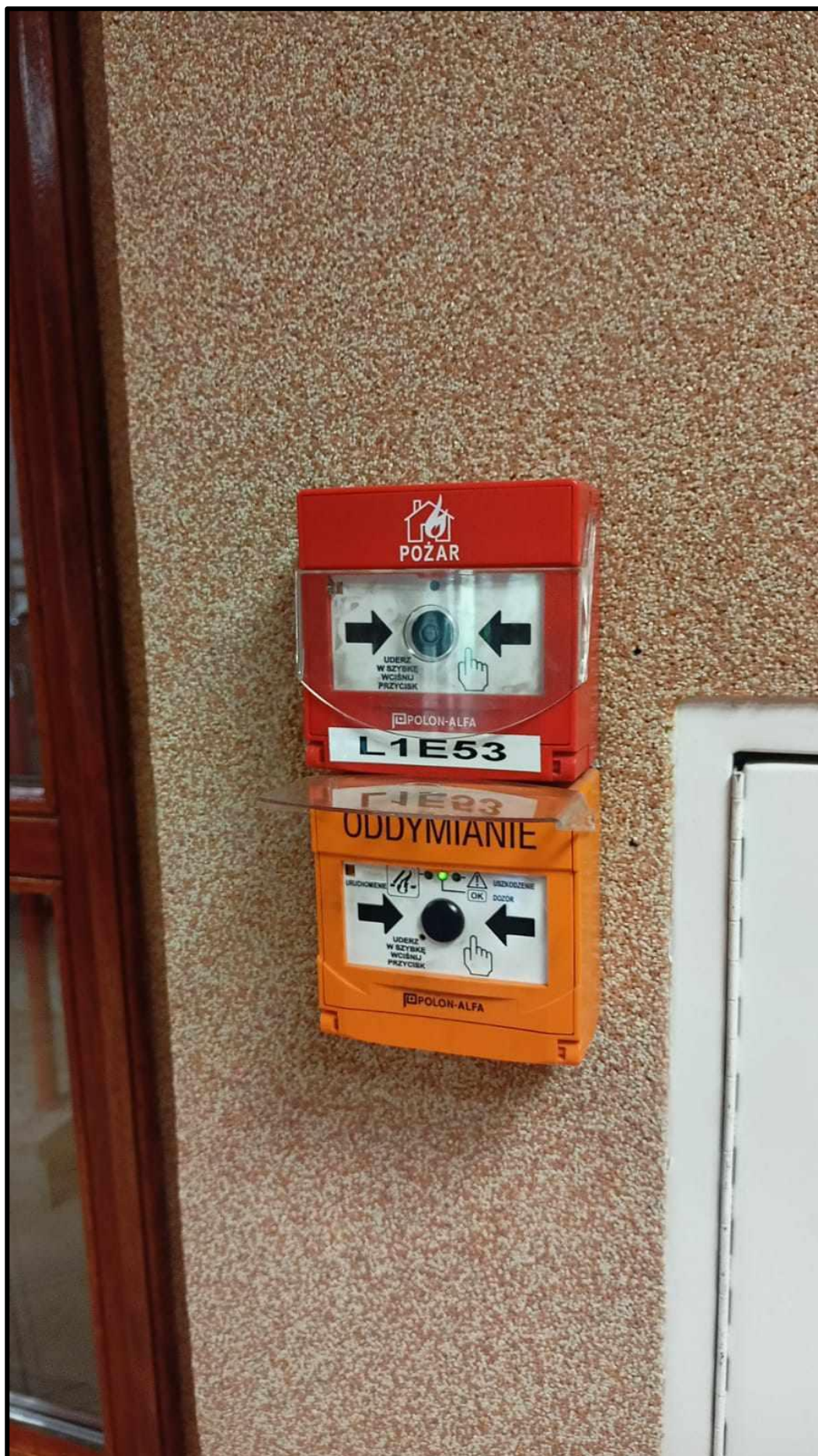
Źle zamontowany przycisk ROP – Brak możliwości resetu przycisku.
