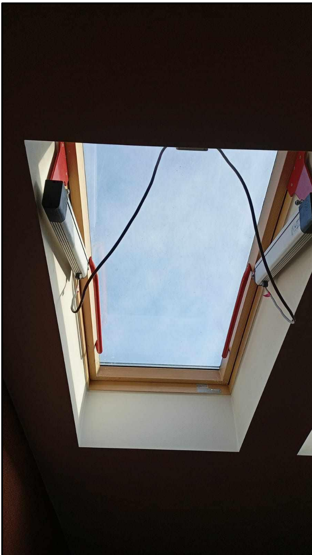
Okna dymowe zamontowane na klatce.
