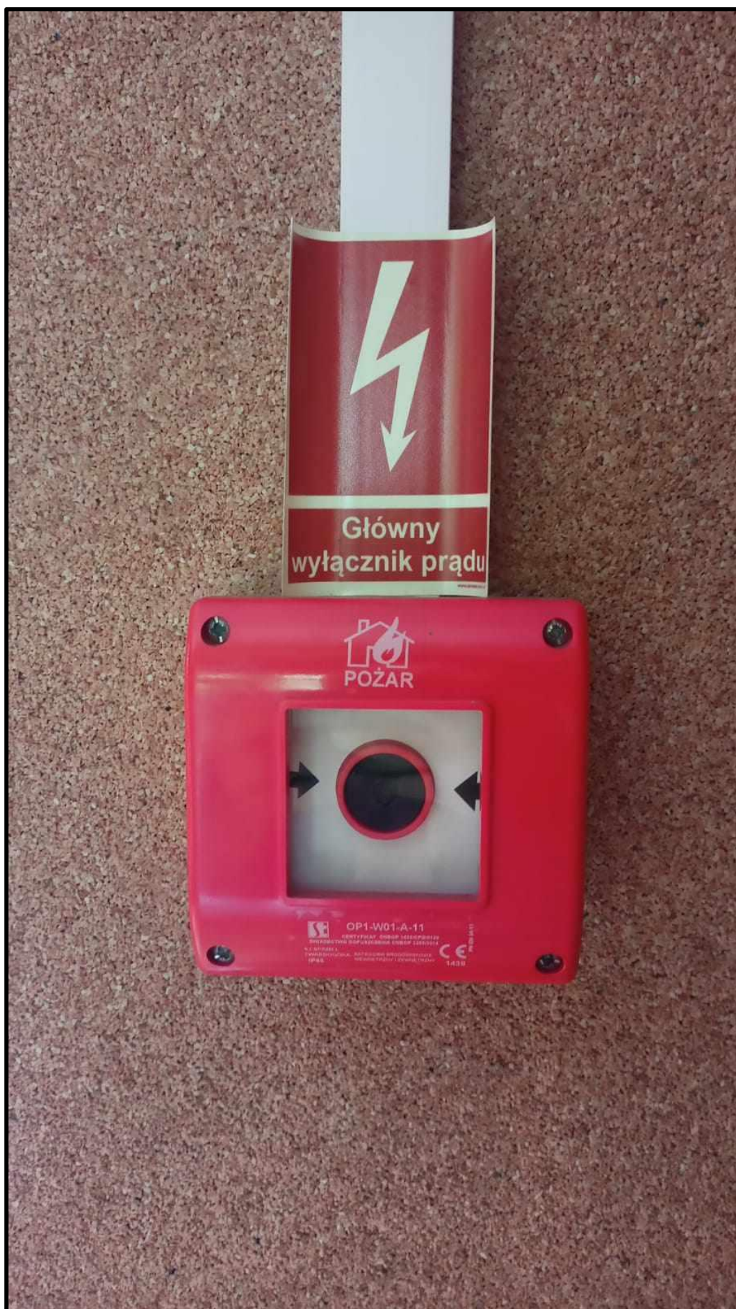
Przeciwpowozarowy wyłacznik prądu.
