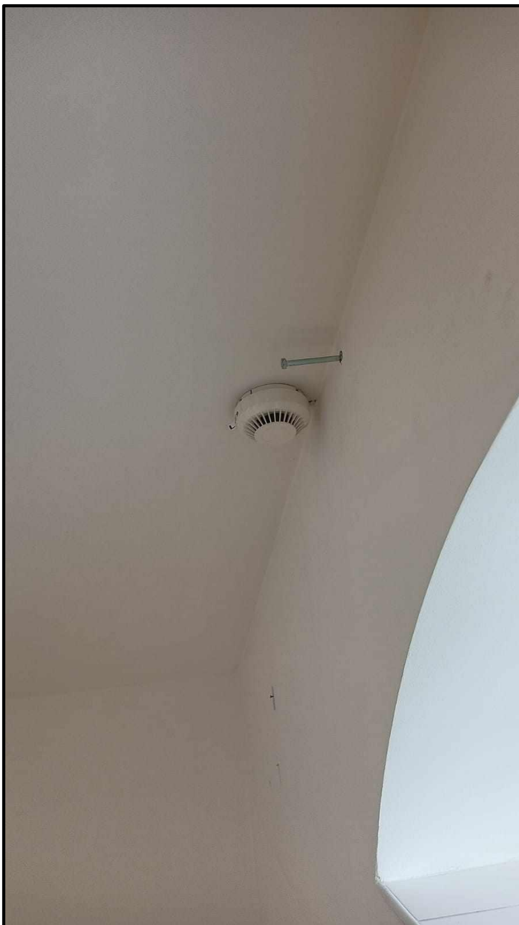
Czujka zamontowana przy samej ścianie.
