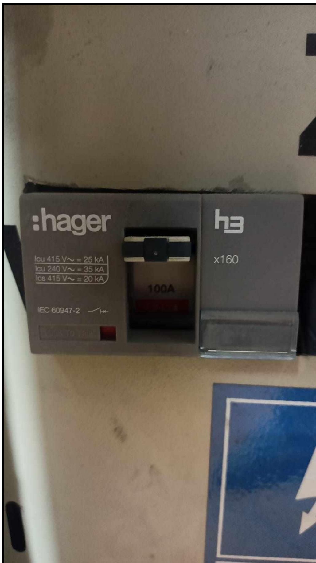
Rozłącznik znajdujący się w rozdzielni na parterze.
