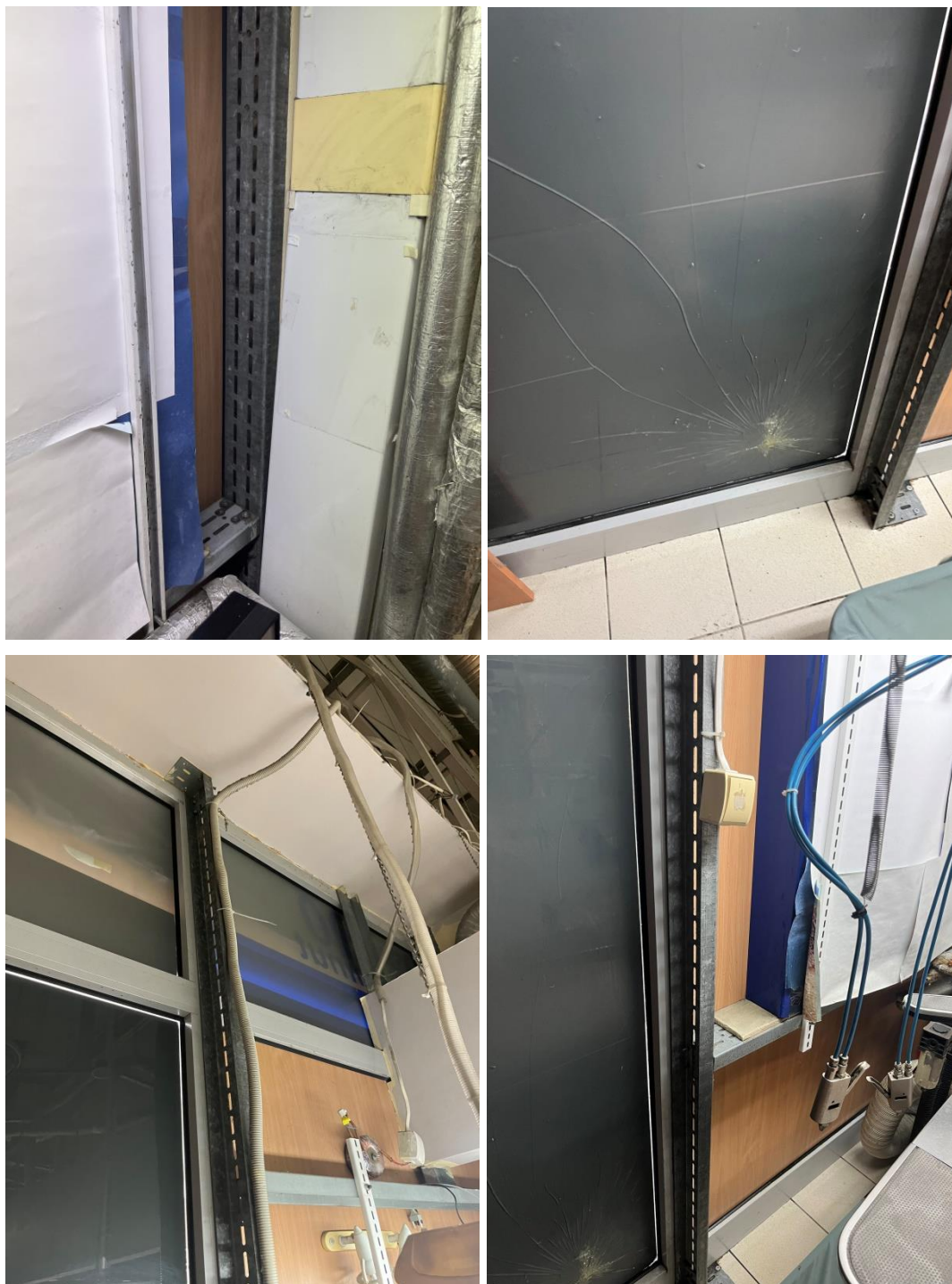
Fot.3 Podkonstrukcja z profili UA
