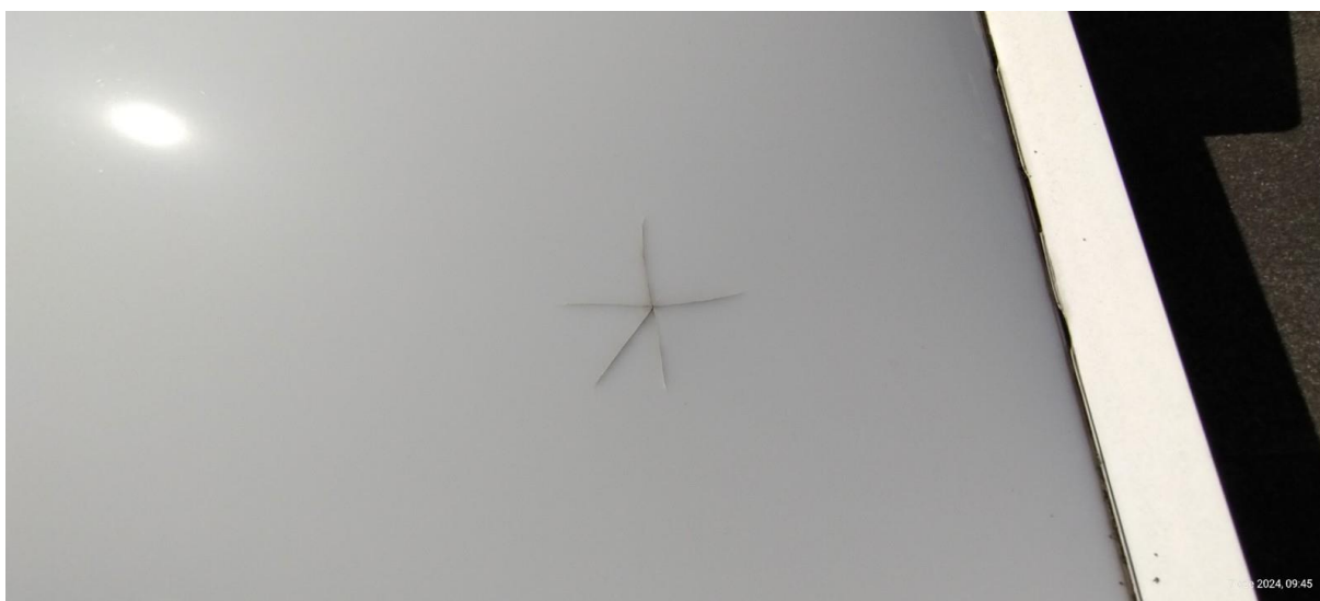
Zdjęcie nr 1 Uszkodzenie klapy dymowej Essmann Firelux F6 150/250.
