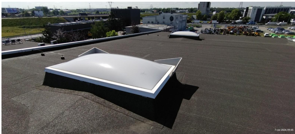
Zdjęcie nr 2 Uszkodzenie klapy dymowej Essmann Firelux F6 150/250.
