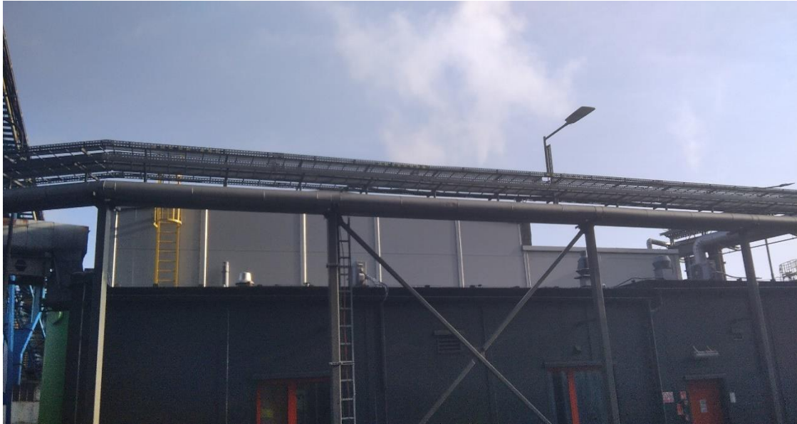
Zdjęcie nr 1 Estakada technologiczna zlokalizowana w rejonie planowanej trasy gazociągu DN 150
