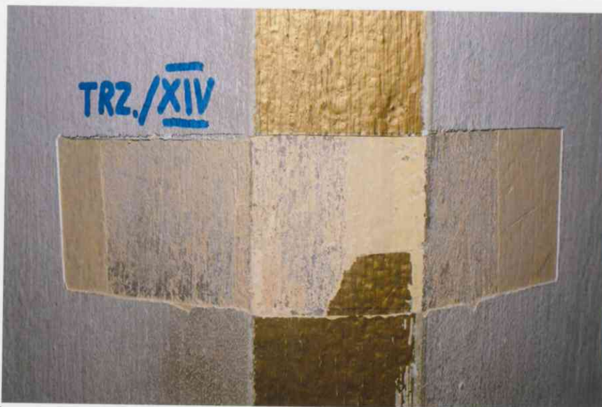
Fot. 10. Nawa główna – filar wspierający empore, widoczna odkrywka sondażowa do badań konserwatorskich. Przemalowana monochromatyczna warstwa malarska. Fotografia z 2024r.
