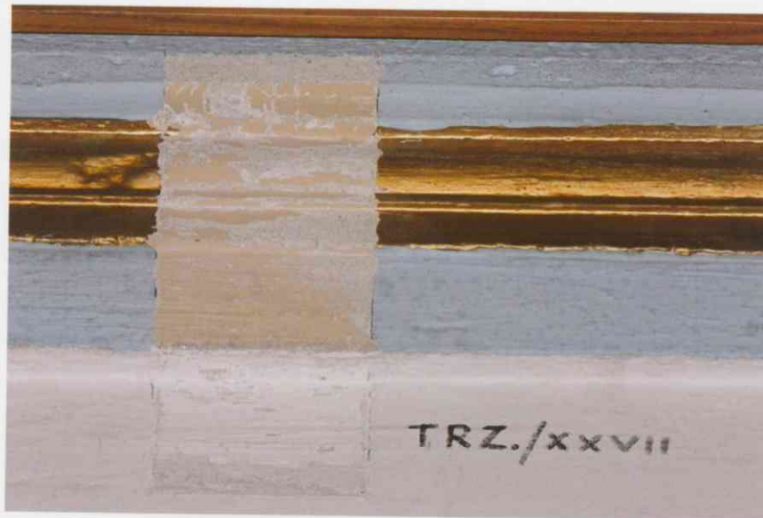
Fot. 9. Nawa główna – gzyms kordonowy nad ścianą, widoczna odkrywka sondażowa do badań konserwatorskich. Przemalowana monochromatyczna warstwa malarska. Fotografia z 2024r.
