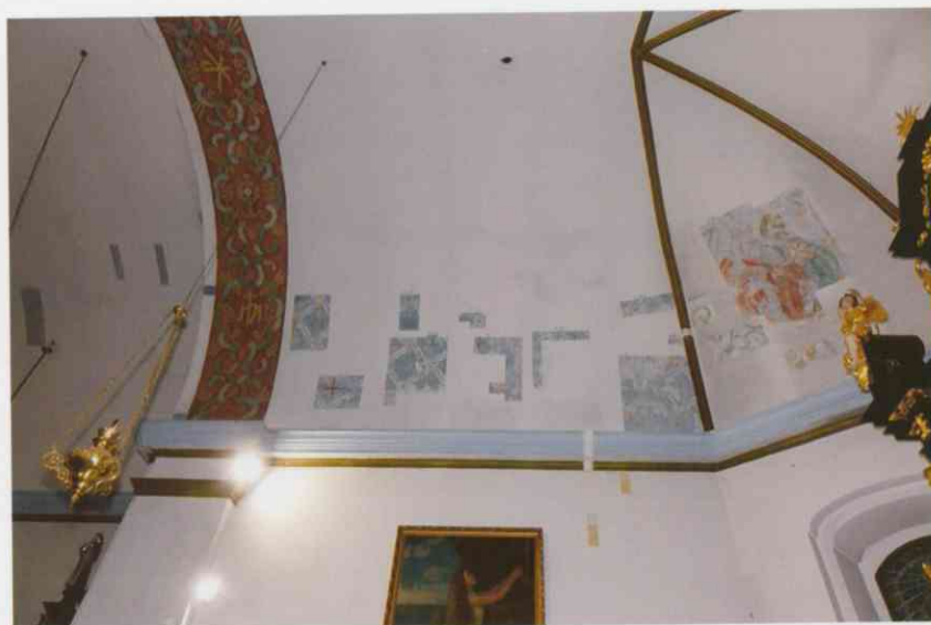
Fot. 4. Prezbiterium, widoczne odkrywki sondażowe w trakcie wykonywania badań konserwatorskich i określaniu stratygrafii nawarstwień. Fotografia z 2024r.
