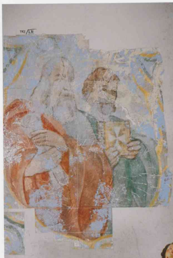
Fot. 6. Prezbiterium - sklepienie, widoczna duża odkrywka wykonana w trakcie badań konserwatorskich. Spękany i odspojony tynk z polichromią. Fotografia z 2024r.
