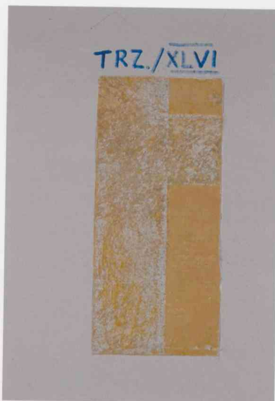
Fot. 8. Prezbiterium - ściana, widoczna odkrywka sondażowa do badań konserwatorskich. Przemalowana monochromatyczna warstwa malarska. Fotografia z 2024r.
