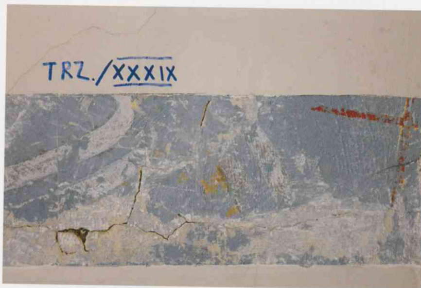
Fot. 7. Prezbiterium - sklepienie, widoczna odkrywka sondażowa do badań konserwatorskich. Spękany i odspojony tynk z warstwą malarską. Fotografia z 2024r.
