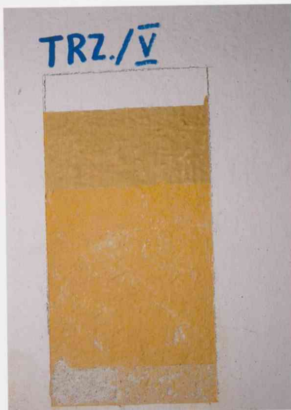
Fot. 11. Nawa główna – ściana, widoczna odkrywka sondażowa do badań konserwatorskich. Przemalowana monochromatyczna warstwa malarska. Fotografia z 2024r.
