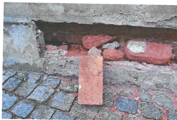
Widok cegły szamotowej i ceramicznej będącej materiałem zamurowania cokołu.
