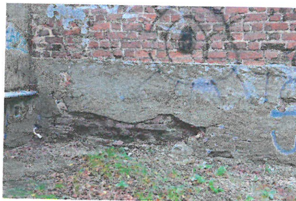
Widok uszkodzonego cokołu na elewacji północnej.
